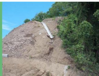
Erosión al final del tramo construido de la contracuneta instalada en la estación 12+700
