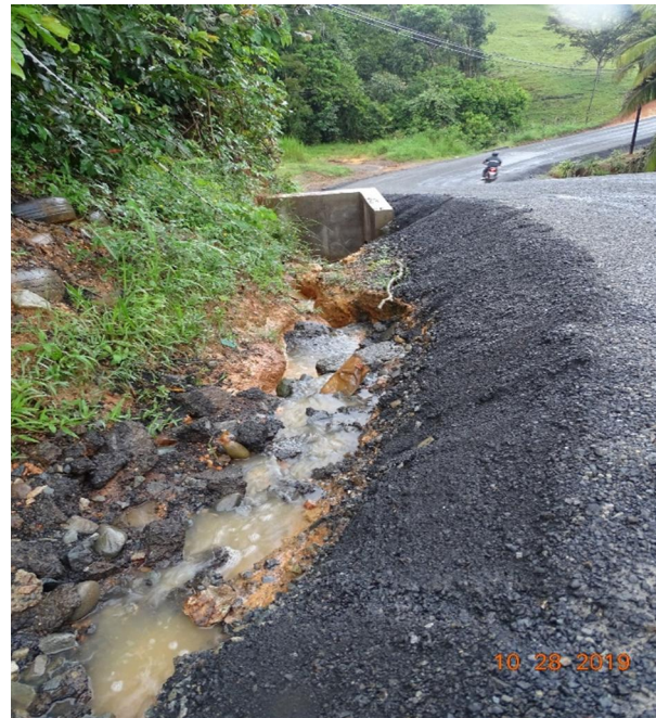
Fotografía 19. Cunetas en tierra sin revestir en sección de la ruta con alta pendiente.
