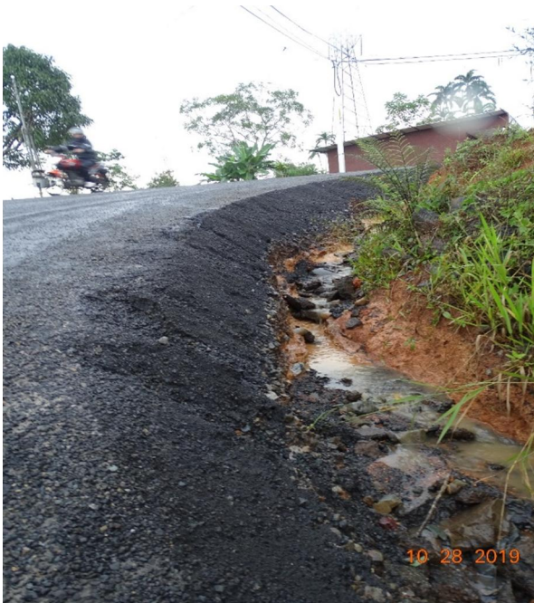
Fotografía 19. Cunetas en tierra sin revestir en sección de la ruta con alta pendiente.
