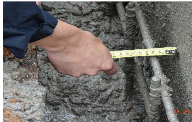
Fotografía 12. Recubrimiento de acero de 3,5 cm respecto a formaleta.
