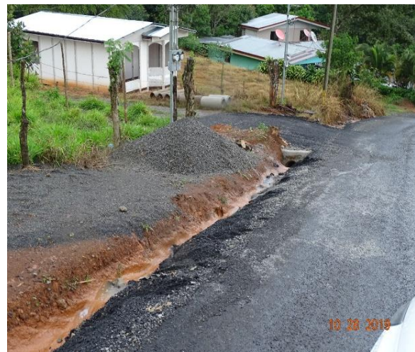
Fotografía 18. Margen izquierdo de la ruta sin canal revestido. Ubicación: Ruta Nacional 334, km 5+780. Sección de control 11050,
