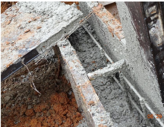
Fotografía 12. Recubrimiento de acero de 3,5 cm respecto a formaleta.
