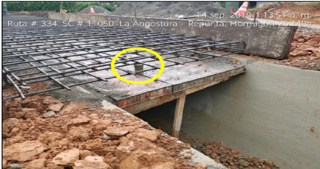
Fotografía 14. Utilización de separadores de morteros.
