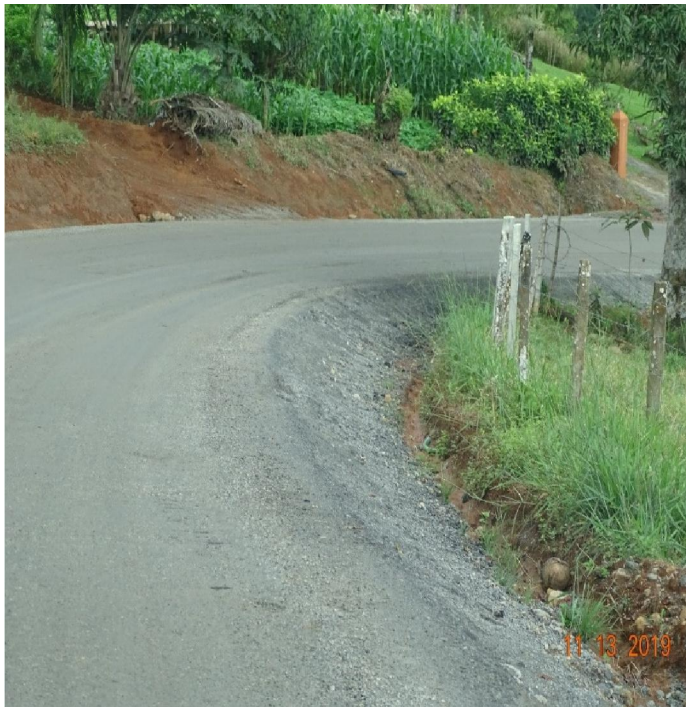
Fotografía 21. Márgenes de la ruta sin revestir en sección de ruta con pendiente de 15,66%. Ubicación: Ruta Nacional 334, km 7+490. Sección de control 11050, Angostura (cementerio) - Repunta (RN2). Fecha: 13 de noviembre de 2019. Fuente: LanammeUCR
