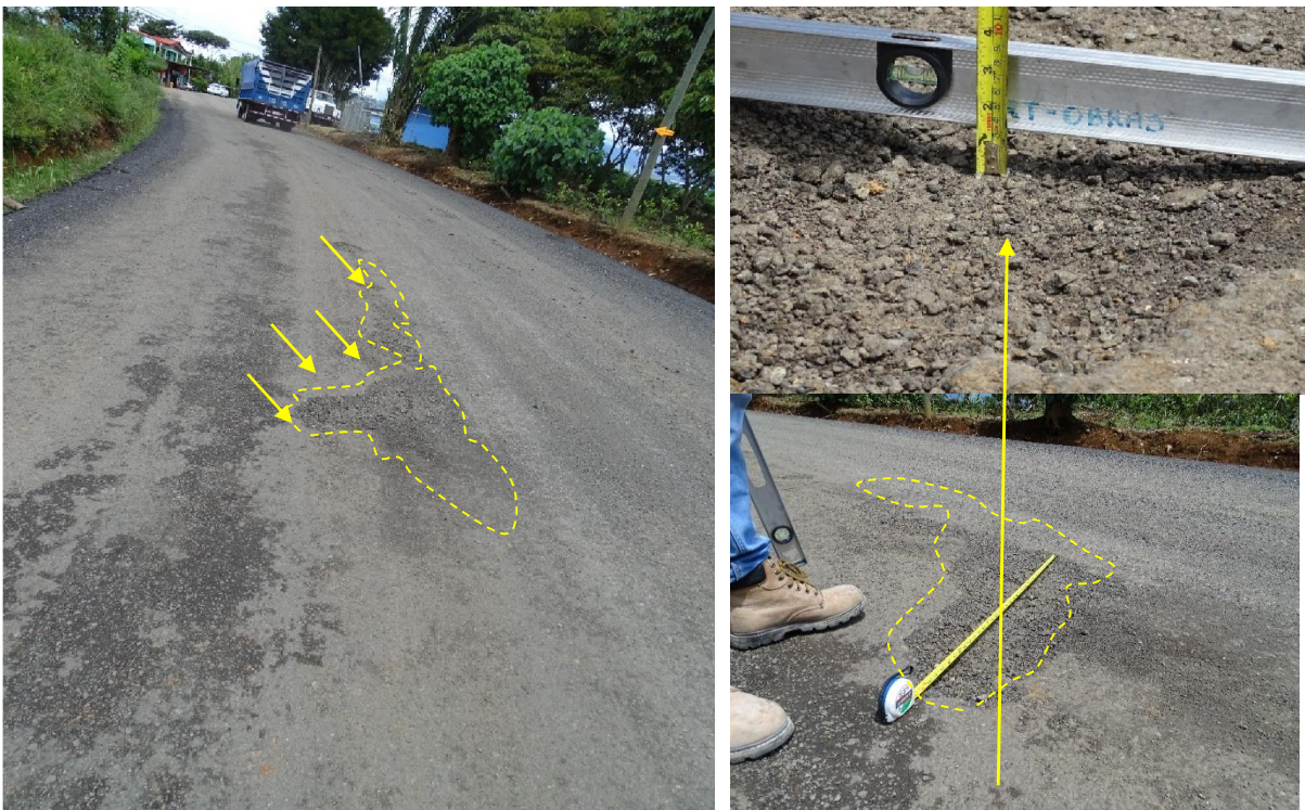
Fotografía 7. Deterioros capa de ruedo con perfilado, espesor de hasta 3,5 cm y diámetro de 80 cm. Ubicación: Ruta Nacional 334, km 0+220. Sección de control 11043, Ceniza (Cruce Bajo Esperanza, plaza) – Angostura (cementerio). Fecha: 9 de octubre de 2019. Fuente: LanammeUCR
