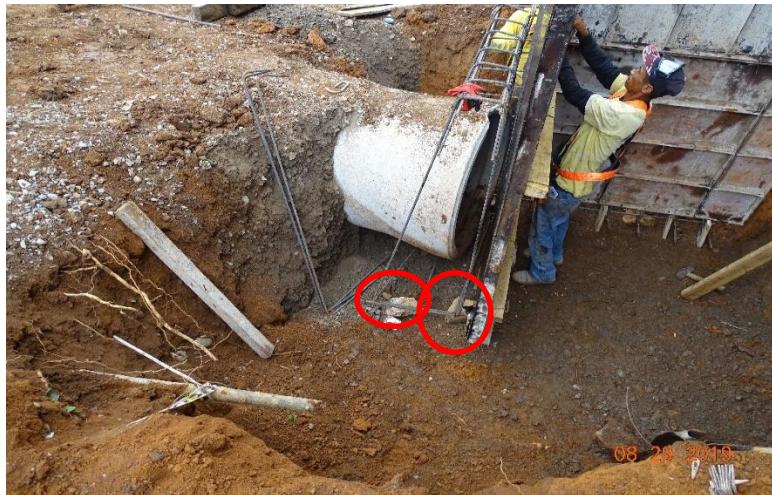
Fotografía 13. Utilización de piedras como separación entre armadura y suelo.
