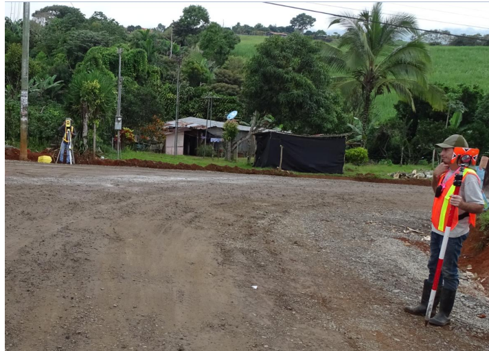
Fotografía 1. Utilización de topografía para levatamiento de rasante.
