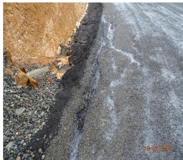
Fotografía 22. Deterioros en borde de vía, ausencia de canal revestido. Ubicación: Ruta Nacional 334, km 7+620. Sección de control 11050, Angostura(cementerio)- Repunta (RN2). Fecha: 28 de octubre y 13 de noviembre de 2019. Fuente: LanammeUCR
