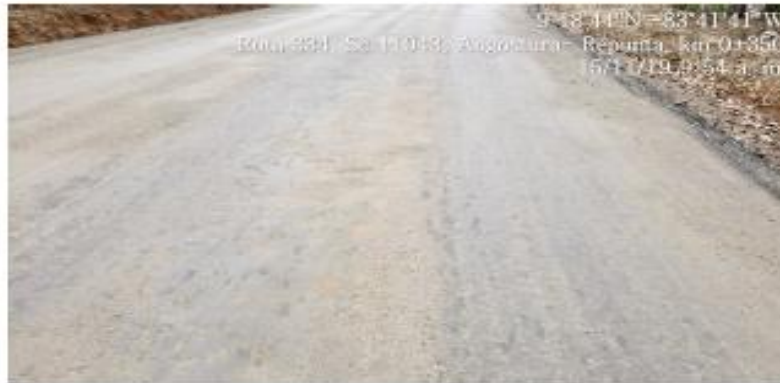
Fotografía 4. Detalle de correcciones realizadas sobre el sello de preservación por cuenta del contratista.
