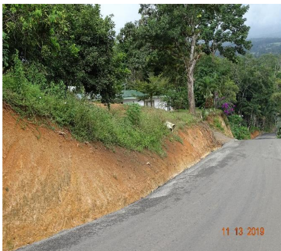
Fotografía 22. Deterioros en borde de vía, ausencia de canal revestido. Ubicación: Ruta Nacional 334, km 7+620. Sección de control 11050, Angostura(cementerio)- Repunta (RN2). Fecha: 28 de octubre y 13 de noviembre de 2019. Fuente: LanammeUCR
