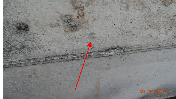
Fotografía 11. Varilla utilizada como separador en acabado de cabezal.
