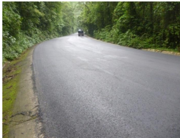
Figura 16. Bacheo a profundidad parcial realizado en la Ruta 32, Sección de Control 10990. Fecha: 23 de mayo de 2017. Fuente: LanammeUCR, 2017.
