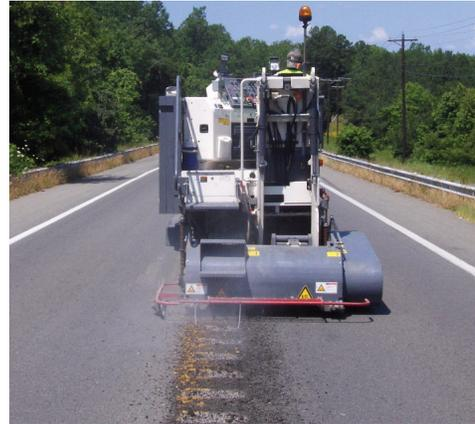
Figura 9. Conformación de bandas sonoras mediante fresado.
