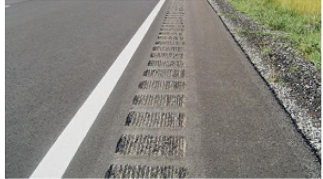
Figura 2. Bandas sonoras conformadas al lado de una vía de circulación.
