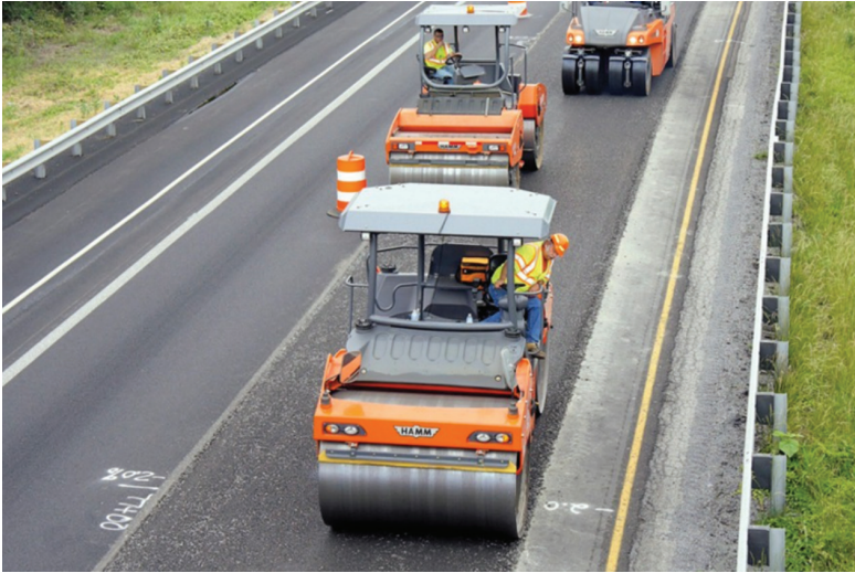
Figura A5.4. Compactación final (Wirtgen GmbH, 2012).
