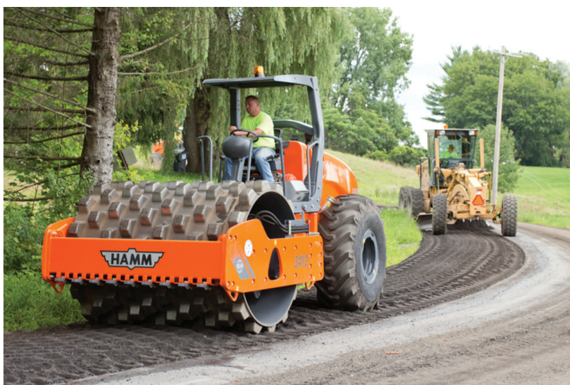
Figura A5.3. Compactación primaria (The Gorman Group, LLC, s.f.).
