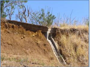
**OBSERVACIONES:** Cuneta sin soporte en talud de corte LD, salida hacia Siguiares.
