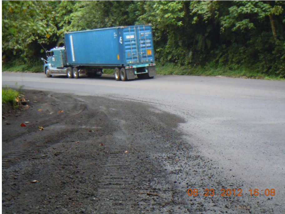
Fotografía 42. Agregado suelto sobre los carriles de ascenso producto de la colocación de material de perfilado no compactado en zona de descanso. Ubicación: Zona 1-1San José, Ruta Nacional 32, aprox. km 34+300. Fecha: 23 de agosto de 2012.
