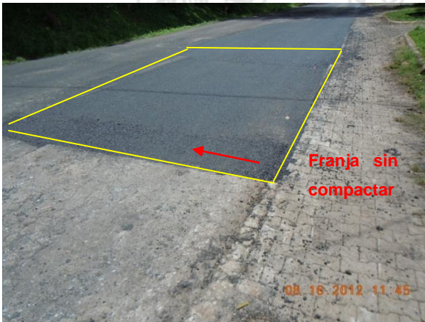
Fotografía 14. Bacheo con volumen faltante de mezcla asfáltica.
