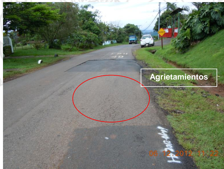
Fotografía 10. Se observan deterioros junto a zona bacheada Ubicación: Zona 1-4 de Alajuela, Ruta Nacional 135, Bo. San José Sur. Fecha: 12 de junio de 2012.
