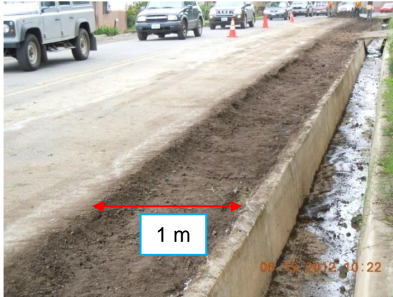
Fotografía 1. Área con tierra que se rellenó posteriormente con mezcla asfáltica. Se observa ausencia de material granular.
