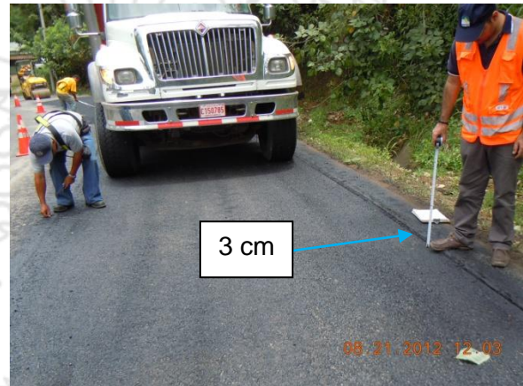
Fotografía 31. Espesor de 2da. capa de 3cm. Ubicación: Ruta Nacional 10, aprox. 500 de Cementerio hacia Turrialba. Fecha: 21 de junio de 2012.
