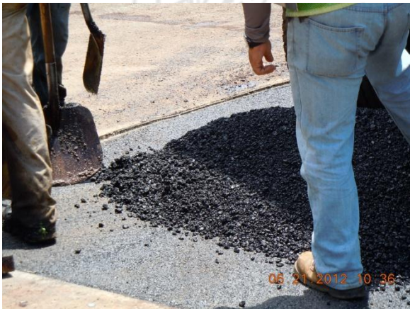
Fotografía 30. Espesor de 2da. capa de 3cm. Ubicación: Ruta Nacional 119, aprox. km 2+00 desde intersección R.N. 3 (Bomba Pacific). Fecha: 21 de junio de 2012.
