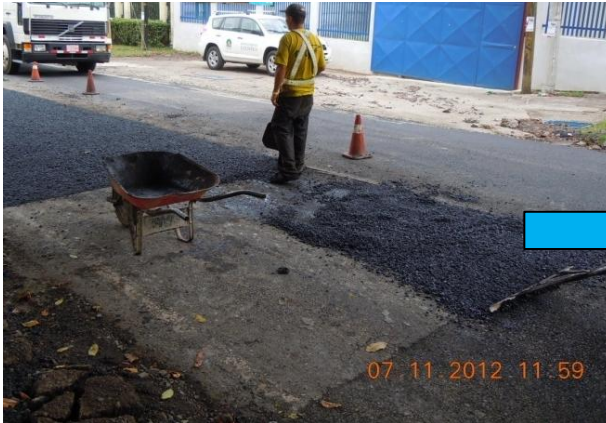
Fotografía 28. Colocación de espesor de mezcla asfáltica menor a 4cm. Ubicación: Ruta Nacional 136, intersección con Ruta Nacional 3. Fecha: 11 de julio de 2012.
