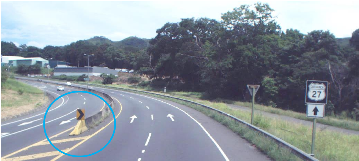
Figura 7. Mediana de concreto en Radial Atenas, inmediatez a la estación 30+850 Nota: Generado a partir de levantamiento GEO-3D. UGERVN, 2018.
