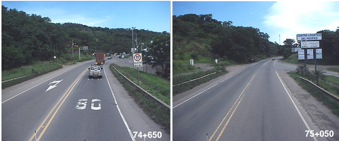
Figura 21. Accesos a centros de carga sin carriles de aceleración y desaceleración Nota: Generado a partir de levantamiento GEO-3D. UGERVN, 2018.
