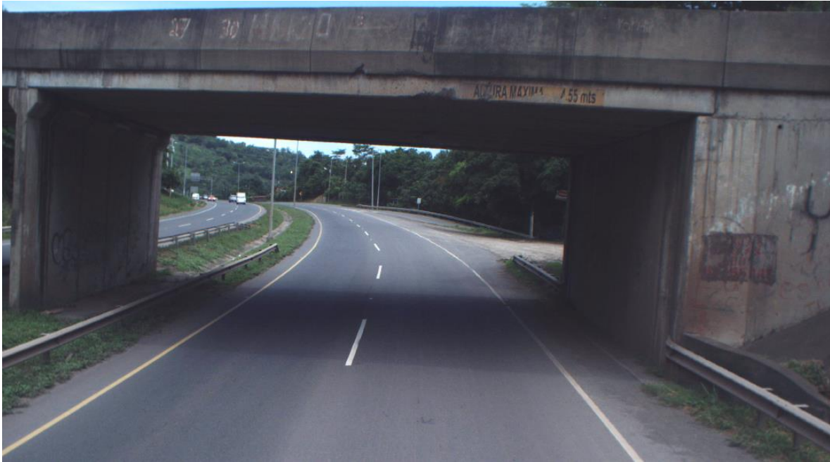
Figura 20. Base de paso a desnivel con Ruta Nacional 622, inmediación a la estación 74+100 Nota: Generado a partir de levantamiento GEO-3D. UGERVN, 2018.
