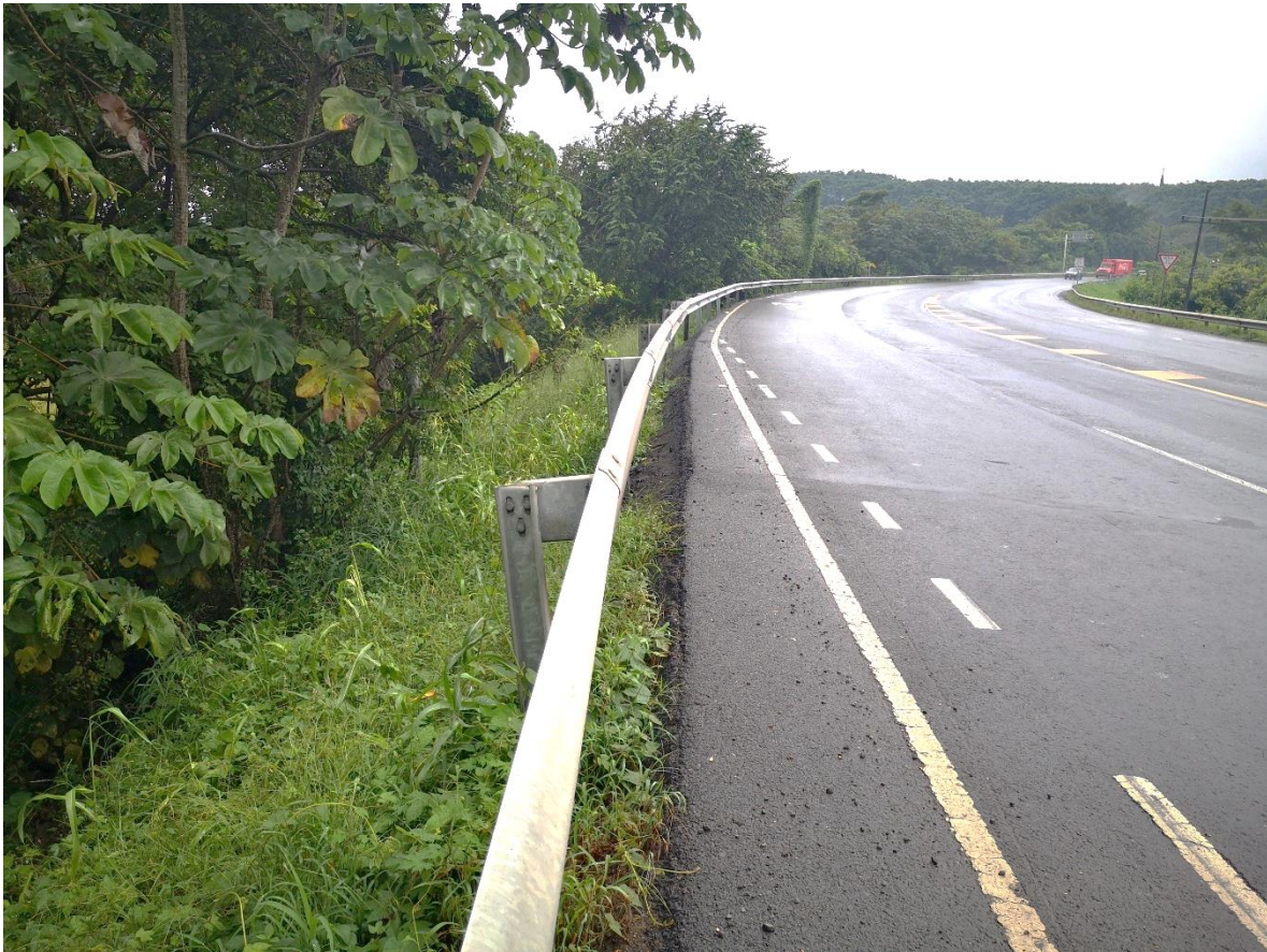
Figura 15. Sistema de contención semirrígido, aledaño a conexión con Ruta Nacional 755, inmediación a la estación 71+600
