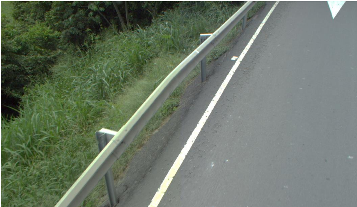
Figura 14. Sistema de contención semirrígido, aledaño a conexión con Ruta Nacional 755, inmediación a la estación 71+600
