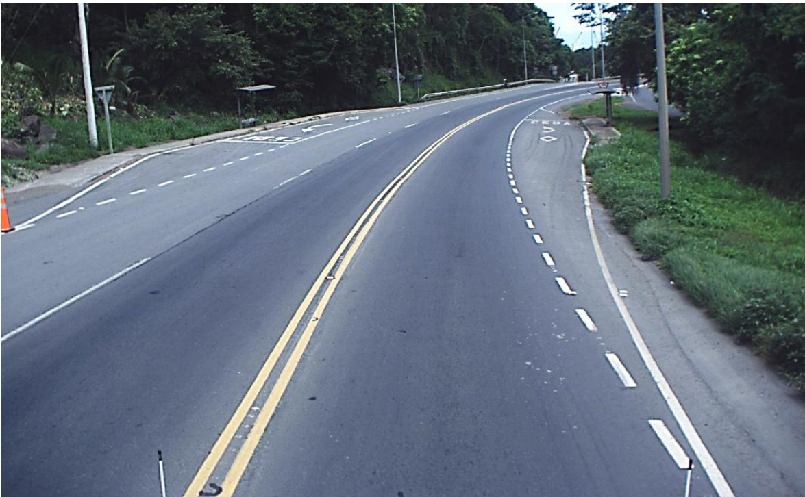
Figura 22. Paradas de autobús en ambas márgenes, inmediación a la estación 76+000 Nota: Generado a partir de levantamiento GEO-3D. UGERVN, 2018.
