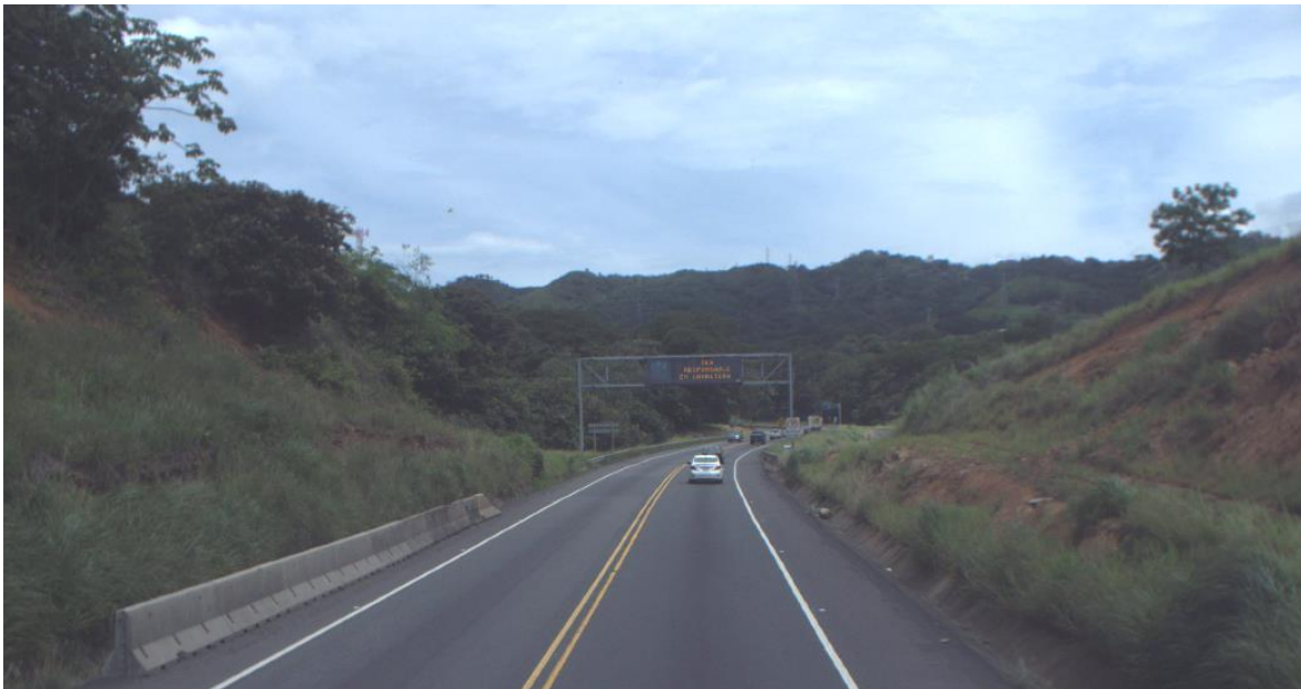
Figura 5. Barrera de concreto aislada y cunetas, inmediación a la estación 30+500
