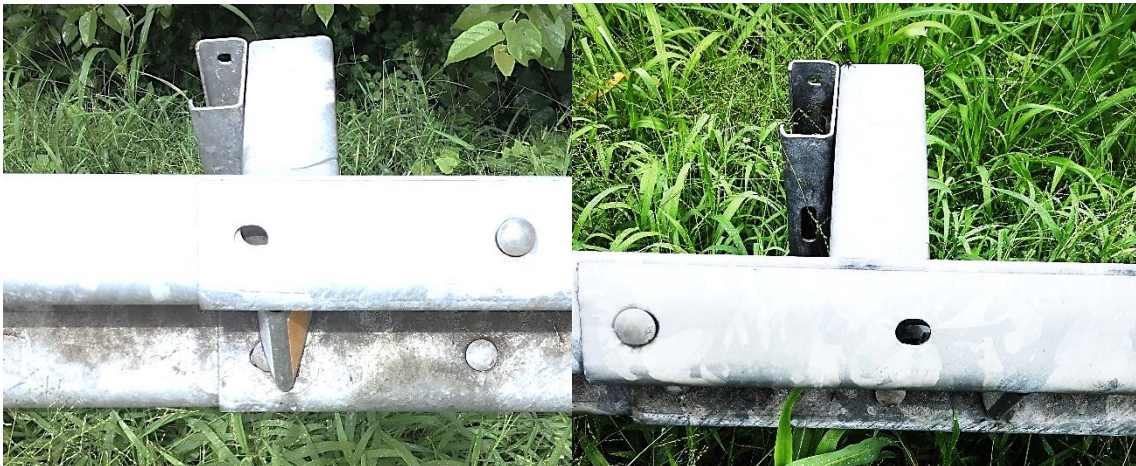
Figura 18. Sistema de contención semirrígido sin pernos aledaño a conexión con Ruta Nacional 755, inmediación a la estación 71+600
