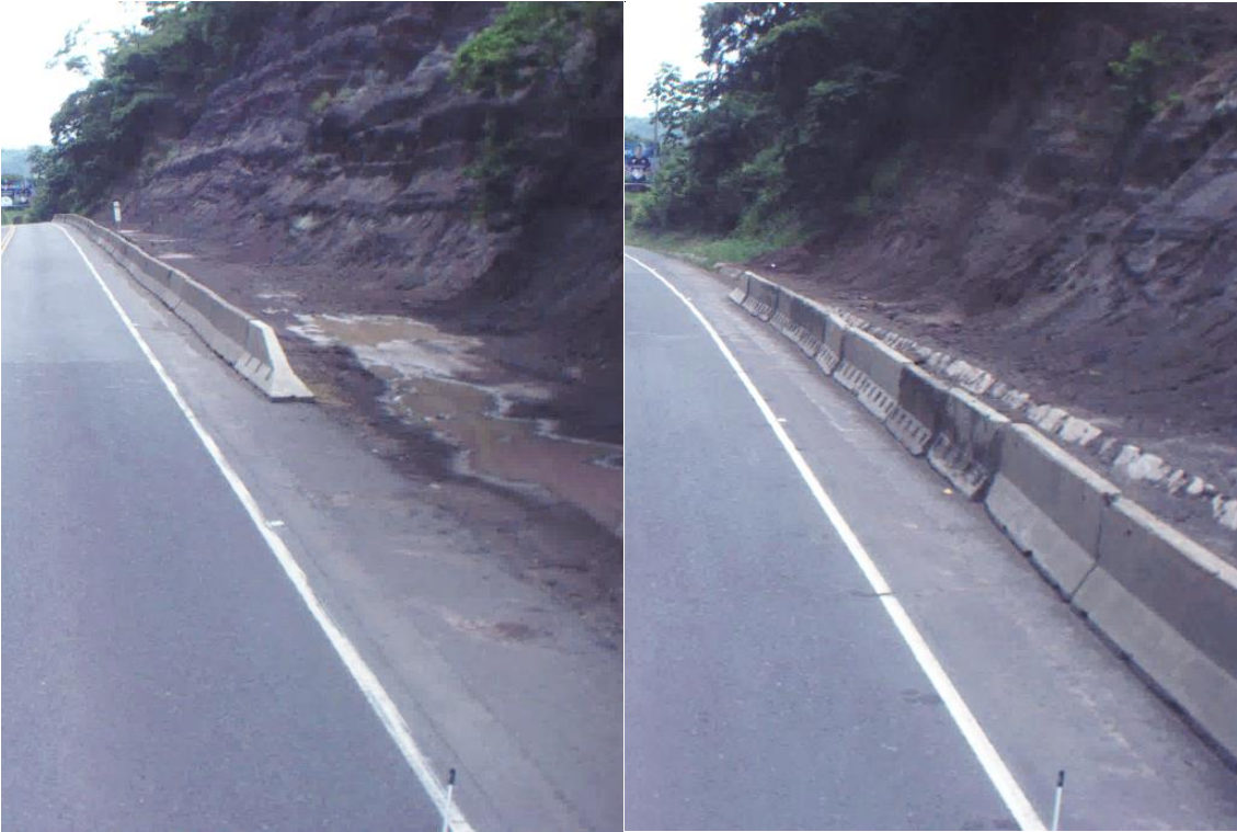
Figura 19. Barreras de concreto en zona de trabajo, inmediación a la estación 72+800 Nota: Generado a partir de levantamiento GEO-3D. UGERVN, 2018.
