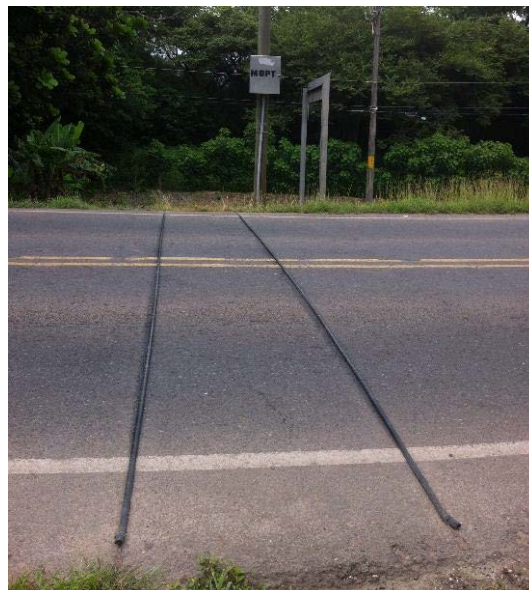
Figura 1. Colocación de mangueras para el conteo vehicular
