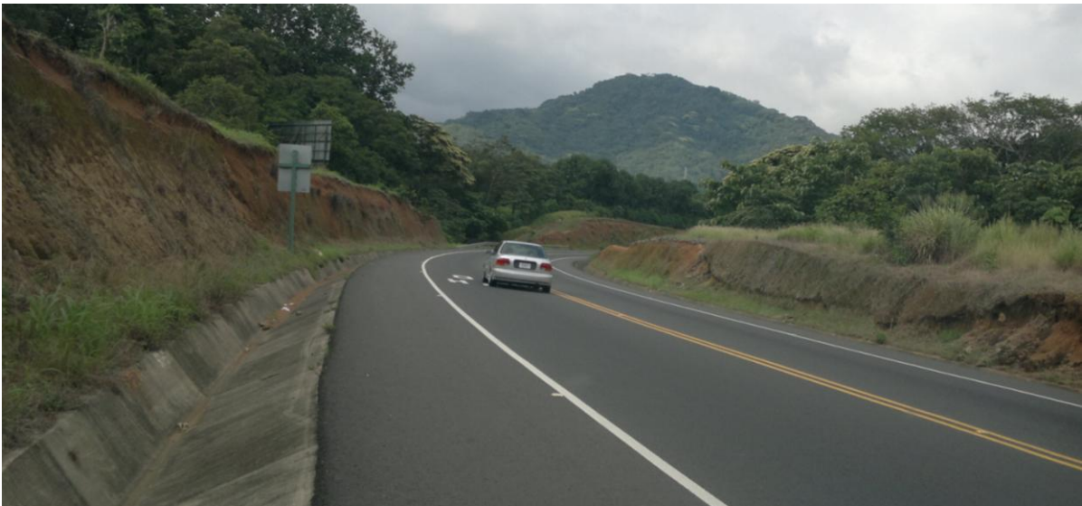
Figura 2: Estacionamiento 50+500, visto en el sentido Caldera – San José
