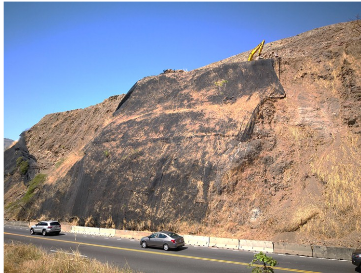
Figura 59: PK 37+500 Intervención en ejecución en el talud de corte.
