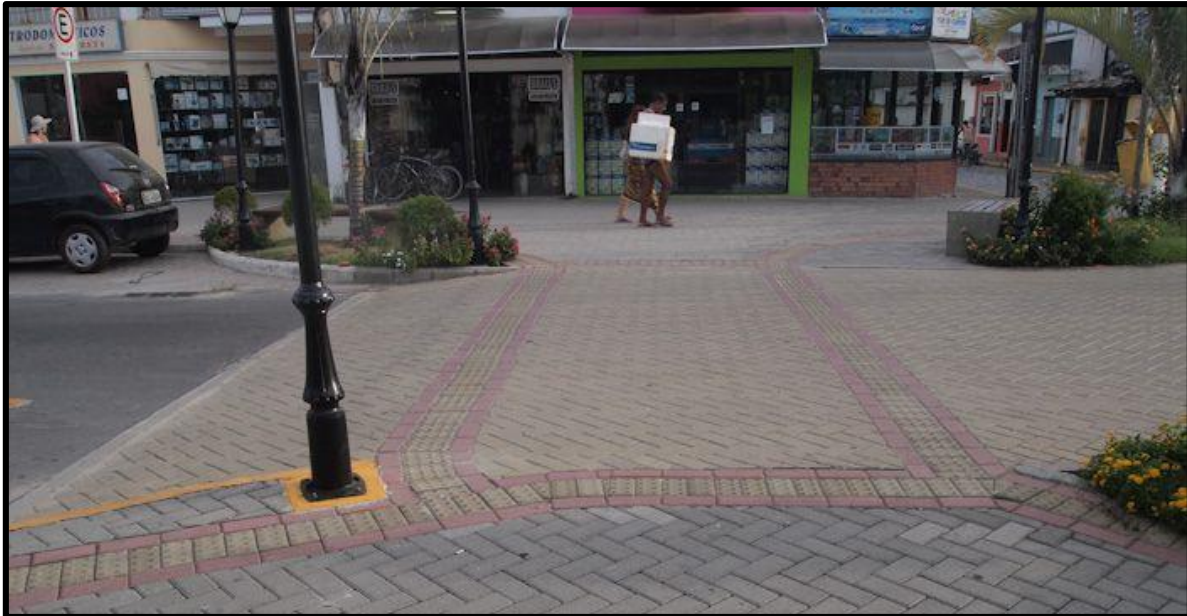
Figura 28. Ejemplo de implementación de mesa peatonal con superficie de ruedo en adoquines
