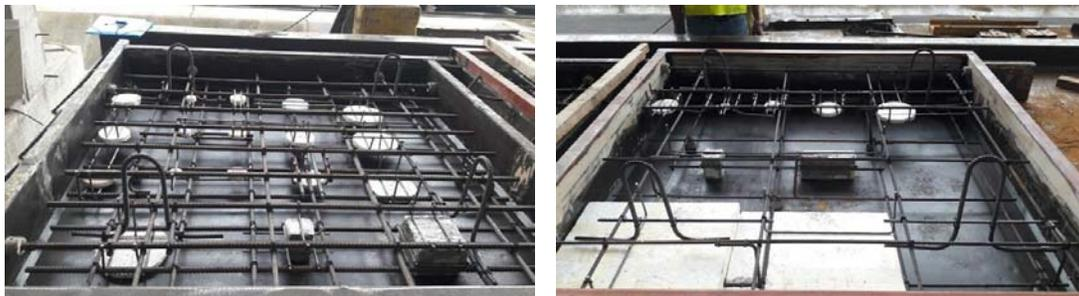
**Figura 6.** Fotografía de la *Losa 1* (izquierda) y de la *Losa 2* (derecha) antes del colado del concreto.
