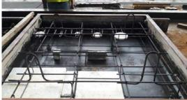
**Figura 6.** Fotografía de la *Losa 1* (izquierda) y de la *Losa 2* (derecha) antes del colado del concreto.
