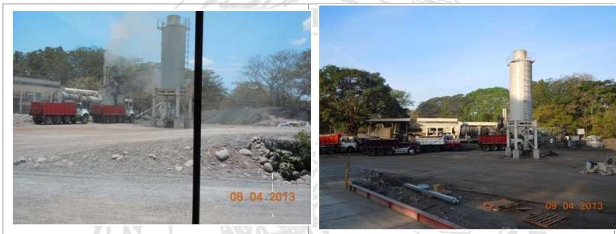
**Fotografía 1** Silo principal para almacenaje de mezcla asfáltica, fuera de servicio.
