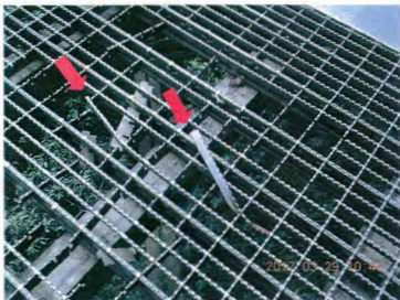
Figura 2. Ejemplo de platinas deformadas con el extremo hacia arriba.
