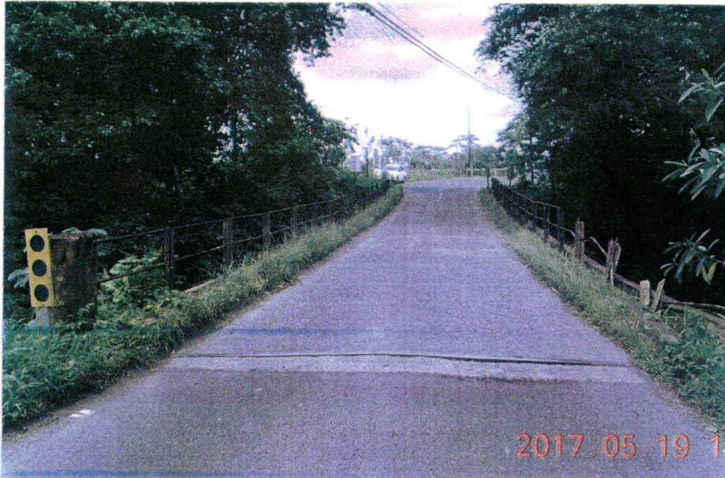
Figura A. Foto de línea de centro para el puente sobre el río Fortuna, ruta No. 141
