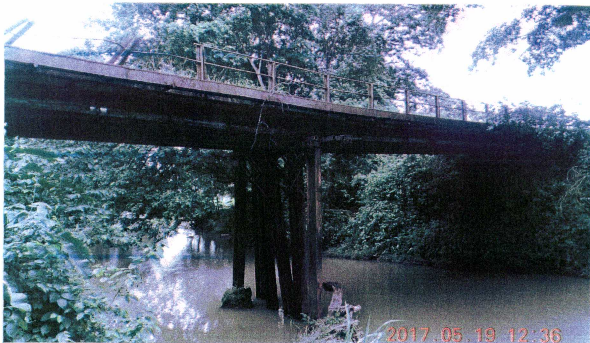
Figura B. Foto lateral para el puente sobre el río Fortuna, ruta No. 141
