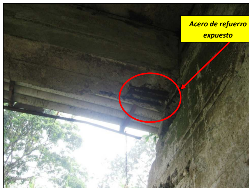
Fotografía 9. Vista del apoyo viga-bastión. (Estado del puente al 19 de mayo de 2010).
