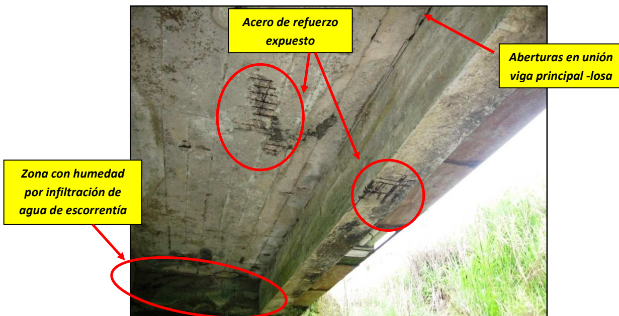
Fotografía 7. Vista inferior del puente sobre Río Platanar. (Estado del puente al 19 de mayo de 2010)
