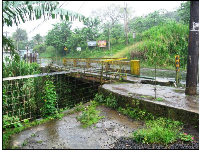
Fotografía 2. Vista lateral del puente sobre el río Platanar. (Estado de puente al 19 de mayo de 2010).
