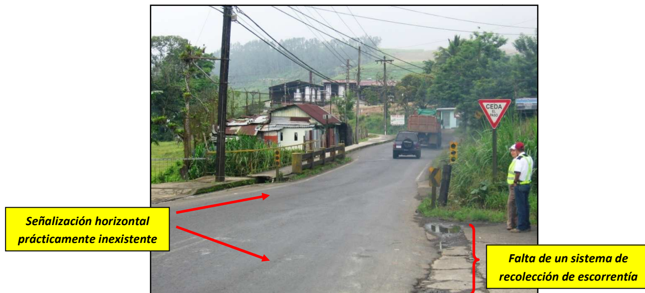
Fotografía 3. Vista general del puente sobre Río Platanar. (Estado del puente al 19 de mayo de 2010).
