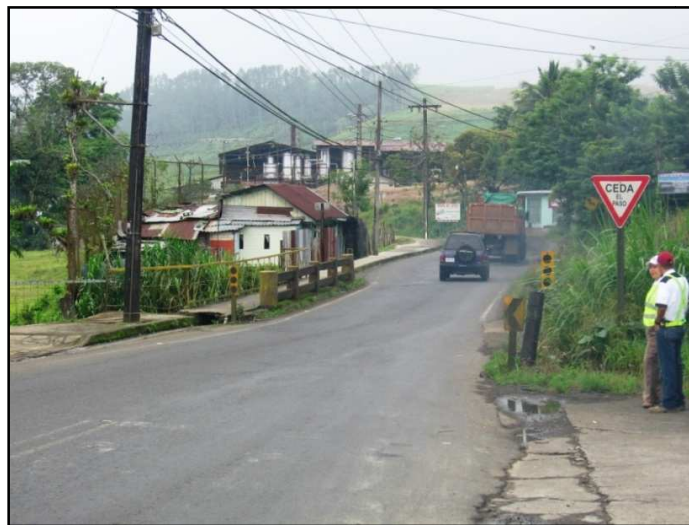
Fotografía 1. Vista general del puente sobre el río Platanar. (Estado de puente al 19 de mayo de 2010).
