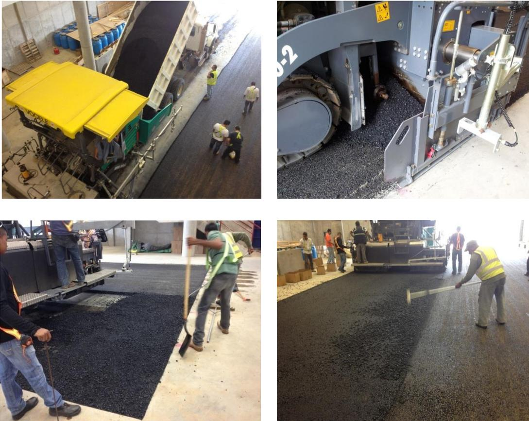
Figura 26. Colocación de la mezcla asfáltica
