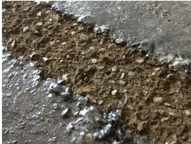
Figura 30. Desprendimiento de la capa de emulsión por el paso de la maquinaria.
