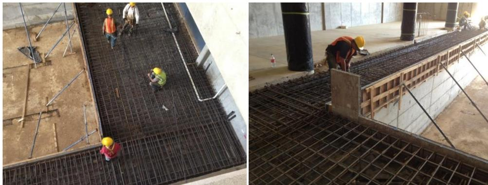
Figura 12. Proceso de construcción del soporte lateral
