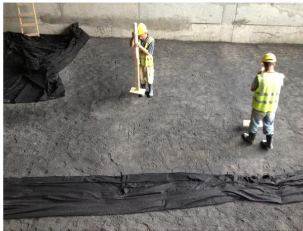
Figura 15. Colocación de capa de material de filtrado colocada.
