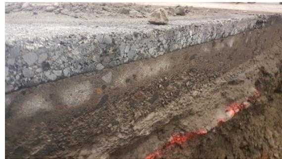
El corte en la estructura se realizó similar al anterior, las capas superiores con la excavadora y las capas inferiores a mano. Con esto se pudo apreciar la condición de las diferentes capas.
