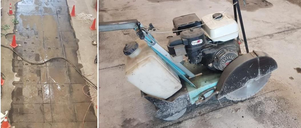
Una vez que los cortes longitudinales y transversales fueron ejecutados desde la superficie, se procedió a levantar el material mediante un retroexcavador, iniciando en el borde Oeste de la fosa hasta el punto donde iniciaban los tramos; este punto se denominó 0+00.
