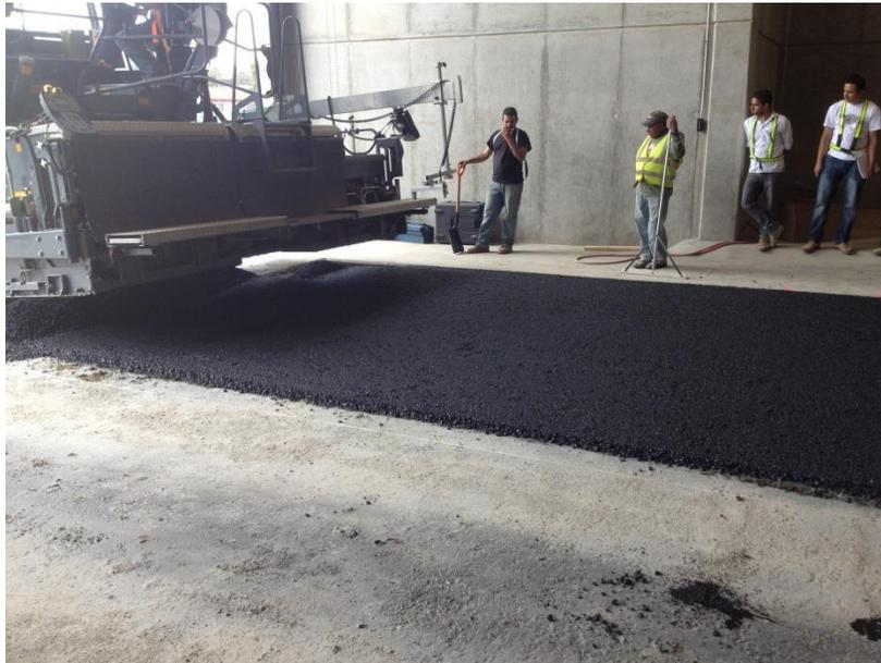
Figura 7. Colocación de la mezcla asfáltica caliente
