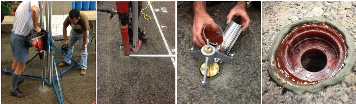
Figura 28. Instalación de los sensores de deformación vertical (MDD).
