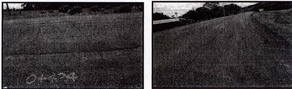
**Ilustración 5** Patrón de agrietamiento presente a lo largo de toda la sección
