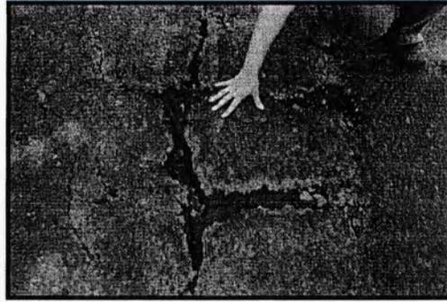
**Ilustración 6** Ancho de grietas de severidad alta
