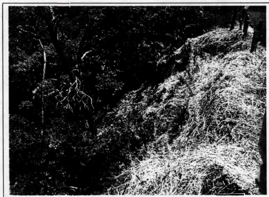
Fotografía 4: Vista del deslizamiento, km 32+500
