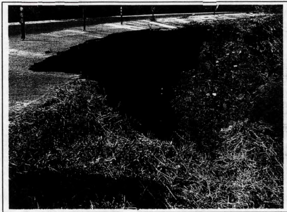
Fotografía 2: Vista del deslizamiento, km 29+200
