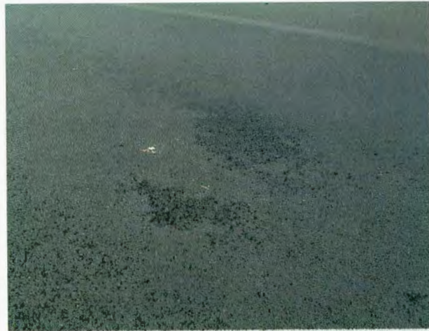
Fotografía 2: Detalle de acabado superficial en sobrecapa.
