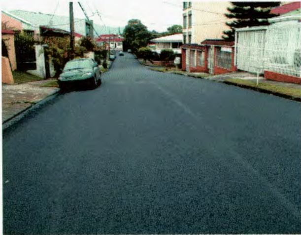
Fotografía 1: Vista general de recarpeteo en cercanías de la U.C.R.
