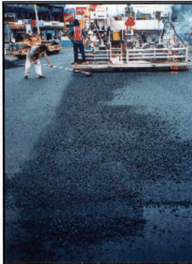
Fotografía 5: Trabajos de colocación de sobrecapa en las cercanías del Super La Cosecha.
