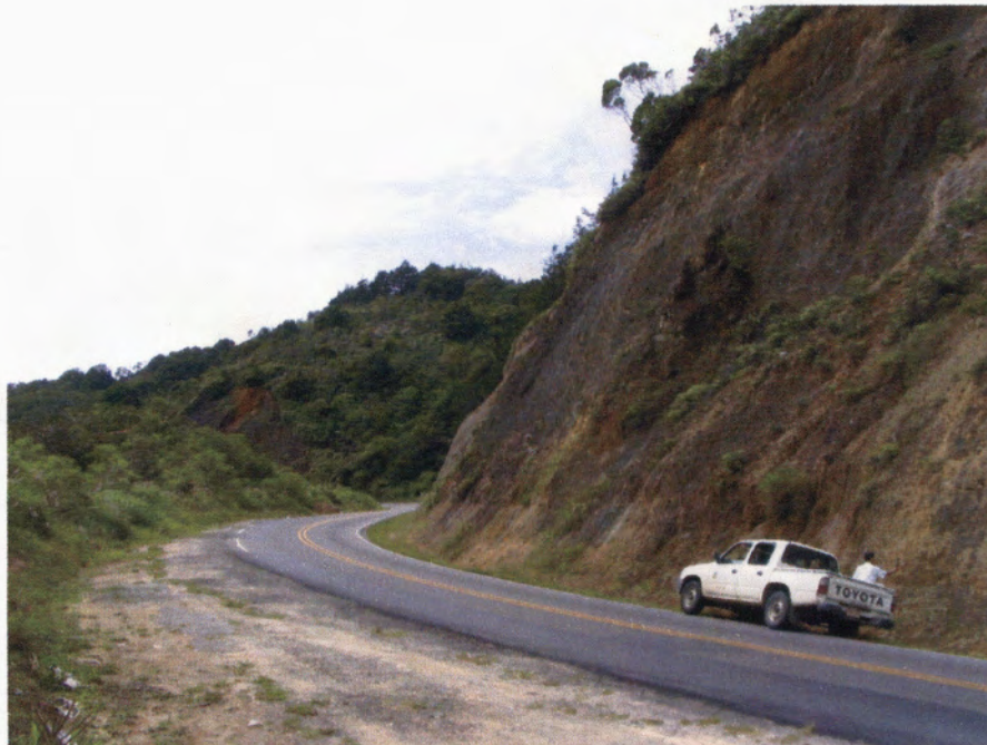
Figura 6: ejemplo de talud de más de 10 metros de altura (estacionamiento 11+000)
