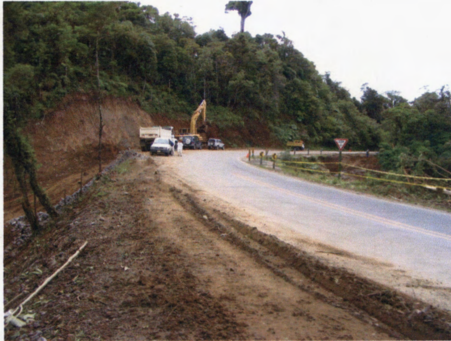
Figura 7: Trabajos en terraplén, estacionamiento 27+200 (7 noviembre 2003)
