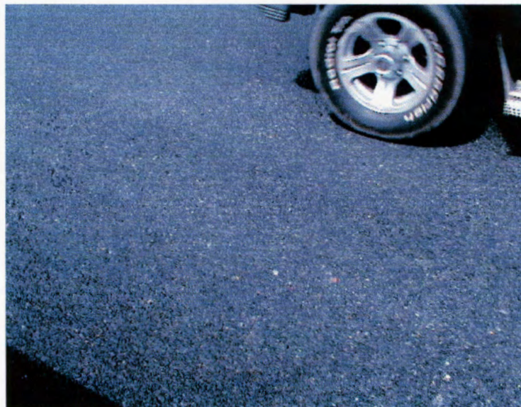
Fotografía F2: Capa de liga colocada lista para colocación de sobre-capas.
