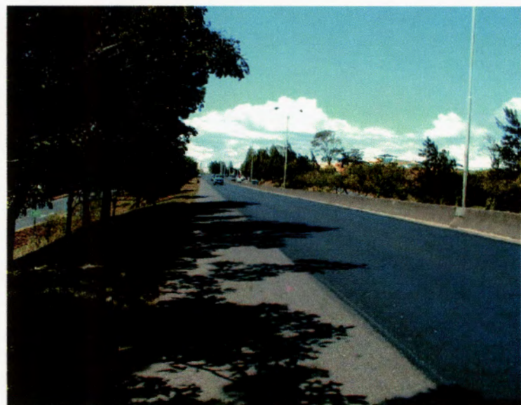
Fotografía F1: Vista general del recarpeteo en las cercanías al Mall Real Cariari.
