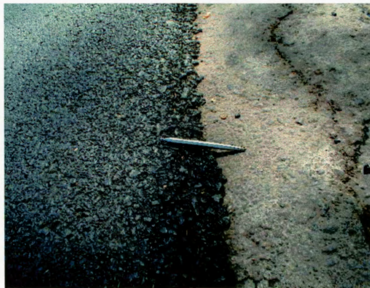
Fotografía F4: Chequeo de espesor de sobre-capa aproximadamente de 5.0 cm y detalle del borde de la sobre-capa.
