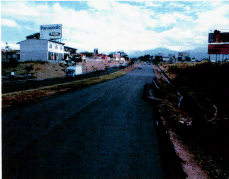
Fotografía F1: Vista general del recarpeteo en las cercanías a la Rotonda de La Y Griega.
