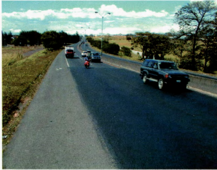
Fotografía F3: Vista general de recarpeteo en las cercanías al Residencial
