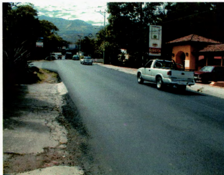
Fotografía F4: Vista general del recarpeteo en las carcanías al cruce de San Rafael de Escazú.
