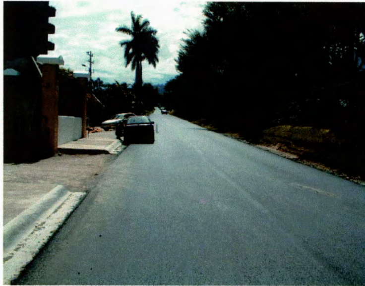
Fotografía F1: Vista general del recarpeteo en las cercanías al Country Club.
