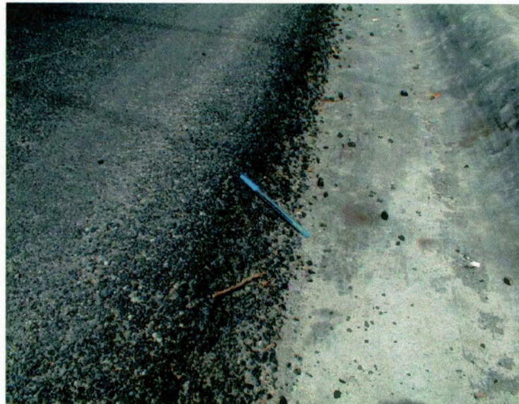
Fotografía F2: Acabado de borde de pavimento y espesor de sobre-capa.
