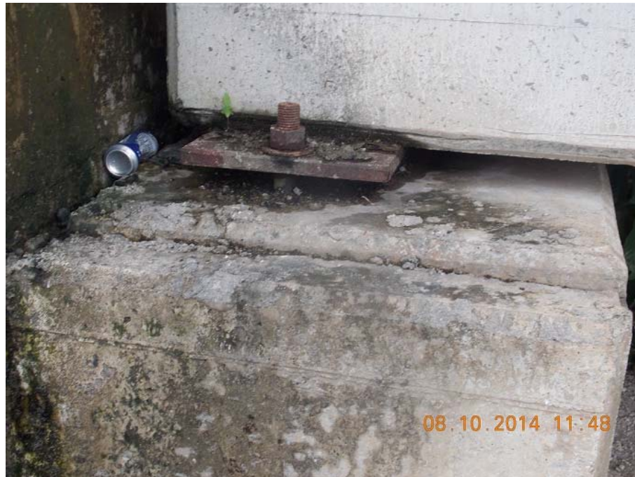
Figura 16: Apoyo en contacto con sedimentos y con oxidación en las piezas metálicas.
