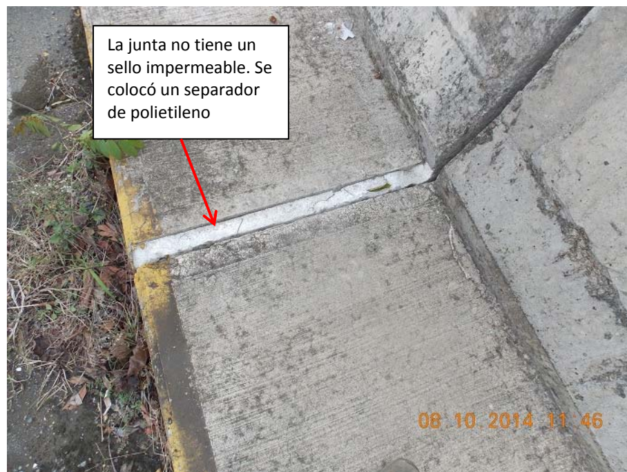
Figura 9: Junta de expansión de las aceras sin un sello impermeable.
