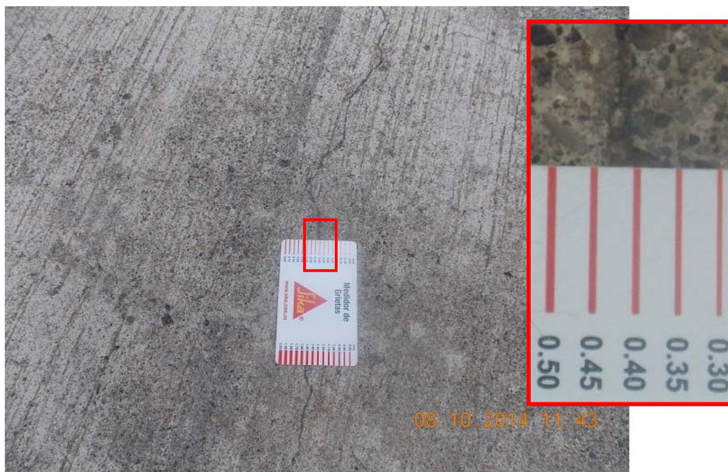
Figura 13: Agrietamiento en una dirección en la cara superior del tablero.
