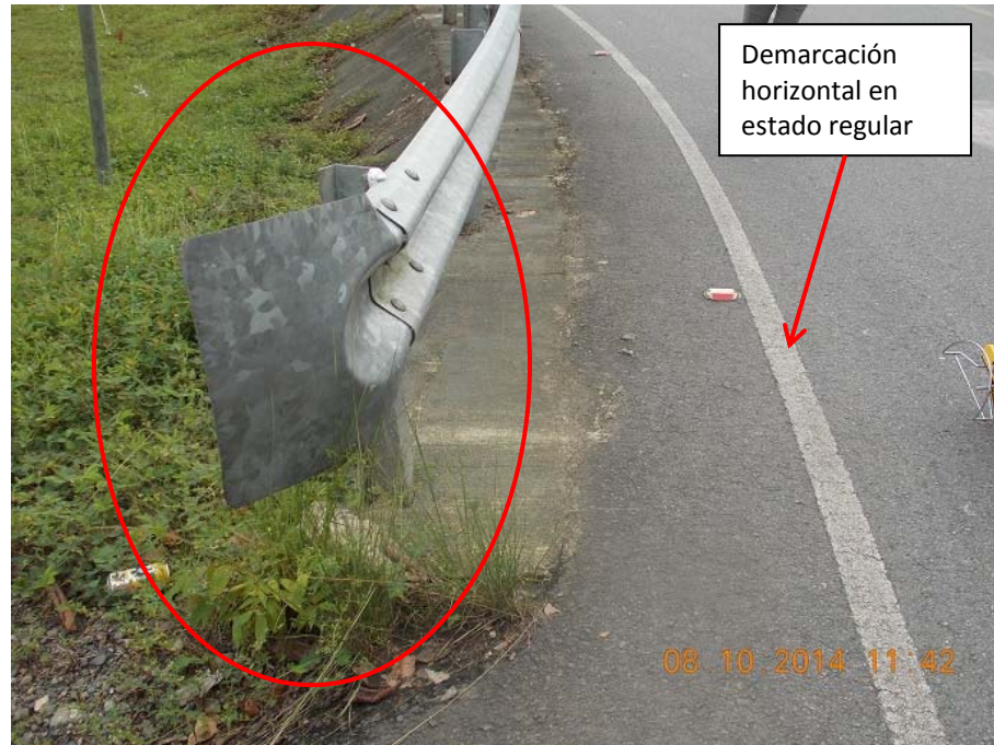
Figura 2: Guardavías con terminación peligrosa. Estado regular de la demarcación horizontal
