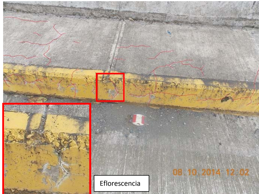
Figura 4: Agrietamiento y eflorescencias en acera del costado este.
