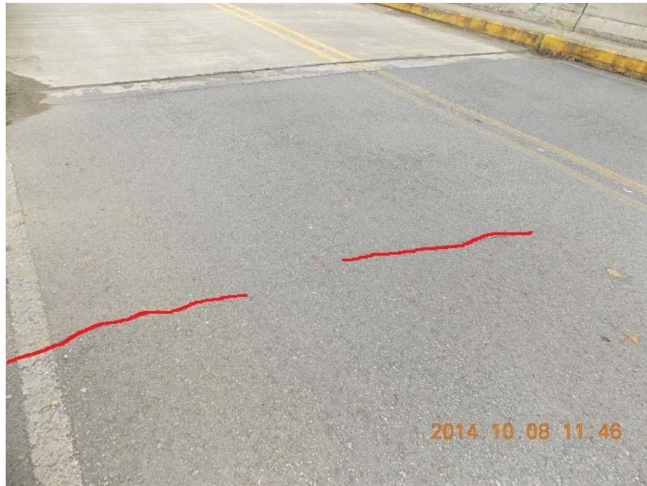
Figura 12: Agrietamiento del pavimento del acceso sur.
