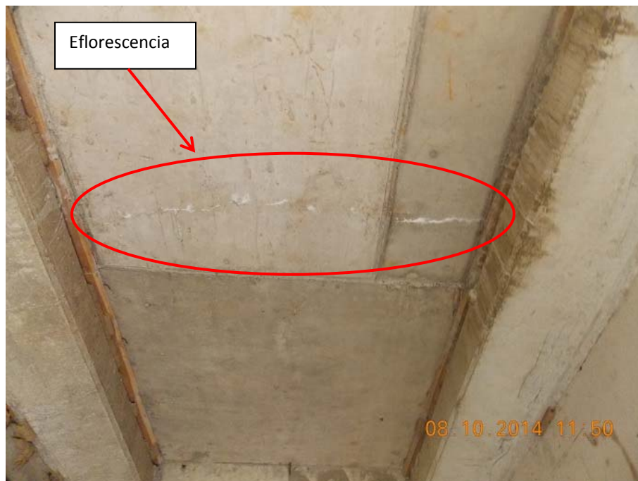
Figura 14: Eflorescencia en cara inferior de la losa del tablero.
