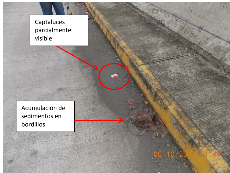
Figura 5: Acumulación de sedimentos en bordillo. El captaluces era parcialmente visible.
