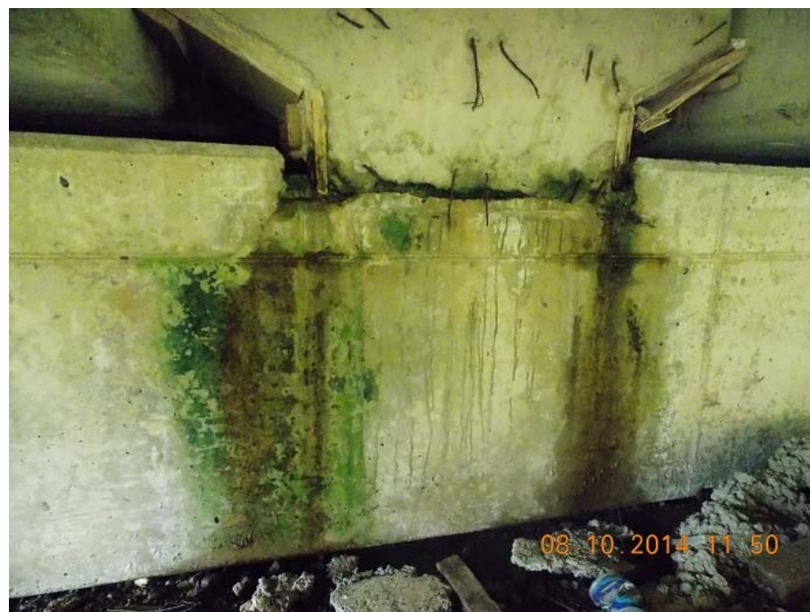
Figura 11: Filtraciones sobre el bastión sur.
