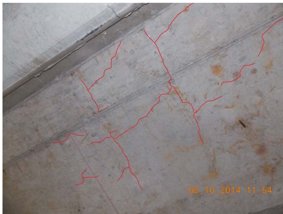
Figura 15: Agrietamiento en dos direcciones en la cara inferior de la losa del tablero.
