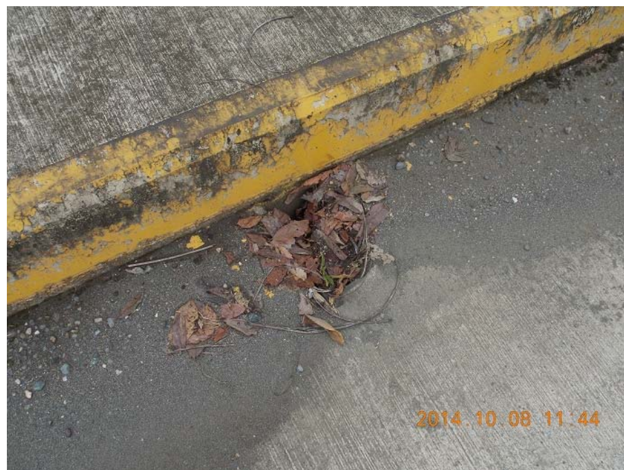
Figura 7: Acumulación de sedimentos y basura en drenaje.
