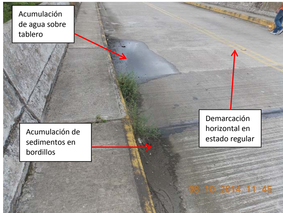
Figura 6: Acumulación de sedimentos y agua en bordillo. Demarcación horizontal regular.
