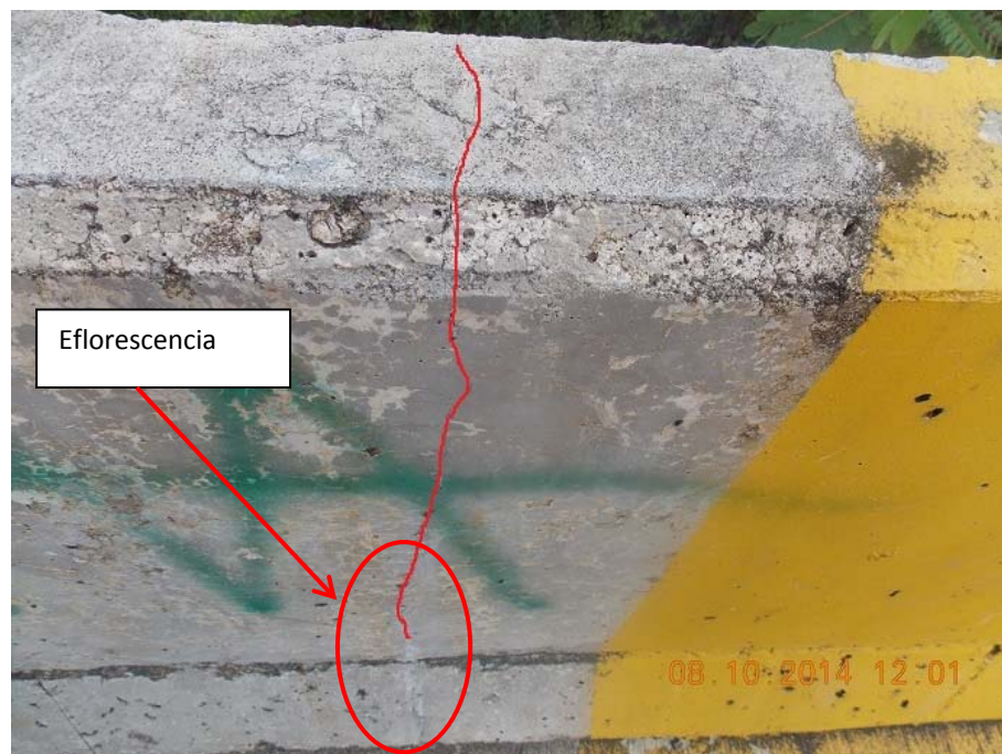
Figura 1: Agrietamiento y eflorescencia en barrera vehicular del costado este
