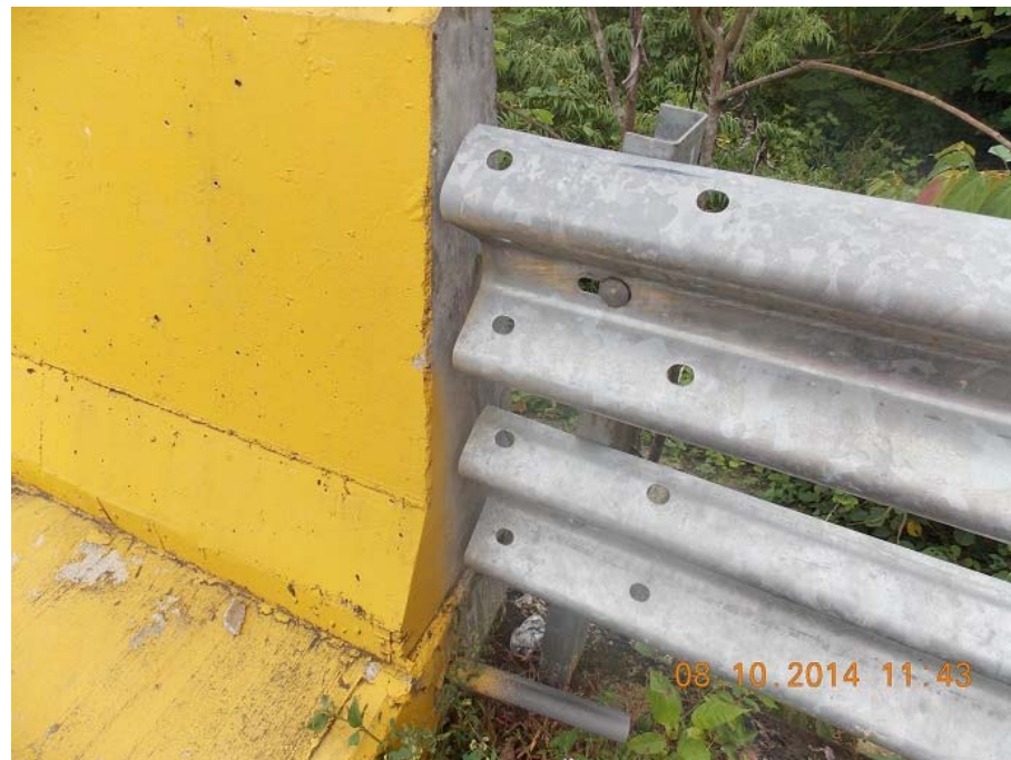
Figura 3: El guardavías no está anclado a la barrera vehicular.
