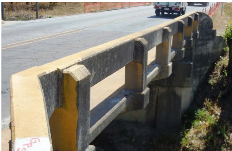
Figura 5: Barrera diseñada de acuerdo con AASHO 1949 que no cumple con los requerimientos de una tipo TL-4 según AASHTO LRFD 2012.
