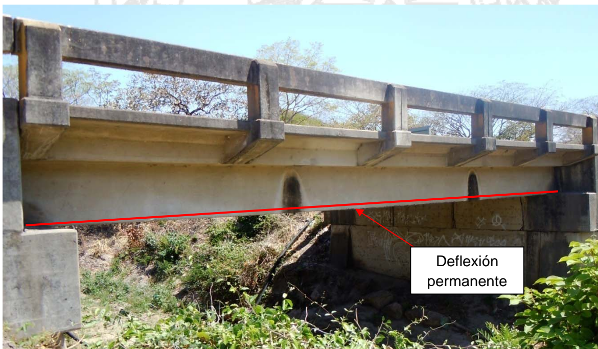
Figura 16: Deflexión permanente de las vigas principales, sentido Liberia-Bagaces.
