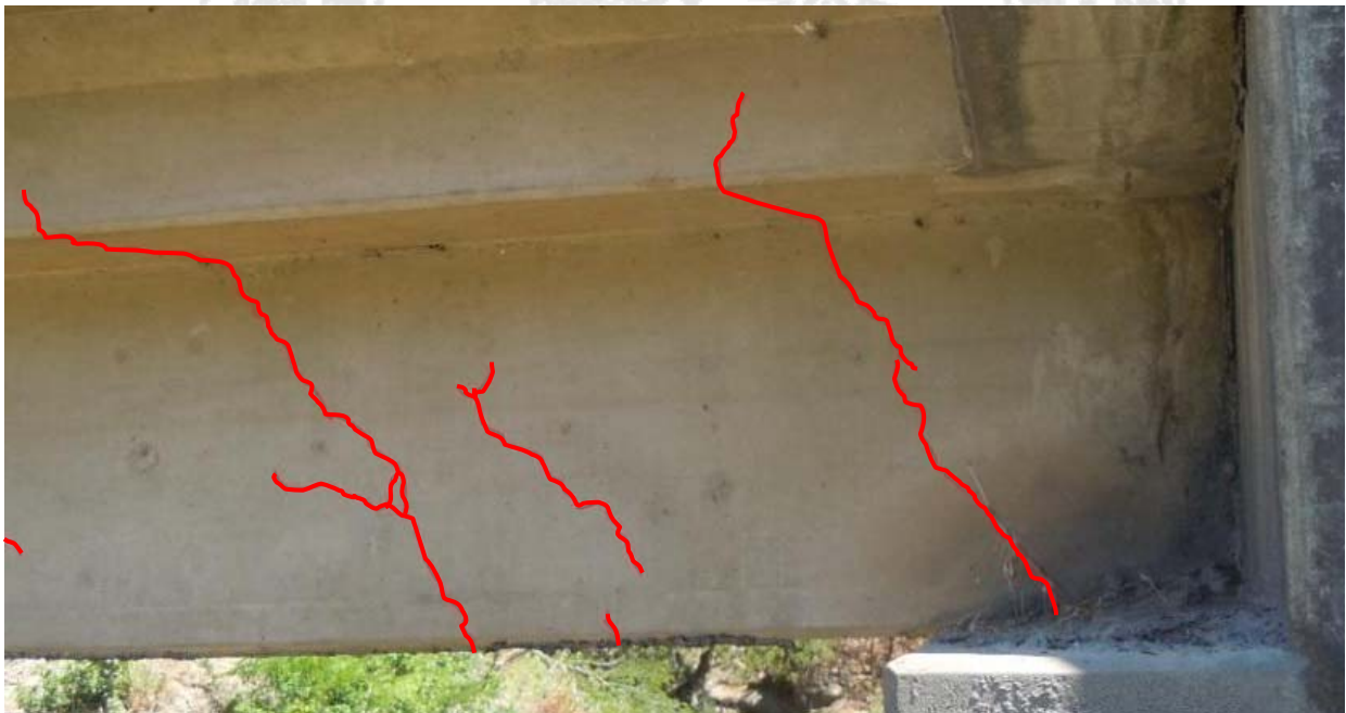
Figura 14: Agrietamiento por cortante en los extremos de las vigas principales.
