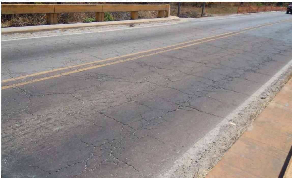
Figura 9: Demarcación horizontal deficiente, mantenimiento inadecuado o ausencia total de captaluces, agrietamiento en red y baches en la superficie de rodamiento.
