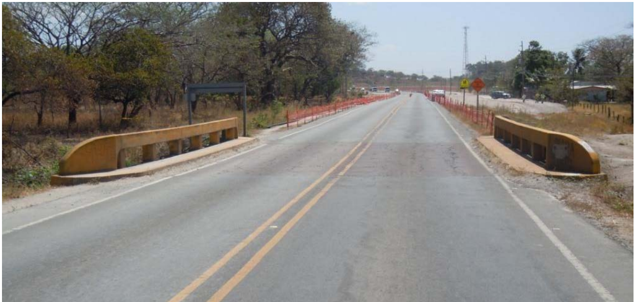
Figura 2: Vista a lo largo de la línea de centro.
