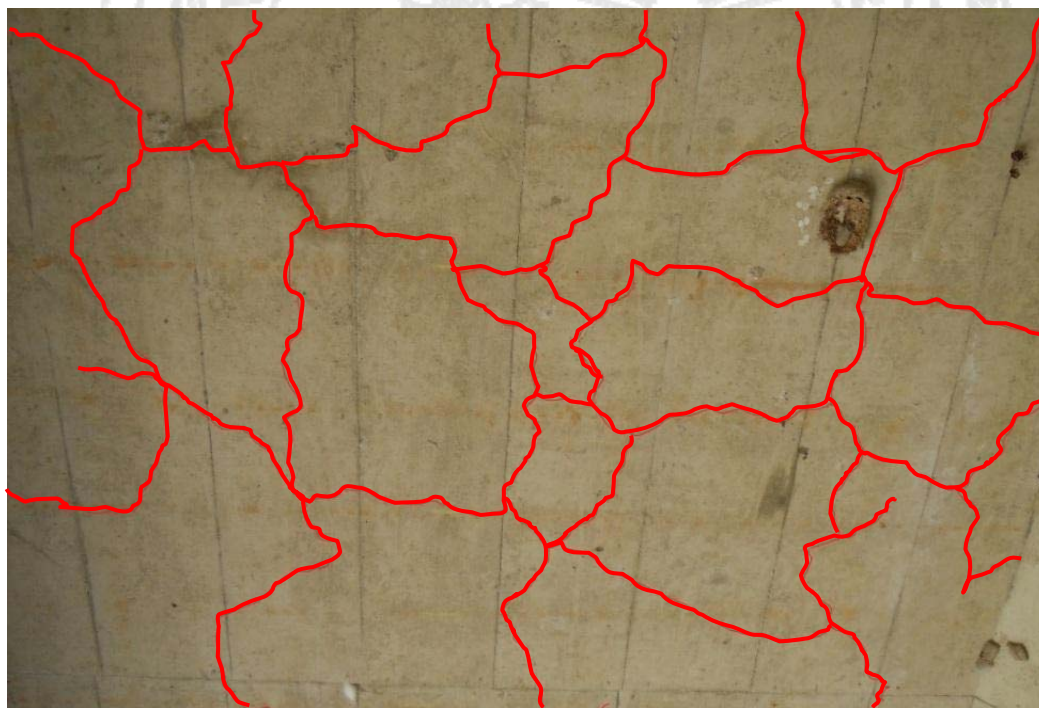
Figura 12: Agrietamiento en red de la superficie inferior de la losa de concreto.
