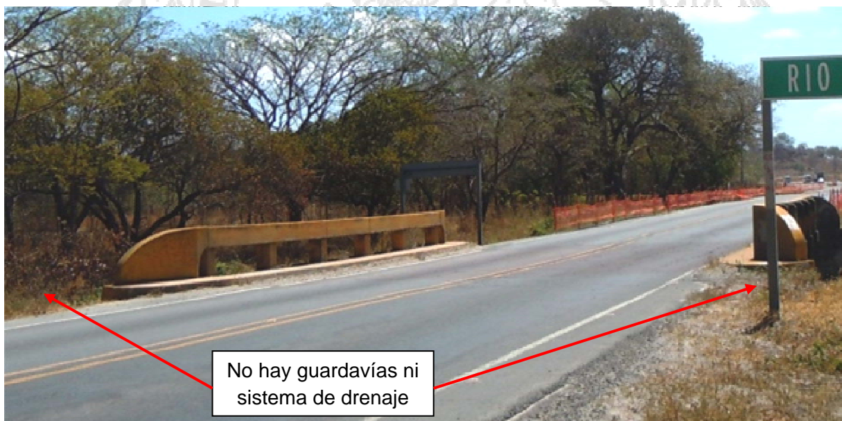
Figura 8: Faltante de guardavías y sistema de drenaje en los accesos, acceso noroeste.
