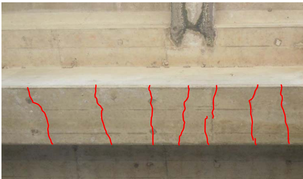
Figura 15: Vista inferior de las grietas por flexión en el centro del claro de las vigas principales.
