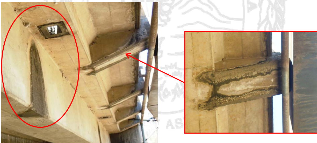
Figura 10: Ductos de drenaje descargaban directamente sobre las vigas principales y filtraciones de agua a través de las barreras.
