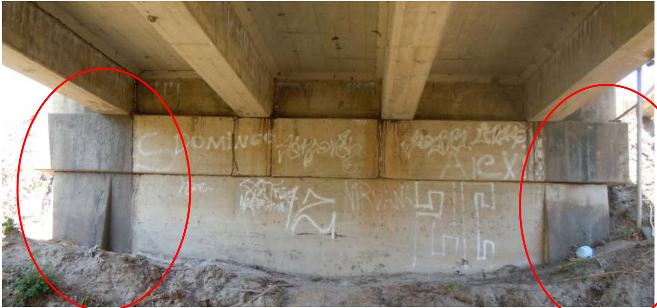
Figura 19: Filtraciones a través de los extremos de las juntas de expansión, caso del Bastión 1 hacia Bagaces.
