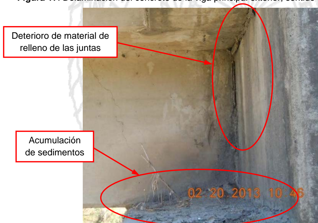
Figura 18: Acumulación de sedimentos en los apoyos y deterioro de material de relleno de las juntas.
