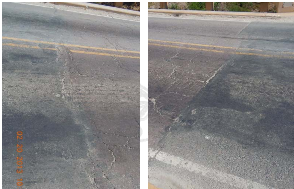
Figura 11: Obstrucción de ambas juntas de expansión y demarcación en los accesos.
