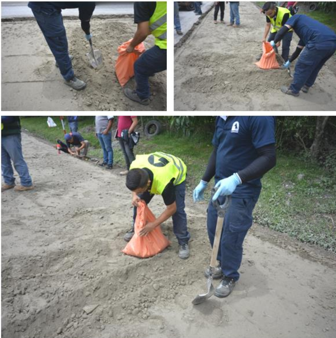
Figura 10. Muestreo de material de base estabilizada en el estacionamiento del km 22+845 después de la colocación con pavimentadora.
