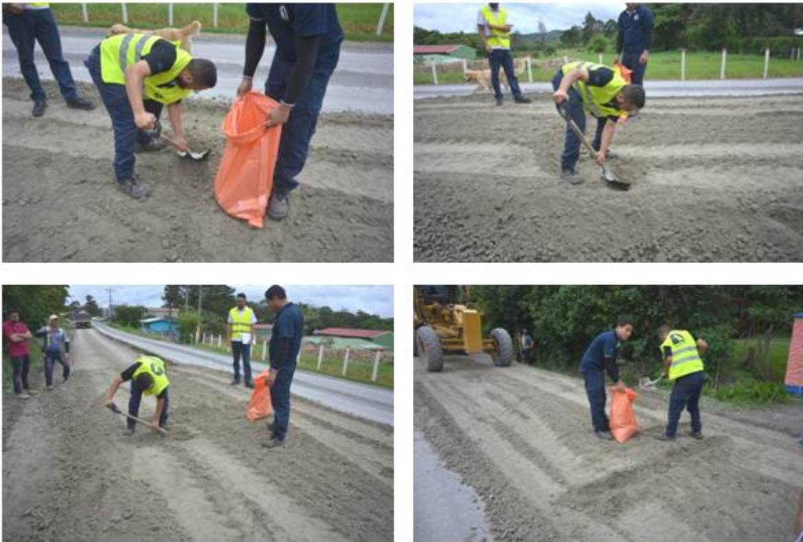
Figura 8. Muestreo de material en sitio de colocación estacionamiento 22+843. En este tramo el Contratista realizó la colocación de la base estabilizada mediante descarga de vagonetas y el paso posterior de una perfiladora.
