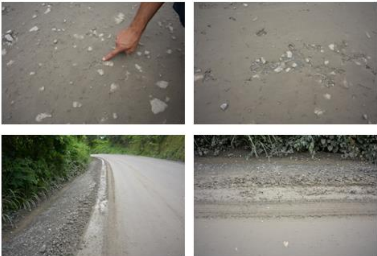
Figura 5. En el estacionamiento del km 11+683 se observa como el material triturado por los vehículos se ha ido acumulando en la superficie y en los bordes de la calzada.
