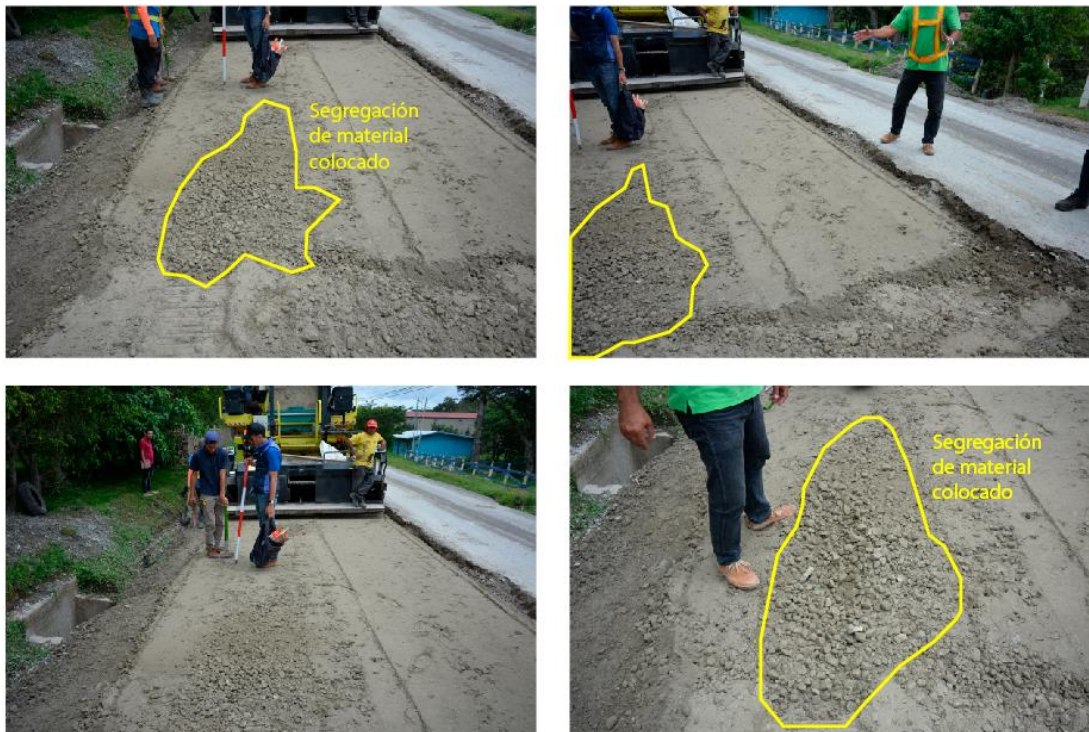
Figura 11. Colocación de base estabilizada en el estacionamiento 22+835. Se puede observar como en el momento de la gira se presentó un problema de segregación del agregado. En varios sectores se puede apreciar la acumulación del material más grueso.
