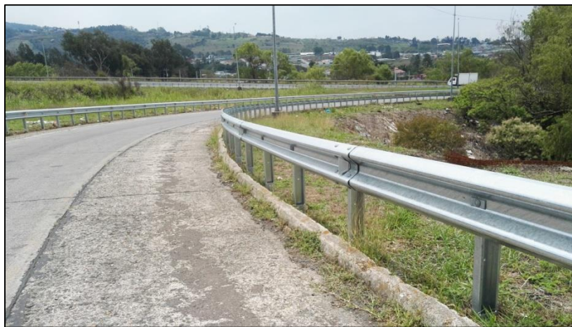
Figura 65. Sistema de contención colocado en la Florencia del Castillo Nota: Fotografía tomada en mayo 2016
