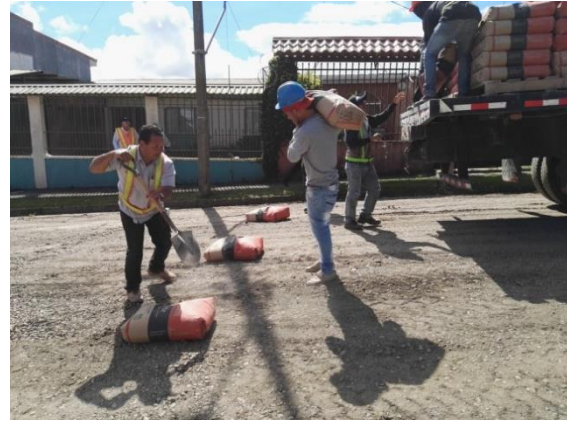
(b) Colocación de los sacos de cemento
