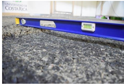
(a) Bache asfáltico deformado
