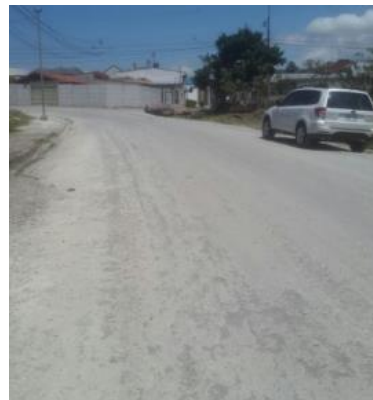
(d) Tramo terminado
