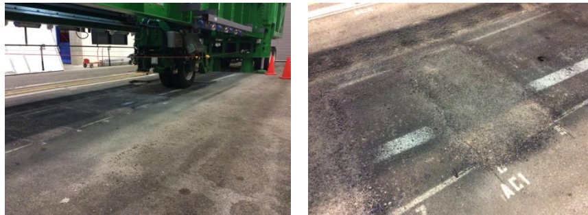
Figura 46. Proceso de ensayo del tramo 005AC1BA
