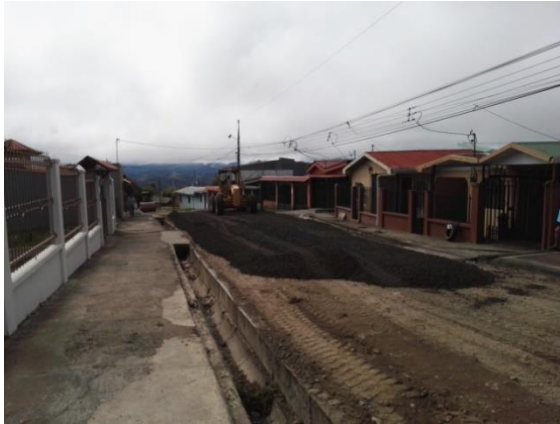
(a) Colocación de la capa de base granular
