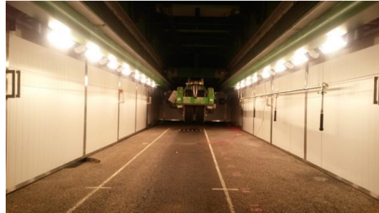
(b) Vista interna
