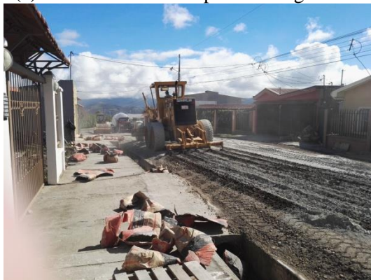
(c) Mezclado y conformación de la capa de base estabilizada
