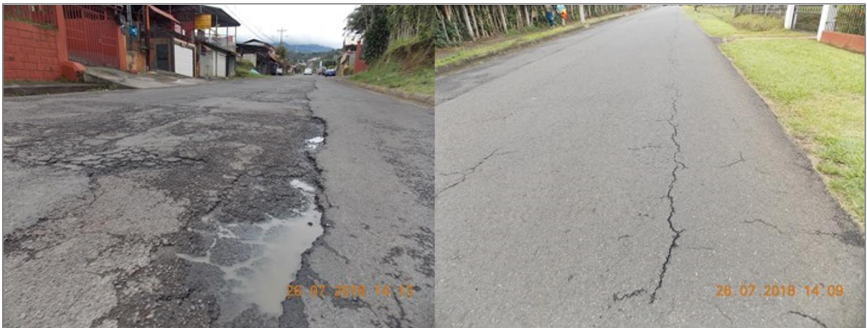
Figura 30. Sector sur y central del tramo 22
