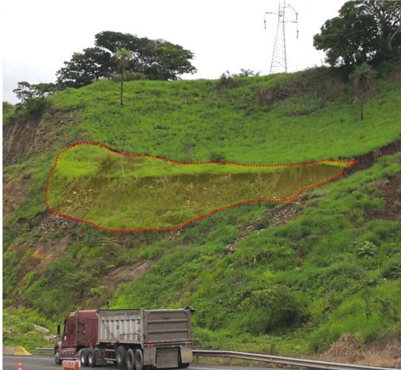
Figura 74: Zona con potencial de deslizamiento, talud del est. 44+800.
