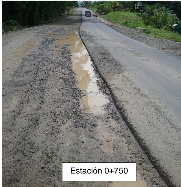
Fotografía 15. Base granular deteriorada a nivel de capa terminada, sin imprimir y con acumulación de agua. Estación 0+000 y 0+750.
