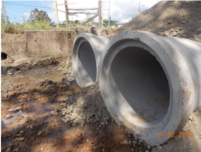
Fotografía 7. Alcantarilla doble de tubo colocada en 0+000.
