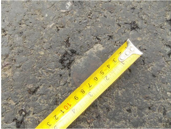
Fotografía 17. Agregado con sobre tamaño identificado en la carpeta de rodadura.
