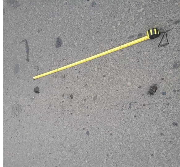
Fotografía 4. Desprendimiento de agregados entre la estación 1+840 a 1+900.
