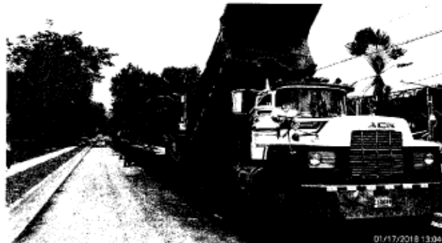
Fotografía No.4, Fuente: CONAVI, Sección reconfirmada a nivel de base granular, estación 4+900. Fecha 17-01-2018
