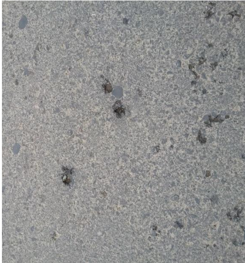
Fotografía 4. Desprendimiento de agregados entre la estación 1+840 a 1+900.
