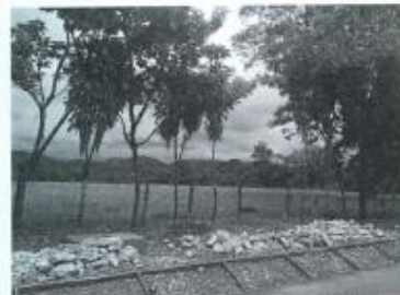
Fotografía No.2, Fuente: CONAVI, trabajos de reparación km 4+350.
