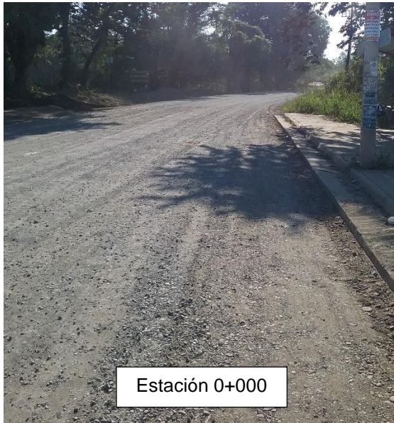
Fotografía 15. Base granular deteriorada a nivel de capa terminada, sin imprimir y con acumulación de agua. Estación 0+000 y 0+750.
