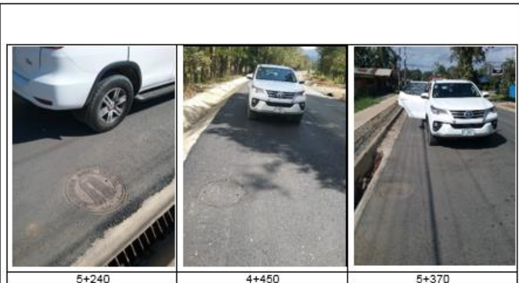
Figura 1. Ubicación de algunas tapas de alcantarilla en el proyecto fuera de la huella del tránsito. Fuente: Fecha: 16 de marzo 2018. Fuente: LanammeUCR.
