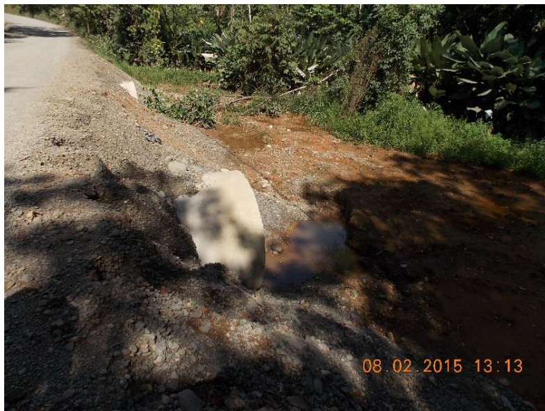
Fotografía 8. Alcantarillas de tubo colocadas en la estación 3+825.
