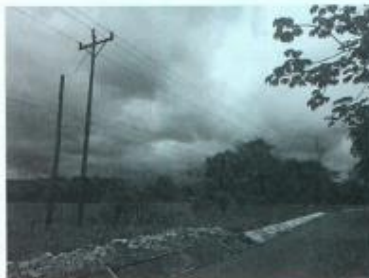
Fotografía No.1, Fuente: CONAVI, trabajos de reparación km 4+350.
