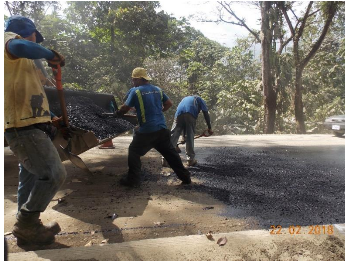
Fotografía 14. Colocación de “traba” sobre la base granular sin imprimir. Estación 3+820. Fecha de la fotografía: 22-02-2018. Fuente: LanammeUCR.
