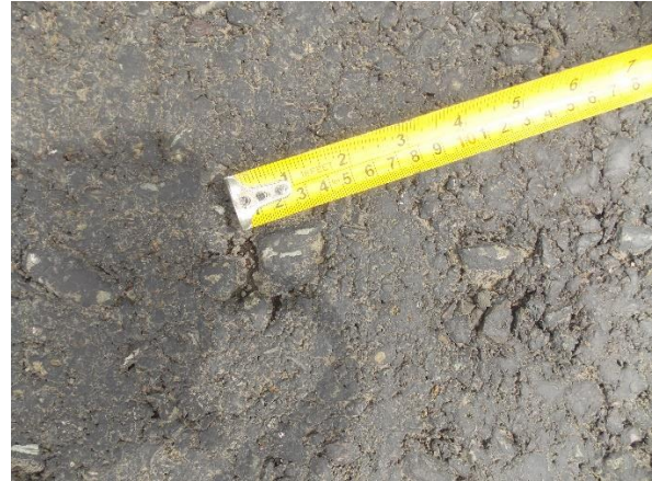
Fotografía 17. Agregado con sobre tamaño identificado en la carpeta de rodadura.
