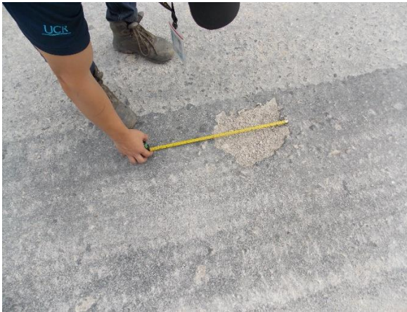
Fotografía 42. Pérdida del sello asfáltico y formación de pequeños huecos en la capa de base tratada con cemento. Ubicación: Ruta Nacional 163, sección de control 60922 Dominicana– Lteprov Puntarenas/ Guanacaste (r Juan de León) Km 5+990 desde el cruce con la Ruta Nacional 21. Fecha: 12 de julio de 2018. Fuente: LanammeUCR.
