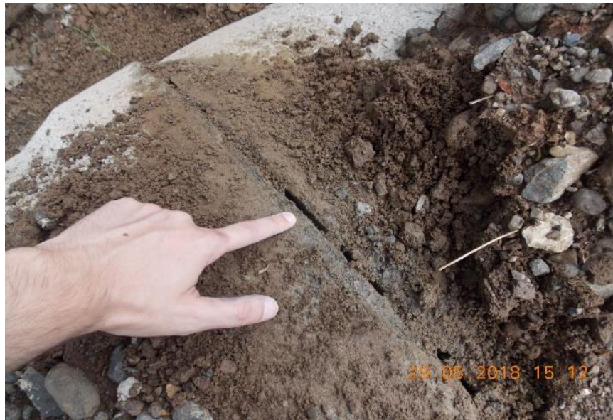
Fotografía 14. Punto 1: Unión externa sin sellar entre tuberías de concreto.
