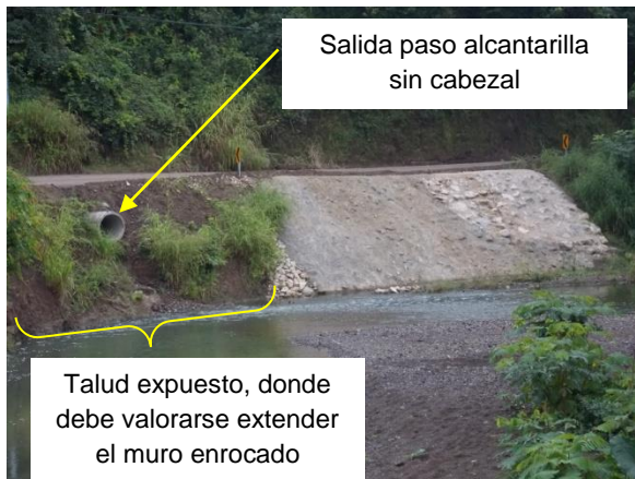
Fotografía 25. Muro enrocado para proteger erosión provocada por el río. Se observa que todavía existe una zona donde río podría erosionar el talud del camino. Ubicación: sobre la Ruta 163, km 10+200 desde el cruce con la Ruta 21, Sección de control 60922: Dominicana (Iglesia)-Lte, Provincial Puntarenas/Guanacaste (Río Juan de León). Fecha 07 de setiembre de 2018. Fuente: UAT-LanammeUCR.
