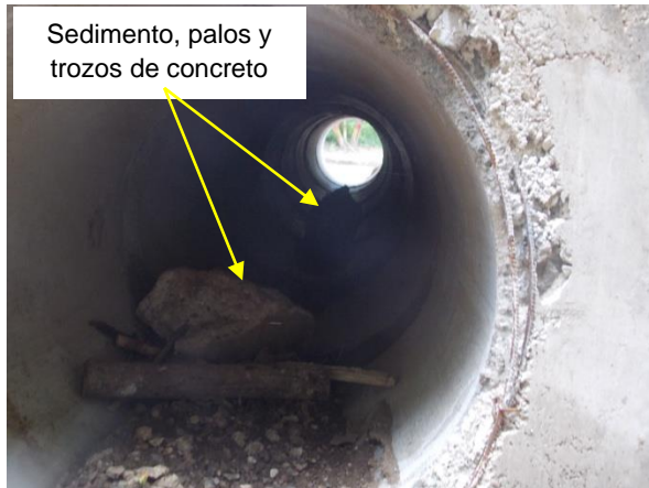
Fotografía 21. Paso de alcantarilla donde se observa sedimento, palos y un trozo de concreto que obstruyen paso del agua. Ubicación: sobre la Ruta 163, km 10+200 desde el cruce con la Ruta 21, Sección de control 60922:Dominicana (Iglesia)-Lte, Provincial Puntarenas/Guanacaste (Río Juan de León) Fecha 31 de mayo de 2018. Fuente: UAT-LanammeUCR.
