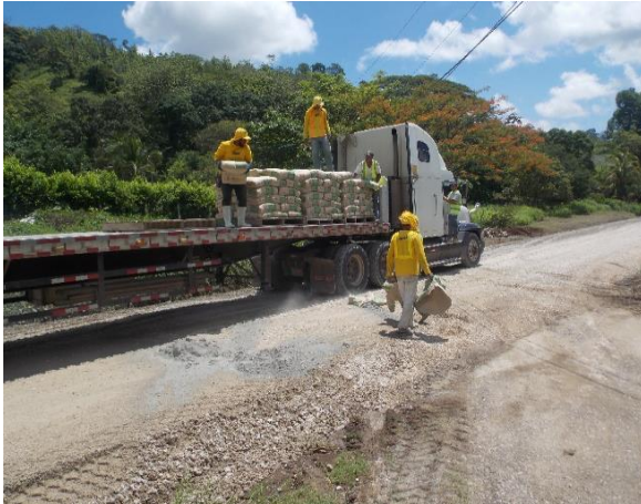
Fotografía 1. Lanzamiento de sacos de cemento desde tarima del camión.
