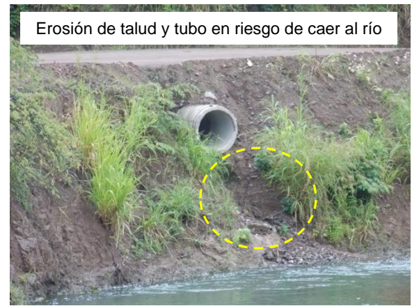
Fotografía 26. Talud del camino erosionado por el río y caudal de salida del paso de alcantarilla. Ubicación: sobre la Ruta 163, km 10+200 desde el cruce con la Ruta 21, Sección de control 60922: Dominicana (Iglesia)-Lte, Provincial Puntarenas/Guanacaste (Río Juan de León). Fecha 07 de setiembre de 2018. Fuente: UAT-LanammeUCR.
