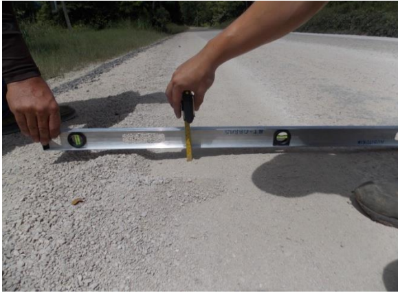
Fotografía 38. Material de secado acumulado en los lados del camino con altura de hasta 4 cm. Ubicación: Sobre Ruta 163, km 7+800 desde cruce Ruta 21, Sección de control 60922, Dominicana (iglesia) – Lte Prov. Puntarenas/Guanacaste (R Juan De León). Fecha 12 de julio de 2018. Fuente: UAT-LanammeUCR.
