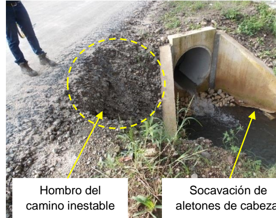
Fotografía 32. Cabezal de salida CA-2 para paso de alcantarilla donde se observa incipiente socavación de las paredes e inestabilidad del hombro del camino.
