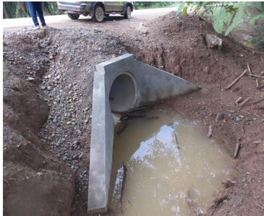
Fotografía 19. Alcantarilla de 1.20 m de diámetro, y 15m de longitud, cabezal de salida CA-2 sin delantal de protección donde se genera erosión.
