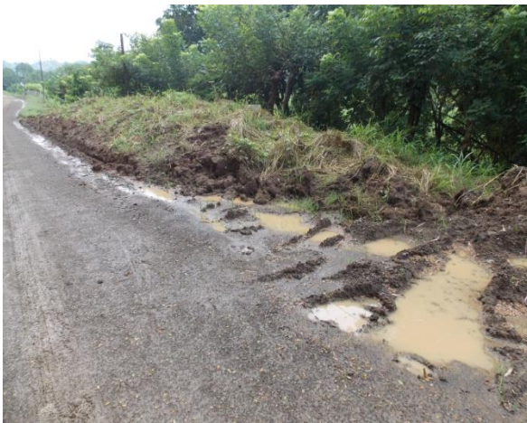
Fotografía 17. Conformación de salida lateral o sangrador inadecuada con mucho material suelto e irregularidades que generan charcos. Ubicación: sobre la RN. 163, km 16+500 desde el cruce con la Ruta 21 Sección de control 60922: Dominicana (Iglesia)-Lte, Provincial Puntarenas/Guanacaste (Río Juan de León). Fecha 06 de setiembre de 2018 Fuente: UAT-LanammeUCR.
