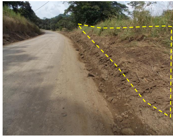
Fotografía 7. Desecho de la conformación de cunetas colocado al lado derecho del camino dentro del derecho de vía.
