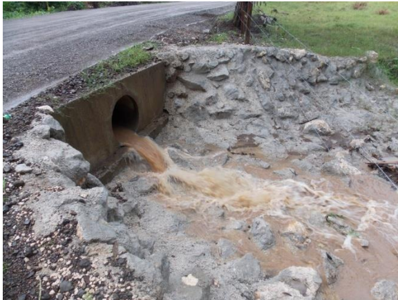
Fotografía 29. Protección contra erosión en salida de paso de alcantarilla rehabilitado de 60 cm de diámetro.
