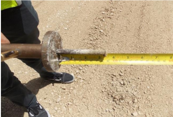
Fotografía 9. Espesor de 9 cm de subbase granular colocado. Ubicación: Sobre la Ruta 163, km 4+385 desde el cruce con la Ruta 21, Sección de control 60921: Jicaral (R.21)-Dominicana (Iglesia). Fecha 31 de mayo de 2018. Fuente: UAT-LanammeUCR.
