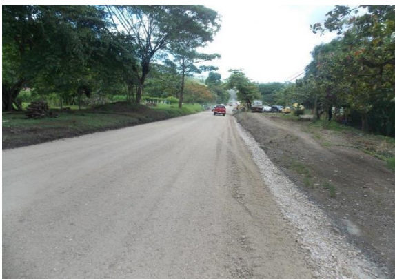
Fotografía 47. Ausencia de señalamiento previo al cierre por trabajo en la vía Ubicación: Sobre la Ruta 163, km 6+985 desde el cruce con la Ruta 21, Sección de control 60922: Dominicana (Iglesia)-Lte, Provincial Puntarenas/Guanacaste (Río Juan de León). Fecha 30 de mayo de 2018. Fuente: UAT-LanammeUCR.
