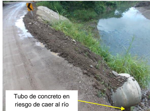
Fotografía 24. Salida de paso de alcantarilla donde no se construyó muro enrocado para proteger la plataforma del camino. Ubicación: sobre la Ruta 163, km 10+200 desde el cruce con la Ruta 21, Sección de control 60922: Dominicana (Iglesia)-Lte, Provincial Puntarenas/Guanacaste (Río Juan de León). Fecha 07 de setiembre de 2018. Fuente: UAT-LanammeUCR.
