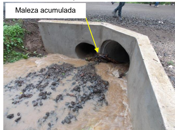
Fotografía 28. Se observan desechos acumulados en la junta de los tubos y mayor caudal entrando a la tubería nueva dado que tiene mayor diámetro. Ubicación: sobre la Ruta 163, km 26+000 desde el cruce con la Ruta 21, Sección de control 50720: Jabillo (R.623) - San Francisco de Coyote (R.160). Fecha 13 de agosto de 2018. Fuente: UAT-LanammeUCR.
