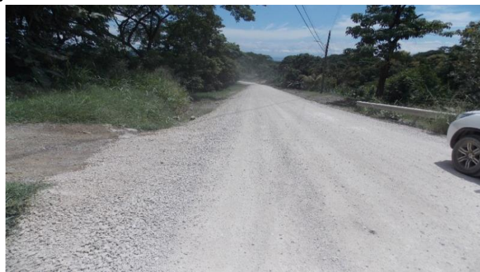
Fotografía 45. Material granular desplazado al costado de vía, ahuellamientos de hasta 5 cm de espesor. Ubicación: Ruta Nacional 163, sección de control 60921, Jicaral- Dominicana, Km 0+890 desde el cruce con la Ruta Nacional 21. Fecha: 12 de julio de 2018. Fuente: LanammeUCR.
