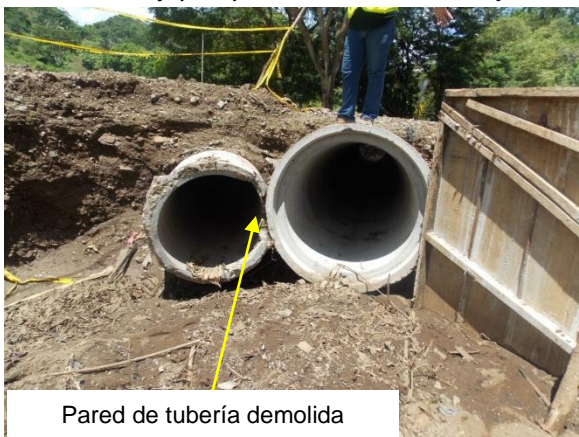
Fotografía 27. Cabezal de entrada en proceso de rehabilitación con tubería existente de 0,60 m de diámetro y tubería nueva de 0,90 m de diámetro. Se observa que se requirió demoler una pared de la tubería existente para acomodar la tubería nueva. Ubicación: sobre la Ruta 163, km 26+000 desde el cruce con la Ruta 21, Sección de control 50720: Jabillo (R.623) - San Francisco de Coyote (R.160). Fecha 31 de mayo de 2018. Fuente: UAT-LanammeUCR.
