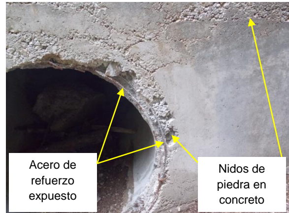
Fotografía 22. Cabezal de entrada en paso de alcantarilla donde se observa acero expuesto y nidos de piedra (“hormigueros”) en el concreto. Ubicación: sobre la Ruta 163, km 10+200 desde el cruce con la Ruta 21, Sección de control 60922:Dominicana (Iglesia)-Lte, Provincial Puntarenas/Guanacaste (Río Juan de León) Fecha 31 de mayo de 2018. Fuente: UAT-LanammeUCR.
