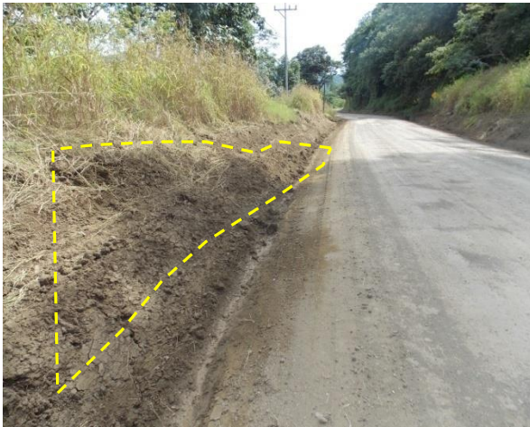
Fotografía 6. Desecho de la conformación de cunetas colocado al lado izquierdo del camino dentro del derecho de vía.
