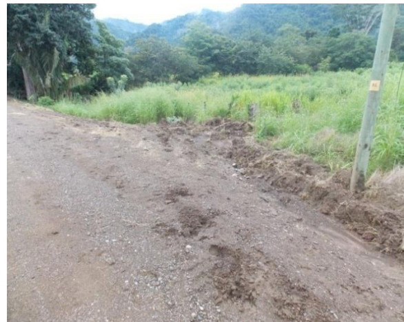
Fotografía 18. Conformación de salida lateral o sangrador inadecuada con mucho material suelto e irregularidades que generan charcos. Ubicación: sobre la RN. 163, km 12+300 desde el cruce con la Ruta 21, Sección de control 60922: Dominicana (Iglesia)-Lte, Provincial Puntarenas/Guanacaste (Río Juan de León). Fecha 06 de setiembre de 2018 Fuente: UAT-LanammeUCR.
