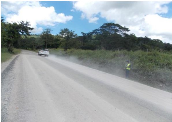
Fotografía 33. Generación de polvo en tramo mejorado con cemento y sello asfáltico debido al material de secado presente sobre la calzada. Ubicación: sobre Ruta 163, km 7+805 desde cruce con Ruta, Sección de control 60922, Dominicanica (iglesia) – Lte Prov. Puntarenas/Guanacaste (R Juan De León). Fecha 12 de julio de 2018. Fuente: UAT-LanammeUCR.
