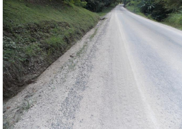
Fotografía 39. Material de secado acumulado en espadón y cuneta. Ubicación: sobre Ruta 163, km 6+225 desde cruce con Ruta 21, Sección de control 60922, Dominicana (iglesia) – Lte Prov. Puntarenas/Guanacaste (R Juan De León). Fecha 12 de julio de 2018. Fuente: UAT-LanammeUCR.
