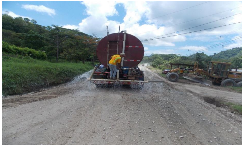
Fotografía 2. Riego de agua previo al inicio del proceso de compactación.
