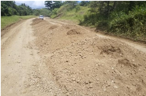
Fotografía 50. Circulación de vehículos por zona de trabajo sin dispositivos de seguridad. Ubicación: Sobre la Ruta 163, km 15+365 desde el cruce con la Ruta 21, Sección de control 60922: Dominicana (Iglesia)-Lte, Provincial Puntarenas/Guanacaste (Río Juan de León). Fecha 31 de julio de 2018. Fuente: UAT-LanammeUCR.
