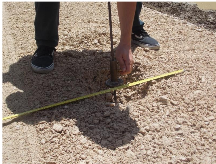
Fotografía 8. Medición de espesores subbase granular.
