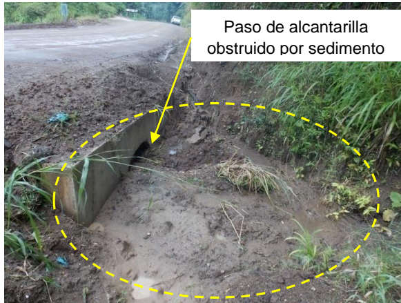
Fotografía 23. Cabezal de entrada de paso de alcantarilla prácticamente obstruido en toda su sección transversal por sedimentos. Ubicación: sobre la Ruta 163, km 10+200 desde el cruce con la Ruta 21, Sección de control 60922: Dominicana (Iglesia)-Lte, Provincial Puntarenas/Guanacaste (Río Juan de León). Fecha 07 de setiembre de 2018. Fuente: UAT-LanammeUCR.
