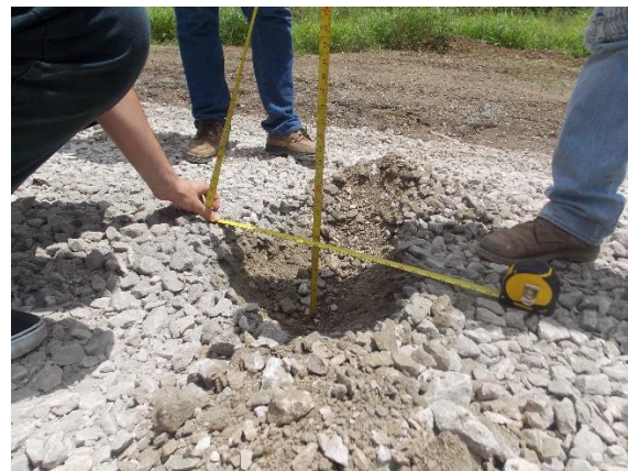
Fotografía 12. Espesor de 18 cm de subbase granular colocado. Ubicación: Sobre la Ruta 163, km 6+880 desde el cruce con la Ruta 21, Sección de control 60922: Dominicana (Iglesia)-Lte, Provincial Puntarenas/Guanacaste (Río Juan de León). Fecha 31 de mayo de 2018. Fuente: UAT-LanammeUCR.
