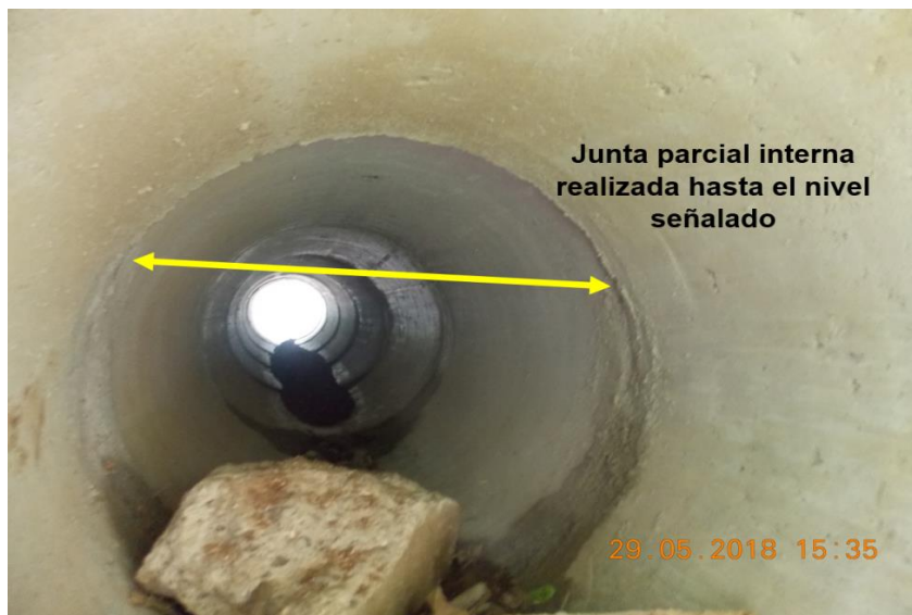
Fotografía 15. Punto 2: Junta interna incompleta.
