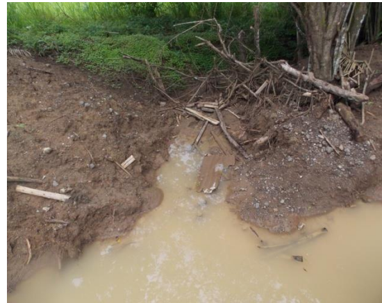
Fotografía 20. Salida de paso de alcantarilla sin protección contra la erosión y donde no se ha conformado un canal adecuado para el drenaje eficiente hacia los terrenos aledaños.
