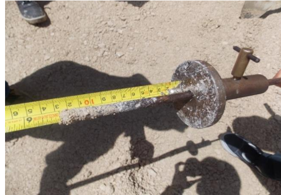
Fotografía 10. Espesor de 13 cm de subbase granular colocado. Ubicación: Sobre la Ruta 163, km 4+385 desde el cruce con la Ruta 21, Sección de control 60921: Jicaral (R.21)-Dominicana (Iglesia). Fecha 31 de mayo de 2018. Fuente: UAT-LanammeUCR
