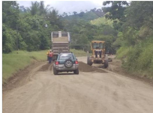
Fotografía 49. Tránsito de vehículos sin señalización del área de acción de maquinaria. Ubicación: Sobre la Ruta 163, km 15+300 desde cruce con RN21 Sección de control 60922, Dominicana (iglesia)–Límite Provincial Puntarenas/Guanacaste (R Juan De León). Fecha 31 de julio de 2018. Fuente: UAT-LanammeUCR.
