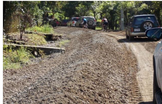
Fotografía 51. Trabajos de extensión de subbase granular sin señalización canalizadora de la zona de trabajo. Ubicación: Sobre la Ruta 163 km 25+745 desde cruce con Ruta 21, Sección de control 50720: Jabillo (r.623) – San Francisco de Coyote (r.160). Fecha 03 de setiembre de 2018. Fuente: UAT-LanammeUCR.
