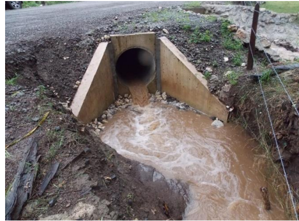
Fotografía 30. Cabezal de salida CA-2 construido para paso de alcantarilla de 90 cm de diámetro paralelo al existente. No cuenta con protección contra erosión.
