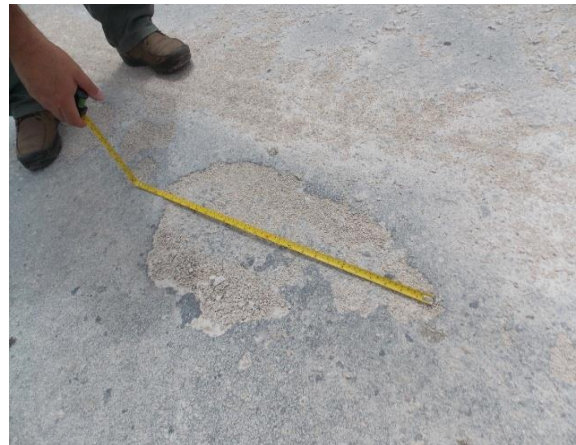
Fotografía 43. Huecos de hasta 50 cm de diámetro por deterioro del sello asfáltico. Ubicación: Ruta Nacional 163, sección de control 60921, Jicaral- Dominicana, Km 4+705 desde el cruce con la Ruta Nacional 21. Fecha: 12 de julio de 2018. Fuente: LanammeUCR
