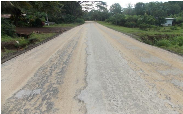
Fotografía 40. Material de secado que conserva humedad sobre el sello asfáltico luego de una leve llovizna. Ubicación: sobre la RN. 163, km 16+100 desde el cruce con la Ruta 21, Sección de control 60922, Dominicana (iglesia) – Lte Prov. Puntarenas/Guanacaste (R Juan De León). Fecha 06 de setiembre de 2018. Fuente: UAT-LanammeUCR.
