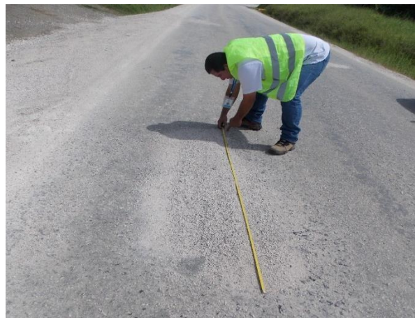
Fotografía 44. Bacheos sobre tramos para control de polvo. Ubicación: Ruta Nacional 163, sección de control 60922 Dominicana– Lteprov Puntarenas/ Guanacaste (r Juan de León) Km 5+990 desde el cruce con la Ruta Nacional 21. Fecha: 03 de setiembre de 2018. Fuente: LanammeUCR.
