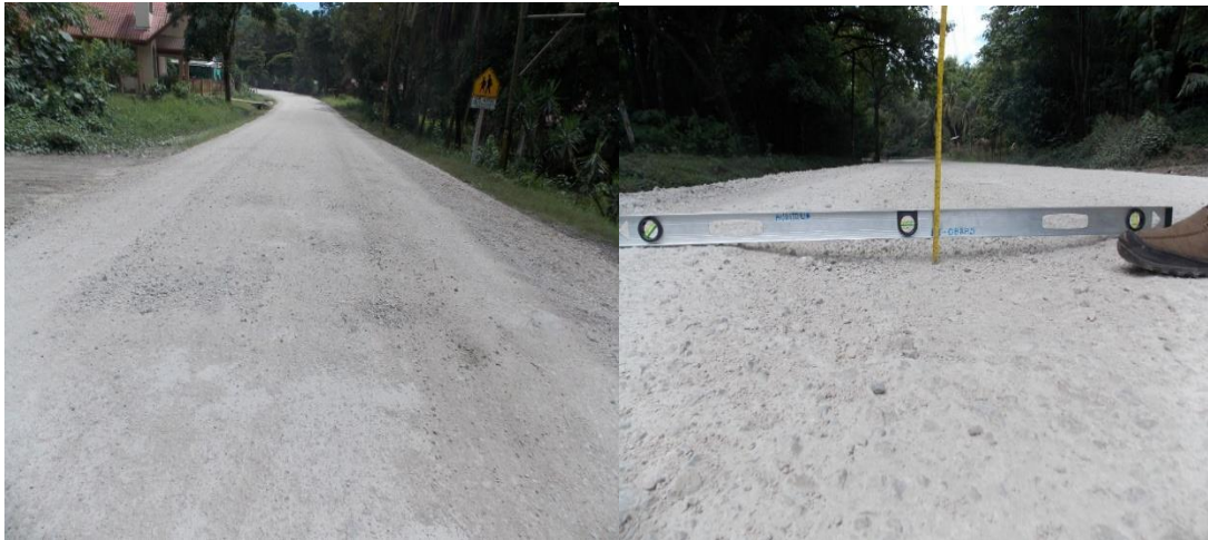
Fotografía 46. Huecos múltiples subbase granular, hasta 5 cm de profundidad. Ubicación: Ruta Nacional 163, sección de control 60921, Jicaral- Dominicana, Km 3+485 desde el cruce con la Ruta Nacional 21. Fecha: 12 de julio de 2018. Fuente: LanammeUCR.
