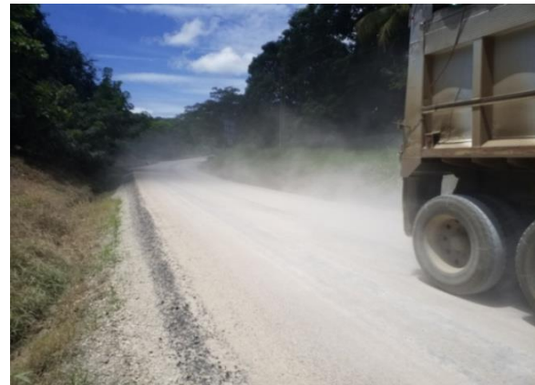
Fotografía 34. Generación de polvo en tramo mejorado con cemento y sello asfáltico debido al material de secado presente sobre la calzada. Ubicación: sobre Ruta 163, km 0+900 desde cruce con Ruta 21, Sección de control 60921, Jicaral (R21) – Dominicanica (iglesia). Fecha 31 de julio de 2018. Fuente: UAT-LanammeUCR.
