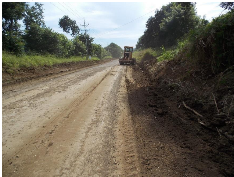
Fotografía 54 Reacondicionamiento de cunetas sin inspección. Ubicación: Sobre la Ruta 163, km 10+580 desde el cruce con la Ruta 21, Sección de control 60922: Dominicana (Iglesia)-Lte, Provincial Puntarenas/Guanacaste (Río Juan de León). Fecha 03 de setiembre de 2018. Fuente: UAT-LanammeUCR.
