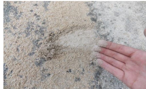
Fotografía 41. Las partículas finas del material de secado conservan humedad . Ubicación: sobre la RN. 163, km 16+100 desde el cruce con la Ruta 21, Sección de control 60922, Dominicana (iglesia) – Lte Prov. Puntarenas/Guanacaste (R Juan De León). Fecha 06 de setiembre de 2018. Fuente: UAT-LanammeUCR.
