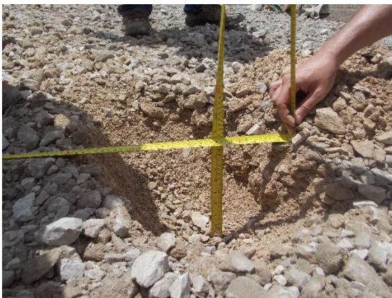
Fotografía 11. Espesor recuperado 21 cm subbase granular con cemento. Ubicación: Sobre la Ruta 163, km 6+880 desde el cruce con la Ruta 21, Sección de control 60922: Dominicana (Iglesia)-Lte, Provincial Puntarenas/Guanacaste (Río Juan de León). Fecha 31 de mayo de 2018. Fuente: UAT-LanammeUCR.
