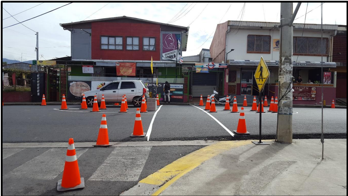
Figura 12. Pasarela peatonal con isla de refugio
