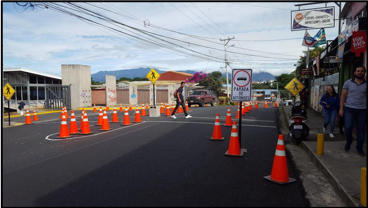
Figura 11. Pasarela peatonal con isla de refugio peatonal y parada de autobús
