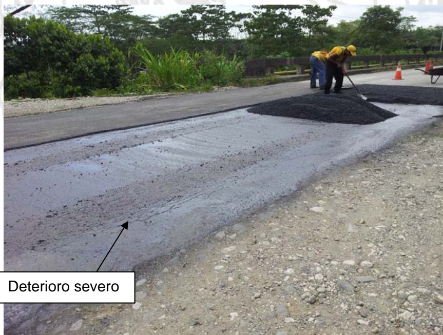
Fotografía 9: Zona 4-3 Zona Sur, colocación de mezcla asfáltica sobre deterioros severos.
