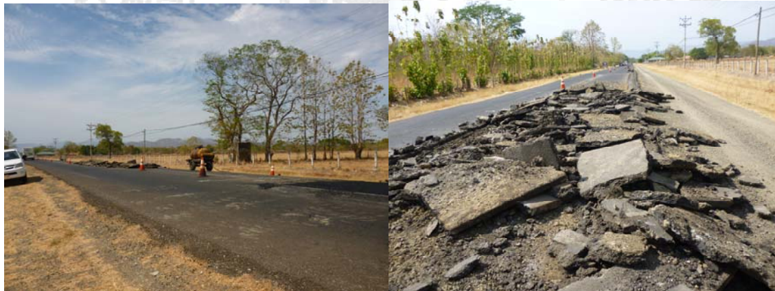
Fotografía 12: Zona 2-3 Santa Cruz, Construcción de bacheos de gran dimensión.
