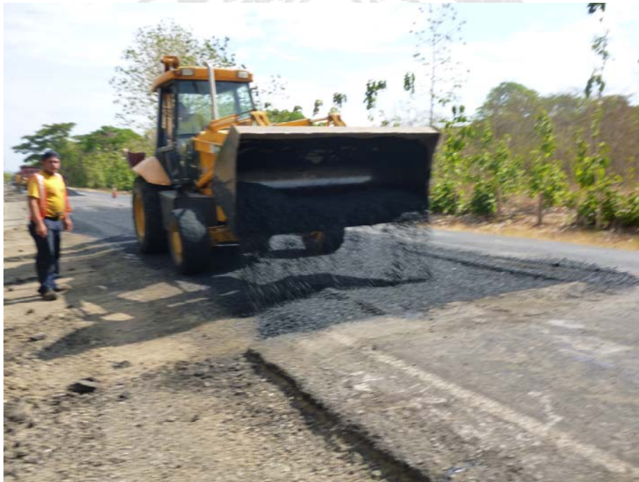
Fotografía 13: Zona 2-3 Santa Cruz, Colocación de mezcla asfáltica con pala.
