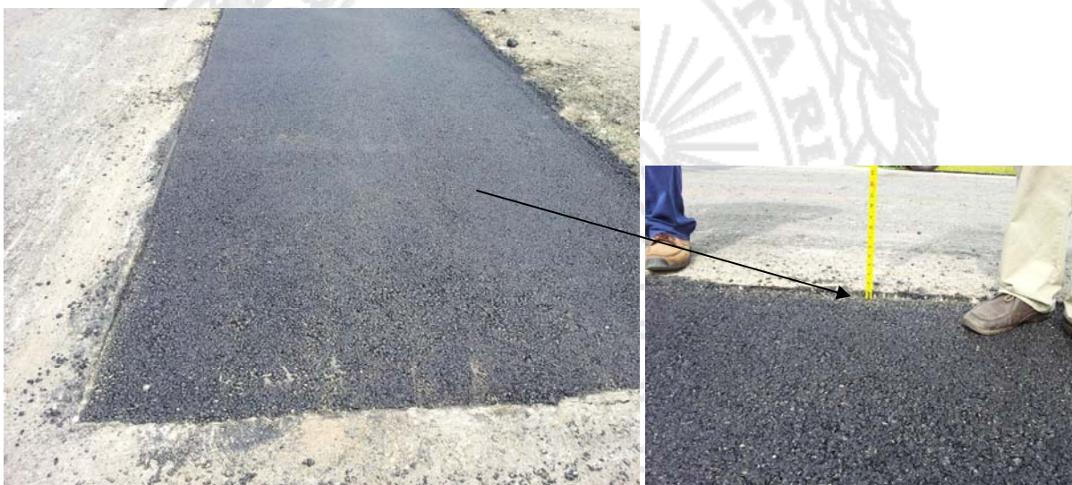
Fotografía 11: Zona 4-3 Zona Sur, Colocación de mezcla asfáltica sobre deterioros severos. Ubicación: Ruta Nacional No.2, sección Río Caracol - Ciudad Neilly. 50m del Puente sobre el río Caracol. Fecha: 30 de enero del 2013. Fuente: Unidad de Auditoría Técnica, LanammeUCR.
