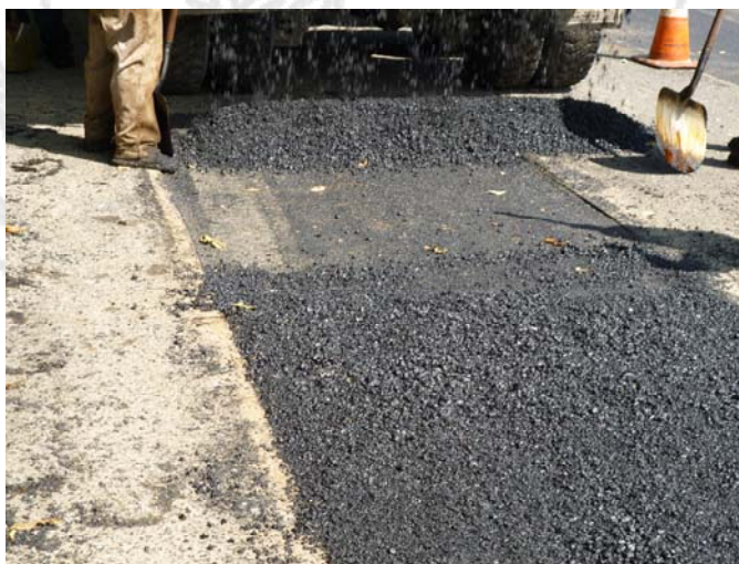
Fotografía 10: Zona 5.2 Limón. Colocación de espesor pequeño de mezcla asfáltica en bacheo. Ubicación: Ruta Nacional No.32, sección 70471 San Miguel - Río Toro. Venecia, 3km antes de Río Toro. Fecha: 8 de febrero del 2013. Fuente: Unidad de Auditoría Técnica, LanammeUCR.
