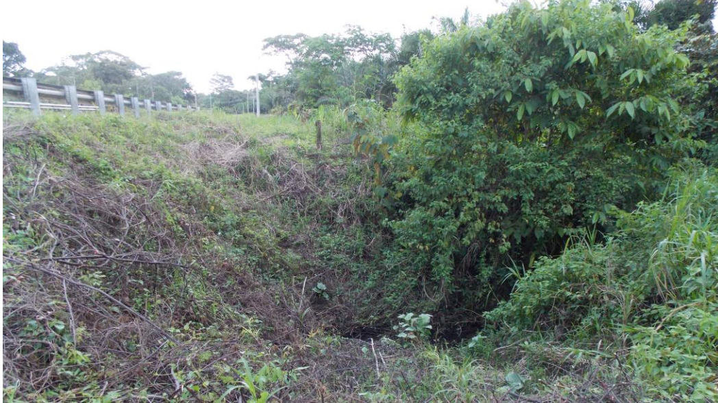
Figura A10: Vista de la entrada, alcantarilla en est. 59+090.
