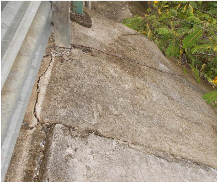
Figura A5: protección del talud, alcantarilla en est. 46+460.
