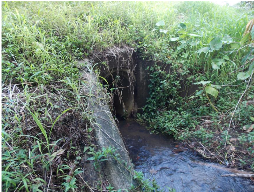
Figura A9: Vista de la entrada, alcantarilla en est. 58+740.
