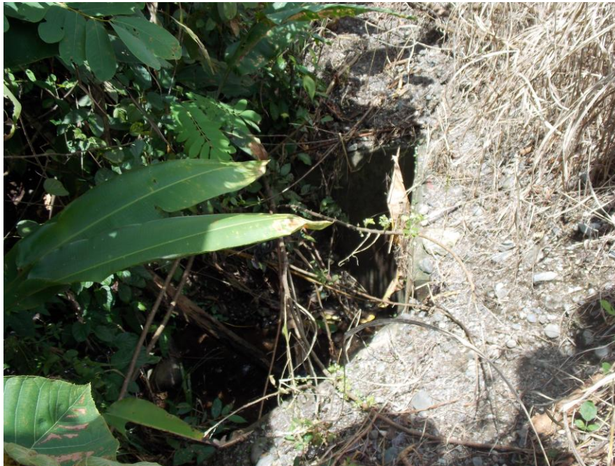
Figura A15: Vista de la entrada, alcantarilla en est. 69+715.
