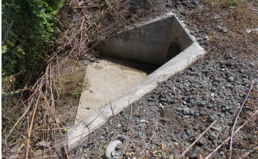
Figura A14: Vista de la entrada, alcantarilla en est. 68+770.
