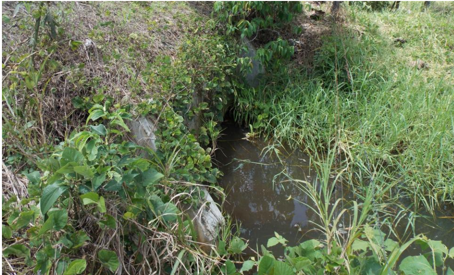
Figura A12: Vista de la salida, alcantarilla en est. 67+240.
