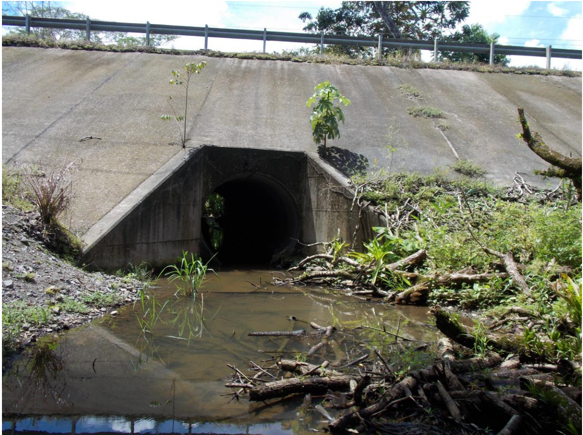
Figura A16: Vista de la entrada, alcantarilla en est. 70+690.
