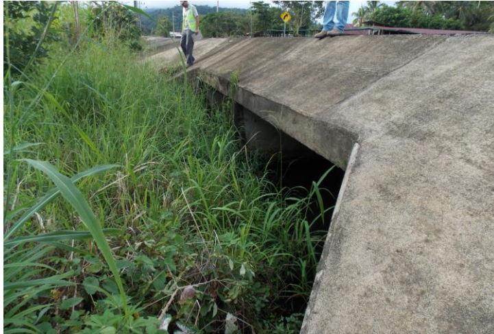
Figura A4: Entrada de alcantarilla, est. 46+460.
