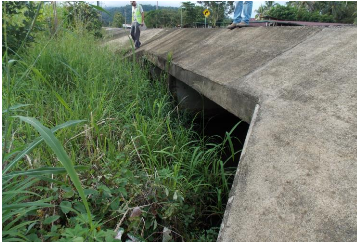
Figura 19: Entrada de alcantarilla, est. 46+460.
