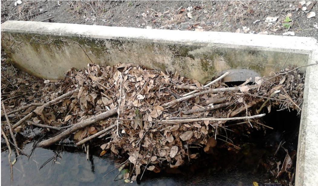
Figura A6: Entrada de alcantarilla, est. 47+500.
