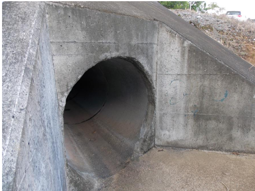
Figura A11: Vista de la entrada, alcantarilla en est. 61+850.
