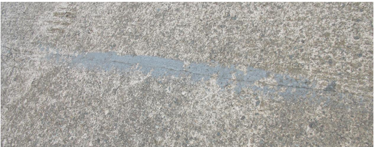
Figura 13: tratamiento de grietas, puente sobre la Quebrada Sábala.
