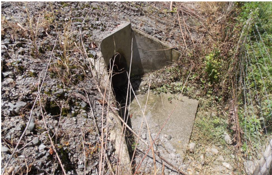
Figura A13: Vista de la salida, alcantarilla en est. 67+890.
