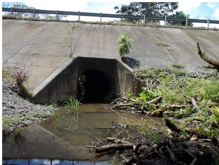
Figura 20: Vista desde la entrada, alcantarilla en est. 70+690.
