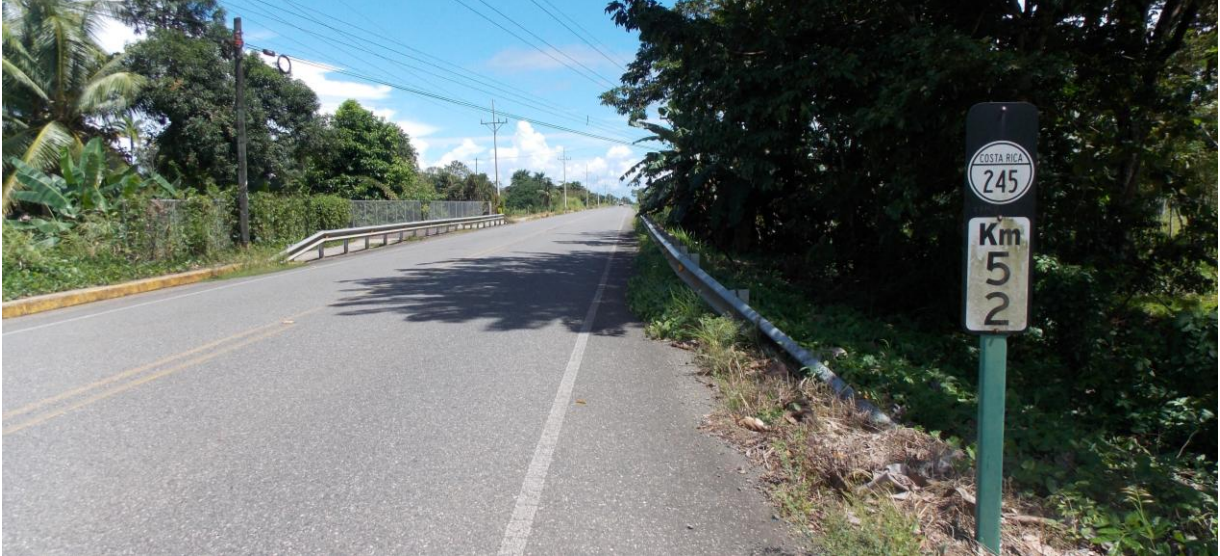
Figura A8: Vista general, alcantarilla en est. 52+100.
