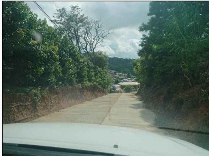
Figura 15. Pendientes de 20%, Escenario 1 - Tramo 3, vista hacia el este. Fuente: LanammeUCR.
