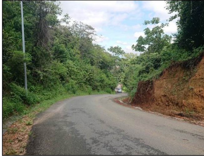
Figura 13. Pendientes de 20%, Escenario 1- Tramo 2, vista hacia el oeste. Fuente: LanammeUCR.
