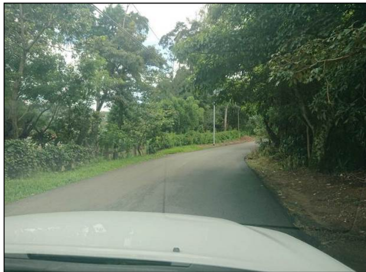
Figura 12. Pendientes de 20%, Escenario 1- Tramo 2, vista hacia el oeste. Fuente: LanammeUCR.
