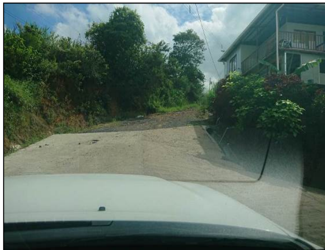
Figura 18. Pendientes de 15%, Escenario 1 - Tramo 4, cambio de superficie de rudo. Fuente: LanammeUCR
