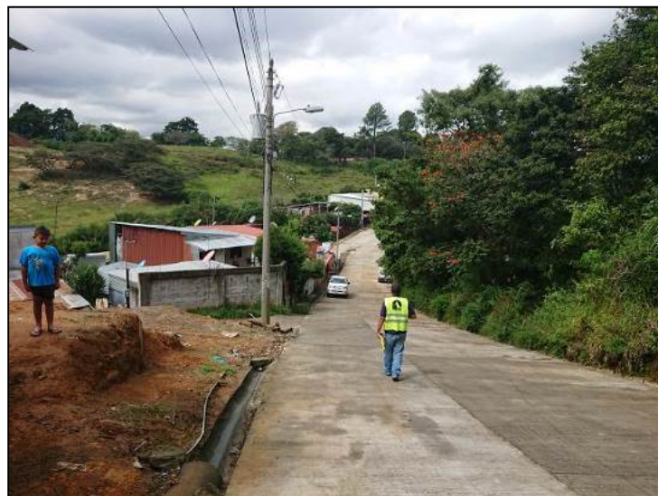
Figura 16. Pendientes 22%, Escenario 1 - Tramo 3, vista hacia el oeste. Fuente: LanammeUCR.
