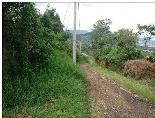
Figura 19. Pendientes de 15%, Escenario 1 - Tramo 4, vista hacia el oeste. Fuente: LanammeUCR.
