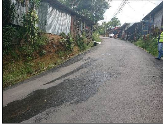
Figura 8. Pendientes del 25% del Tramo 1, vista hacia el norte. Fuente: LanammeUCR.
