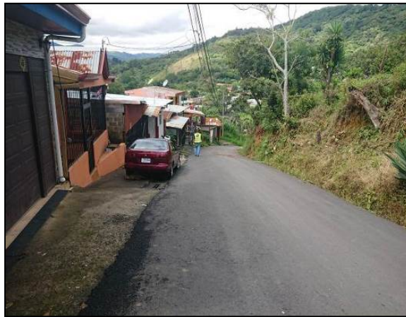
Figura 9. Pendientes del 25%, Tramo 1, vista hacia el sur. Fuente: LanammeUCR.
