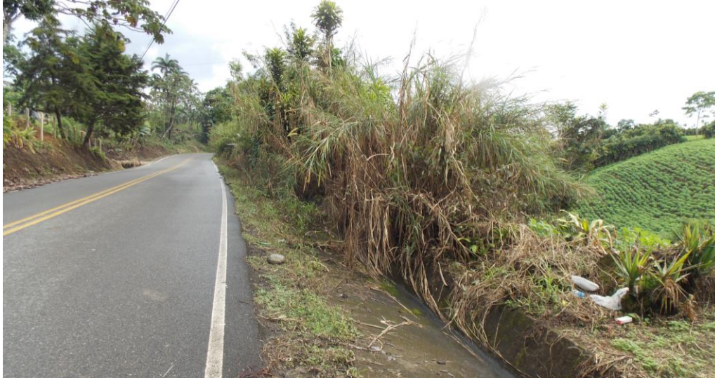
Figura 17: Estado de la cuneta revestida, est. 12+800.
