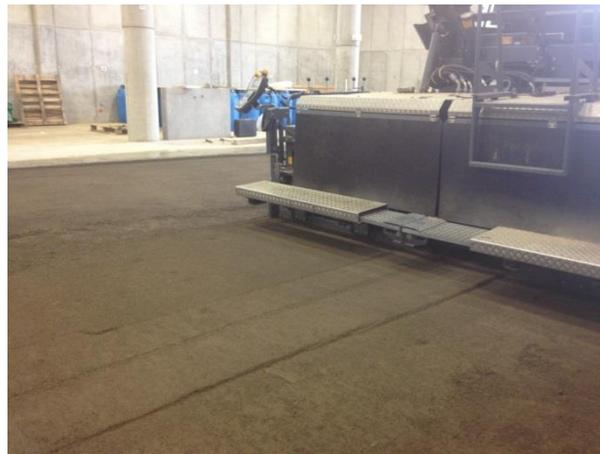
Figura 5. Material de la base estabilizada en proceso de colocación.
