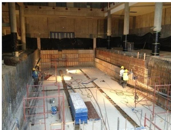
Figura 14. Losa de concreto y parte del sistema de filtrado durante la construcción.
