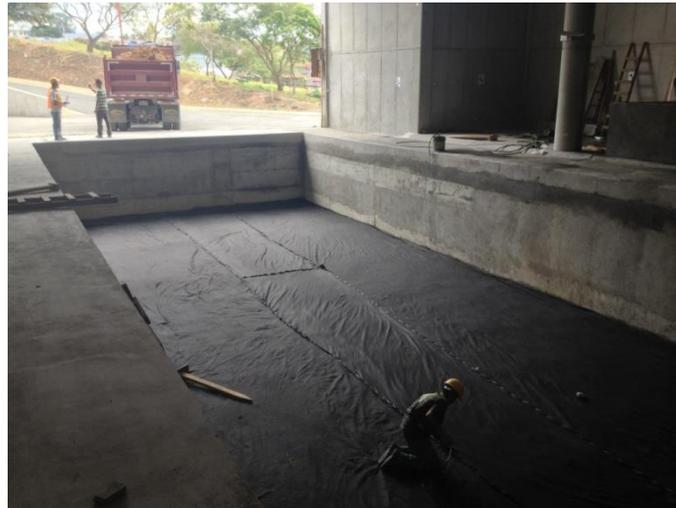
Figura 16. Geotextil 3 parte del sistema de drenaje.
