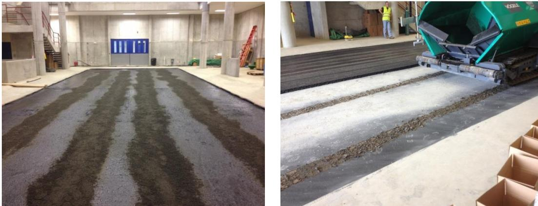
Figura 24. Material de secado y desprendimiento de emulsión
