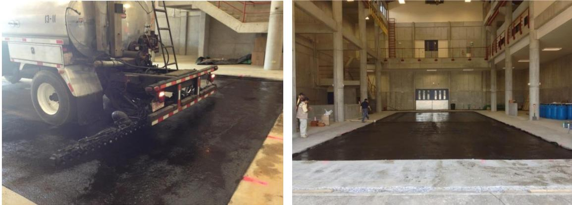
Figura 23. Colocación y acabado de la capa de ligante.
