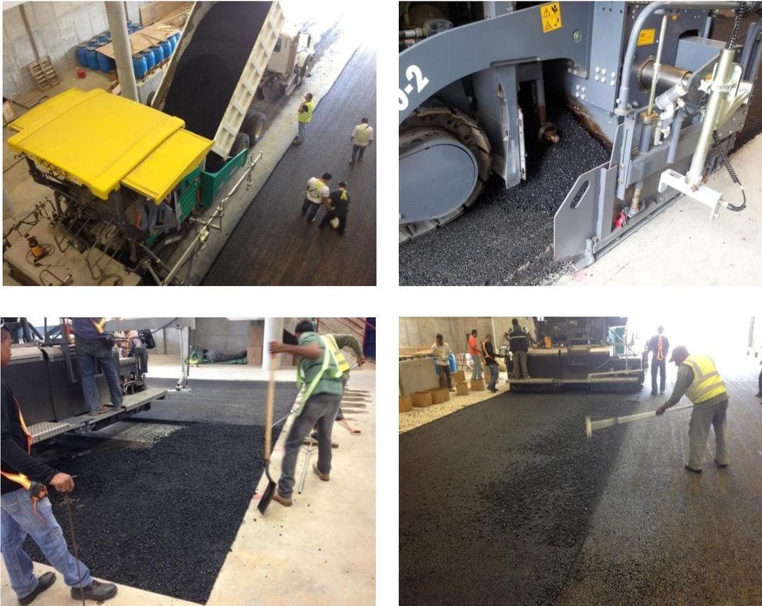
Figura 26. Colocación de la mezcla asfáltica
