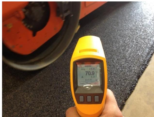
Figura 32. Temperatura de mezcla asfáltica al compactar.
