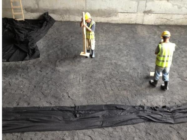
Figura 15. Colocación de capa de material de filtrado colocada.
