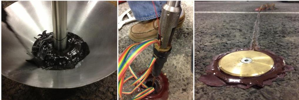
Figura 29. Instalación de los sensores de deformación vertical (MDD).
