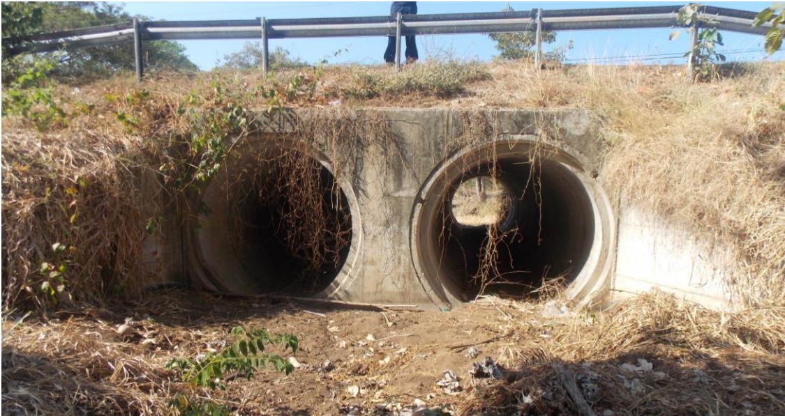
Figura 14: vista de la entrada, alcantarilla en est. 3+180
