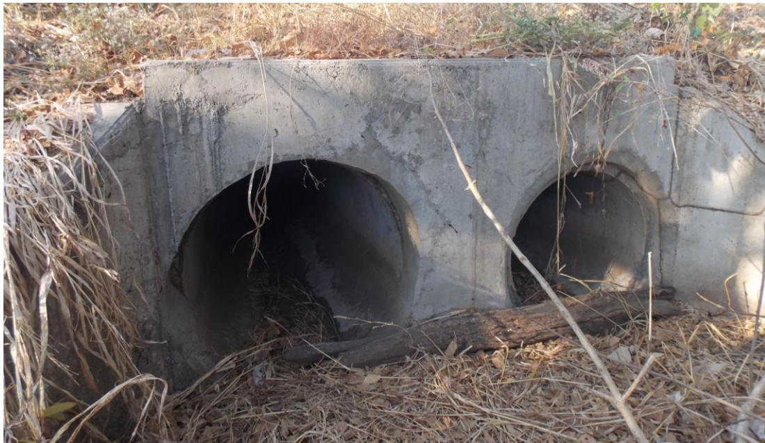
Figura 26: vista de la entrada, alcantarilla en est. 6+920
