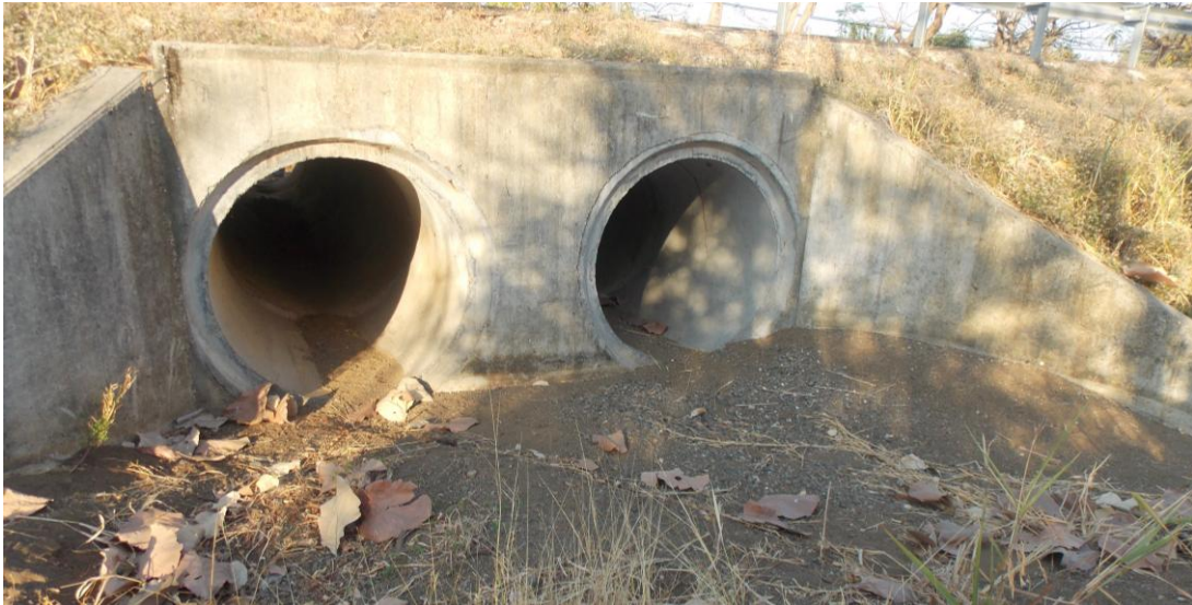
Figura 31: vista de la entrada, alcantarilla en est. 8+920
