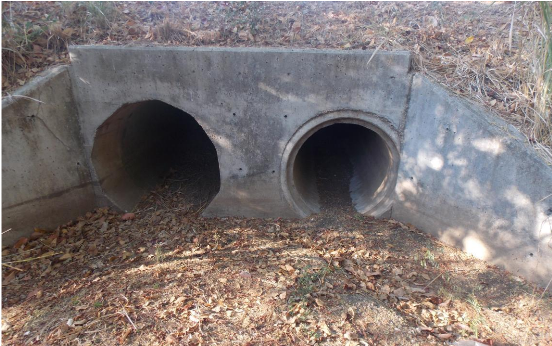
Figura 25: vista de la entrada, alcantarilla en est. 6+600
