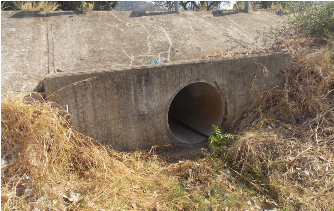
Figura 15: vista de la salida, alcantarilla en est. 3+520
