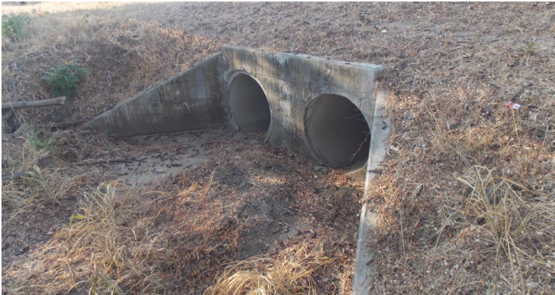
Figura 28: vista de la entrada, alcantarilla en est. 7+430
