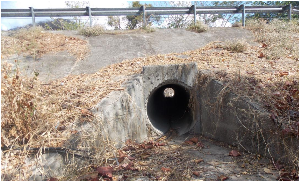
Figura 7: vista de la salida, alcantarilla en est. 1+570
