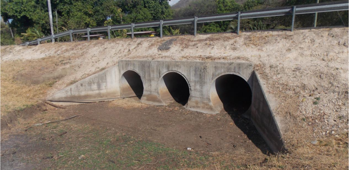
Figura 18: vista de la entrada, alcantarilla en est. 4+230
