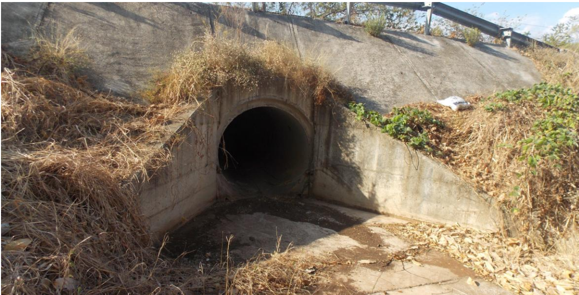
Figura 22: vista de la entrada, alcantarilla en est. 5+360
