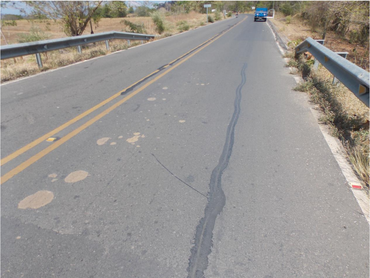
Figura 2: Sello de grietas aplicado, est. 1+070
