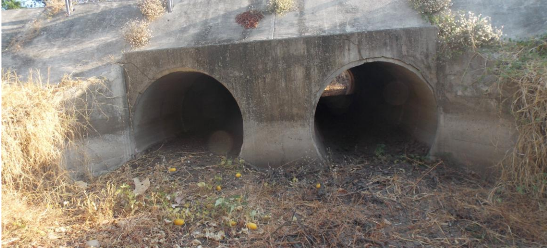
Figura 27: vista de la entrada, alcantarilla en est. 7+220
