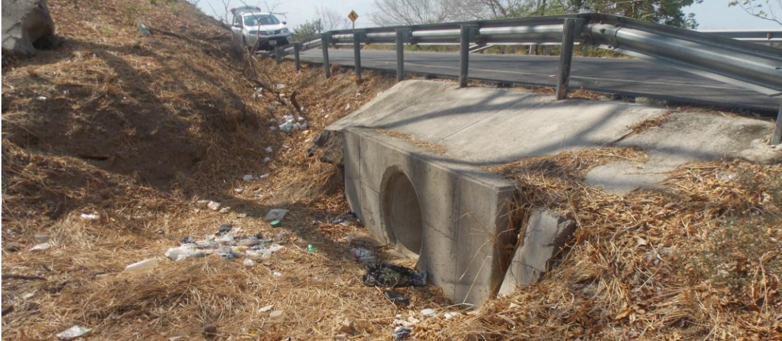
Figura 12: vista de la entrada, alcantarilla en est. 2+740
