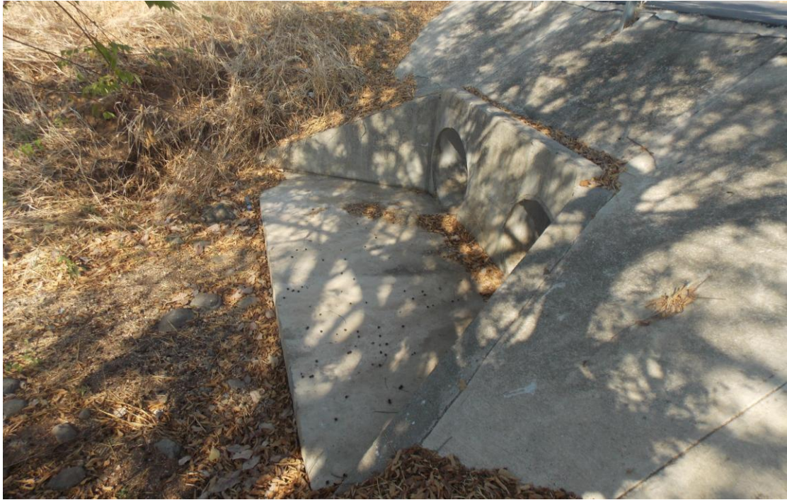
Figura 16: vista de la salida, alcantarilla en est. 3+980
