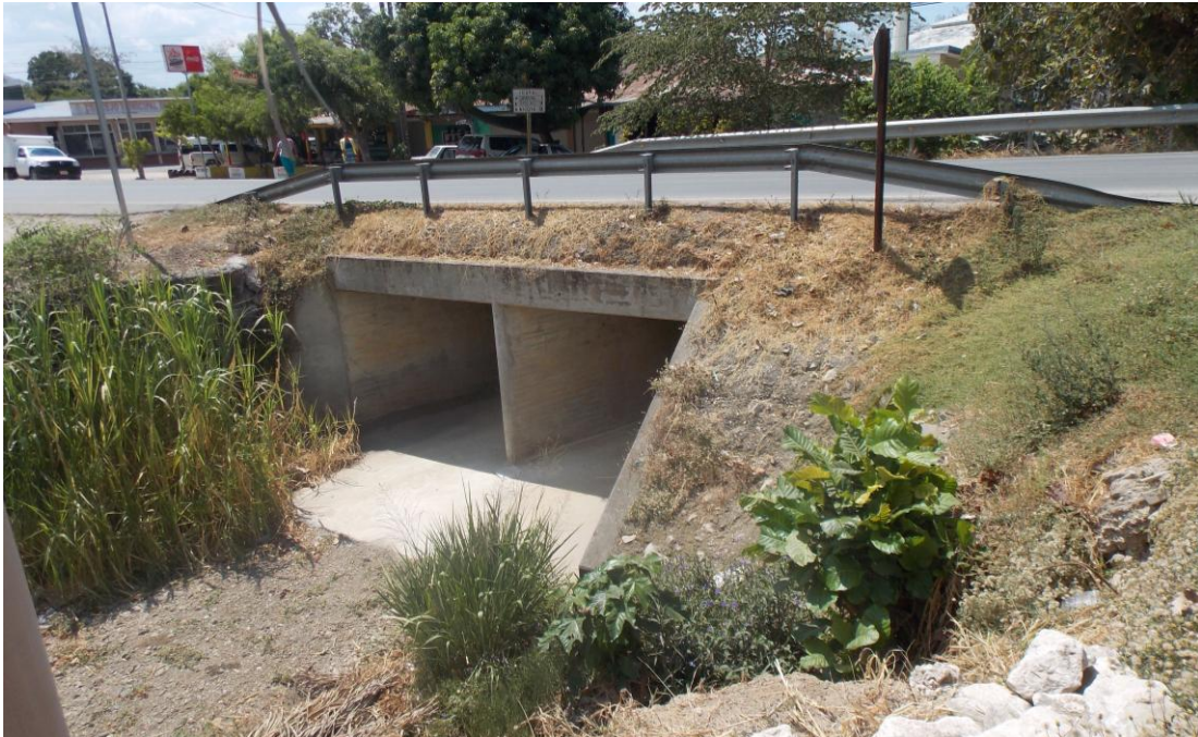
Figura 4: vista de la entrada, alcantarilla en est. 0+070
