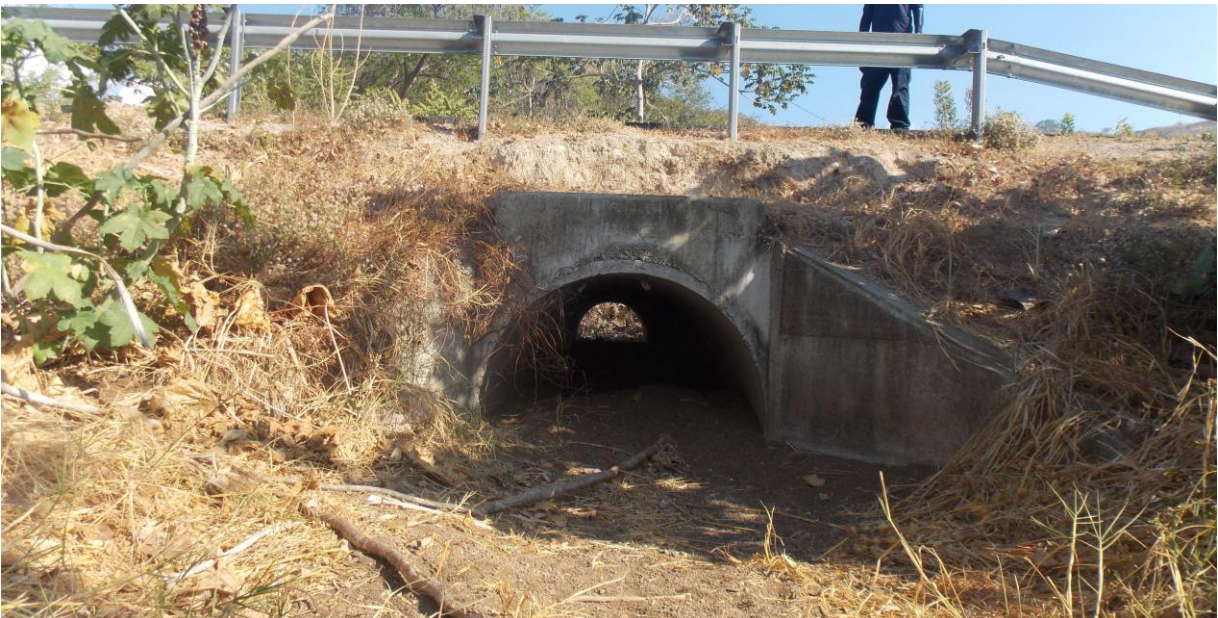
Figura 19: vista de la salida, alcantarilla en est. 4+580
