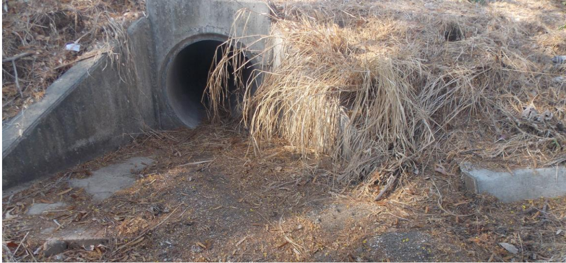
Figura 23: vista de la entrada, alcantarilla en est. 5+950
