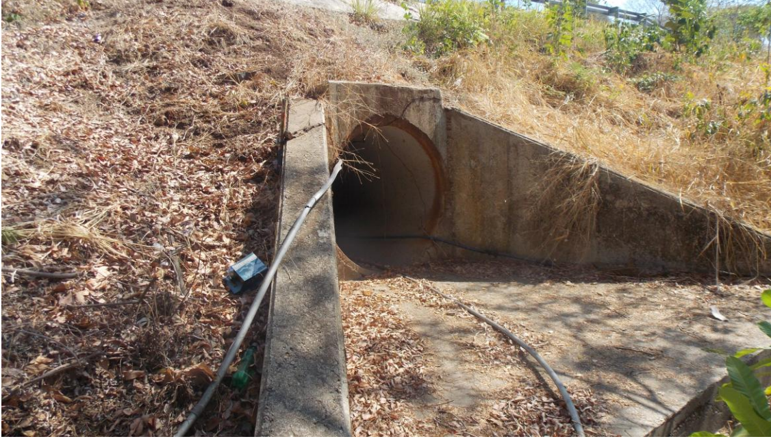
Figura 8: vista de la salida, alcantarilla en est. 1+880
