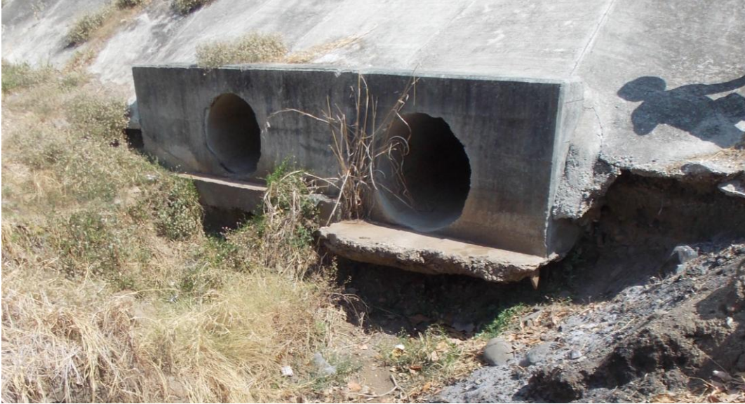
Figura 6: vista de la salida, alcantarilla en est. 1+070
