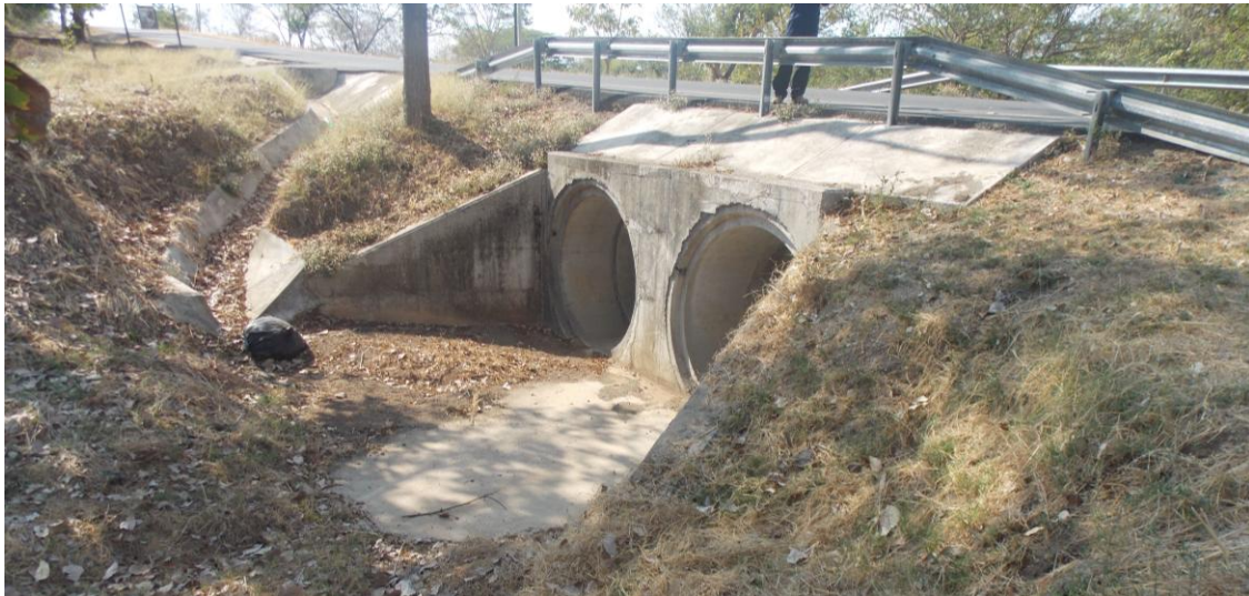
Figura 13: vista de la entrada, alcantarilla en est. 2+980
