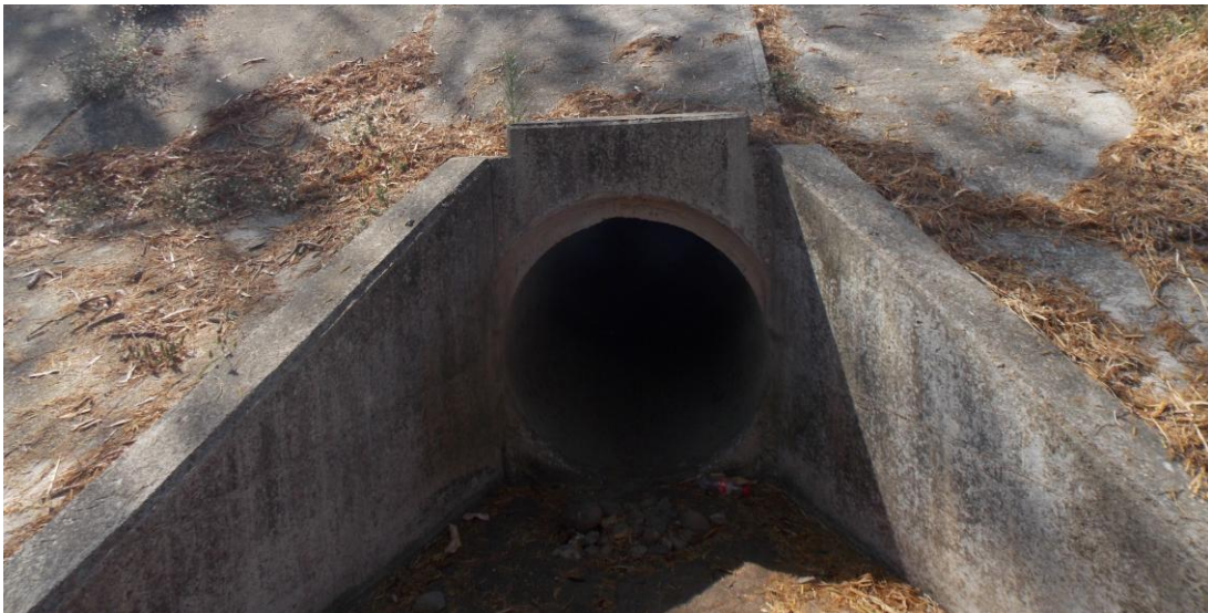
Figura 9: vista de la entrada, alcantarilla en est. 2+140
