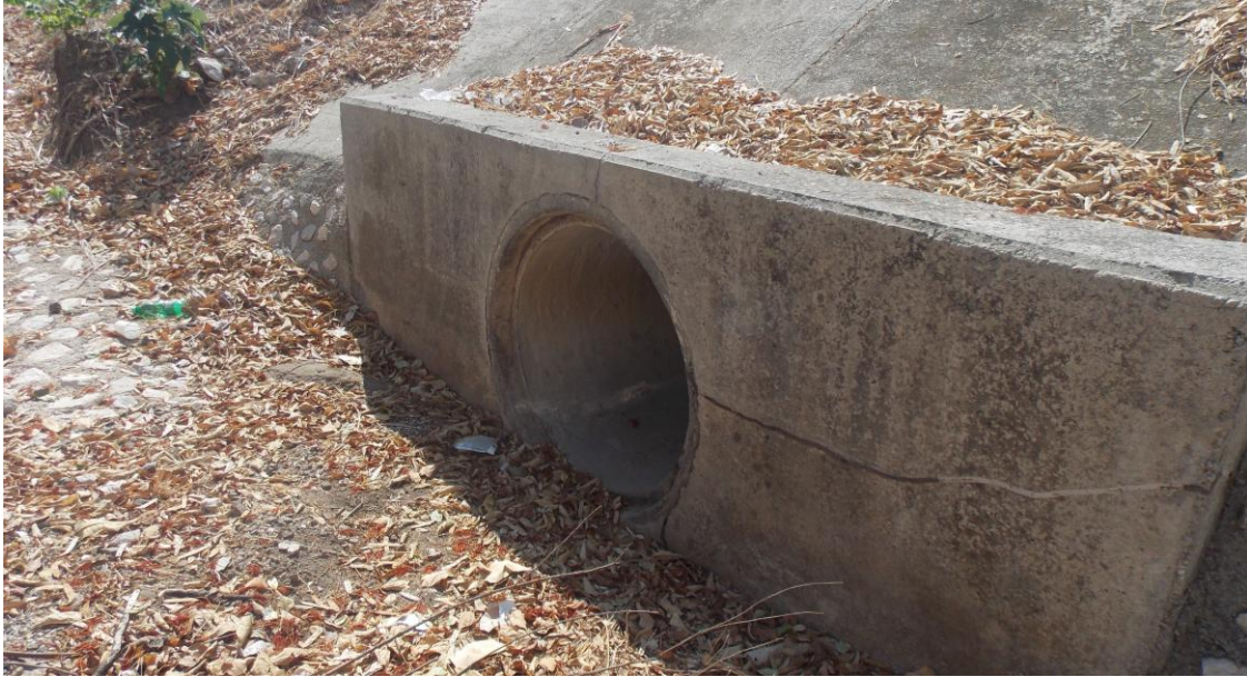
Figura 10: vista de la entrada, alcantarilla en est. 2+300
