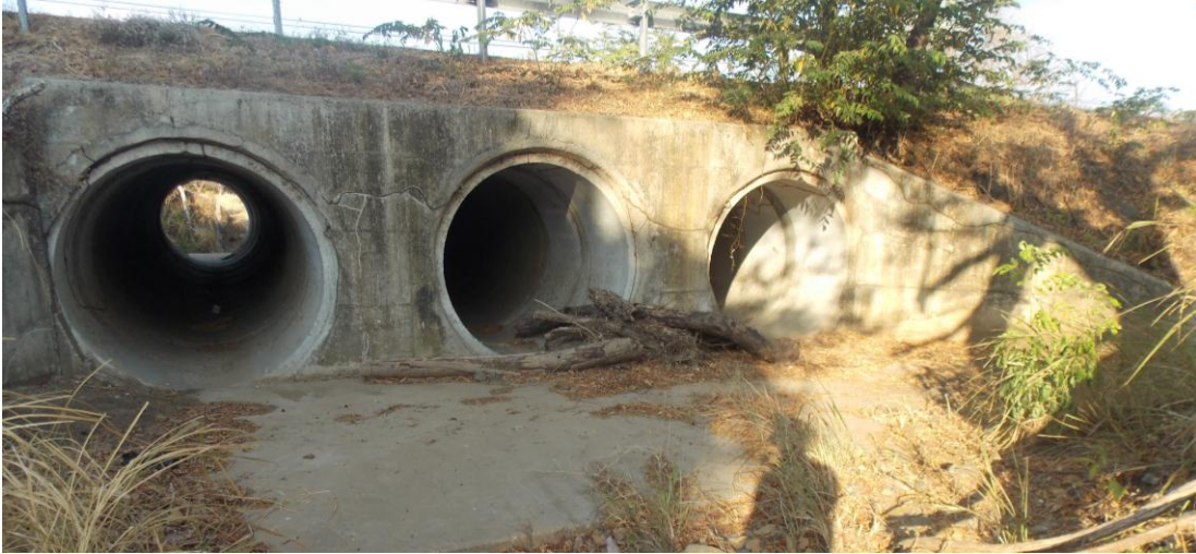
Figura 29: vista de la entrada, alcantarilla en est. 8+220
