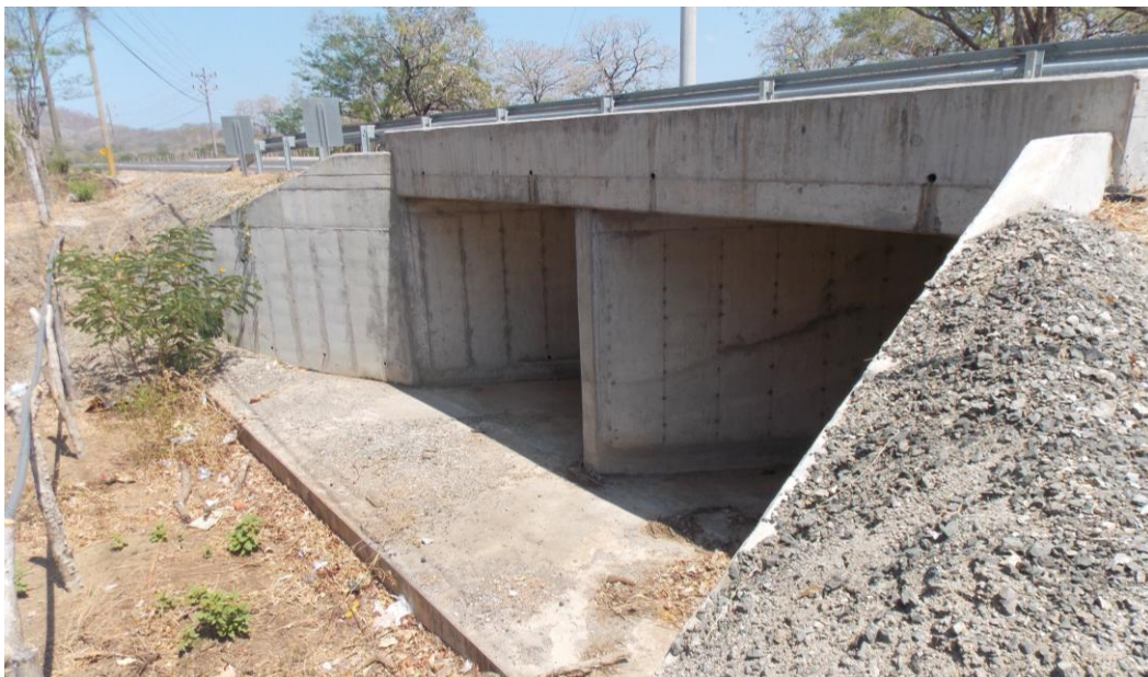
Figura 7: vista de la salida, alcantarilla en est. 5+200
