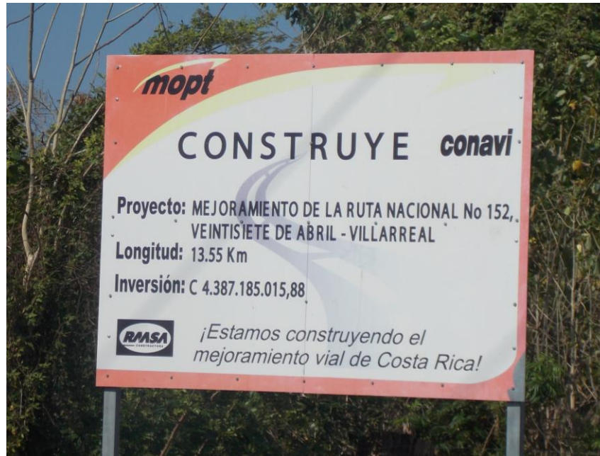
Figura 2: Cartel colocado a la entrada del proyecto.
