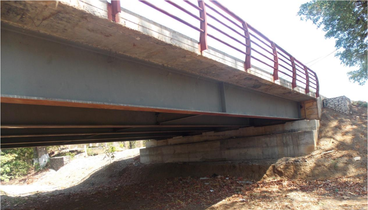
Figura 8: puente sobre la Quebrada Marcos, est. 6+730
