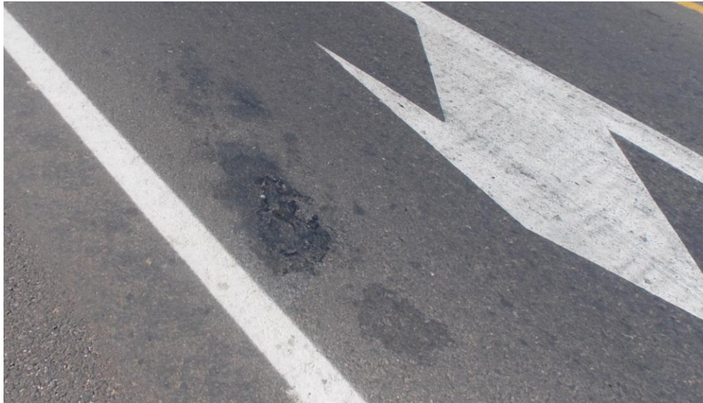
Figura 4: exudación en la carpeta, est. 13+100
