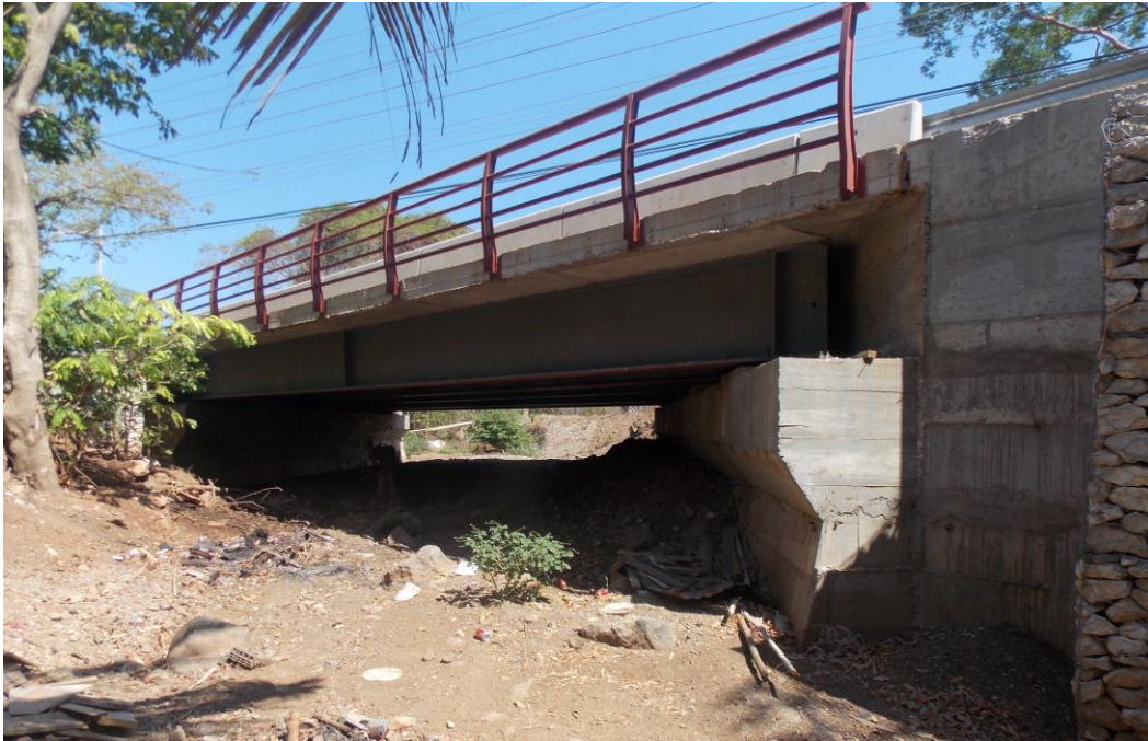
Figura 9: puente en el est. 9+900
