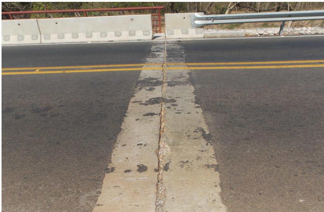
Figura 10: puente sobre el Río San Francisco, est. 10+700
