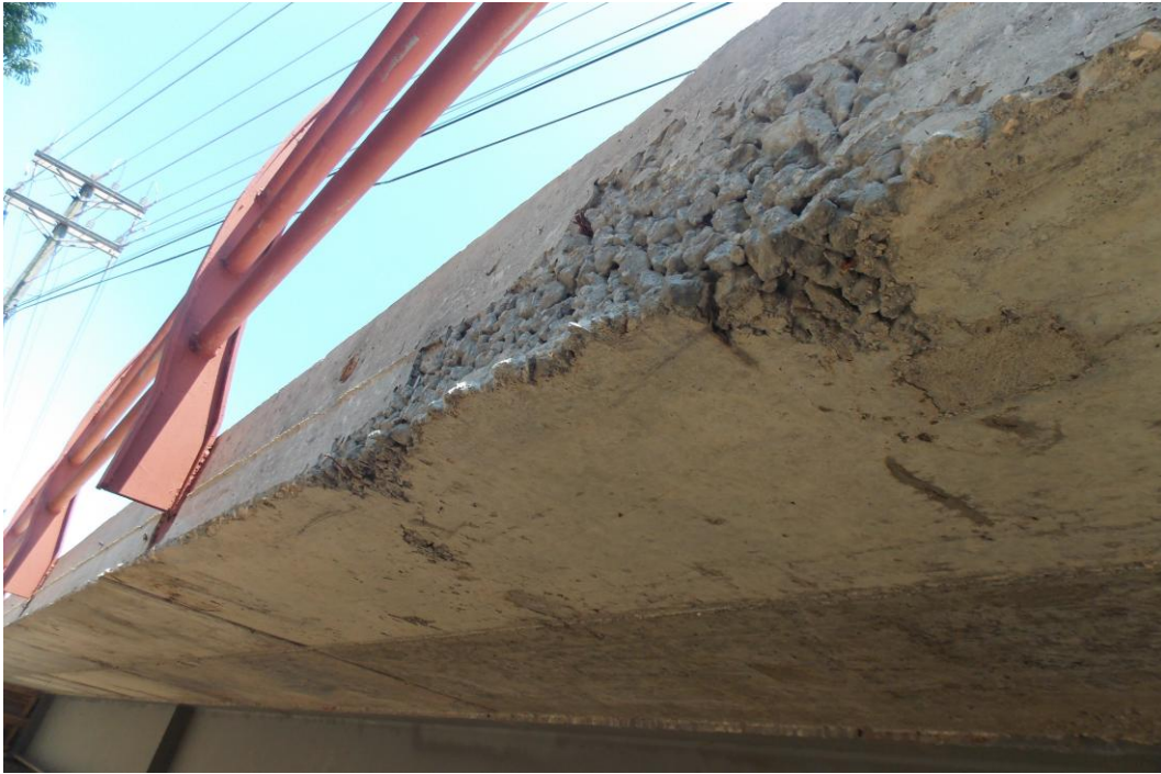
Figura 6: estado del concreto, puente en est. 2+760
