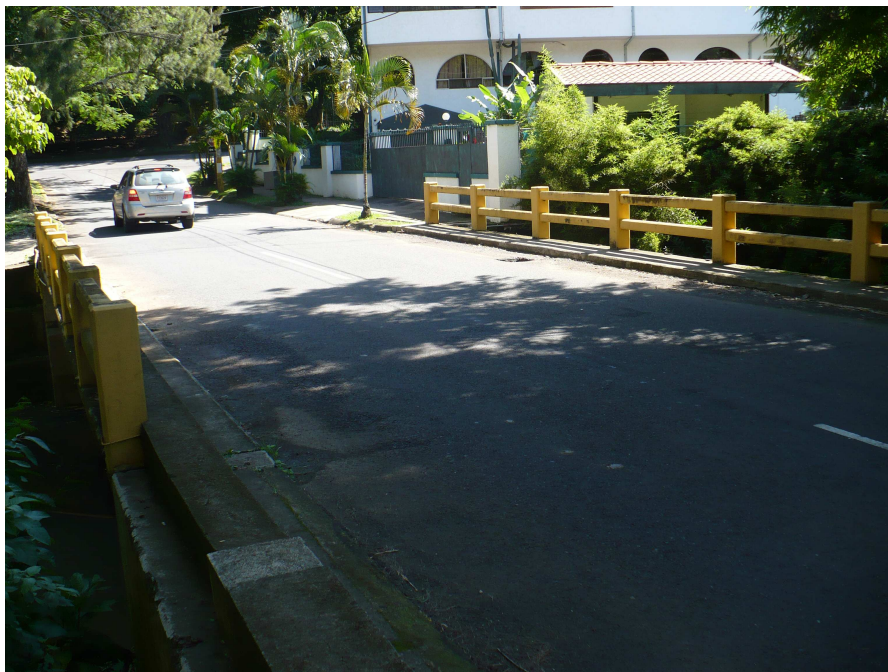
Figura 2. Vista frontal, hacia el Norte, del puente.
