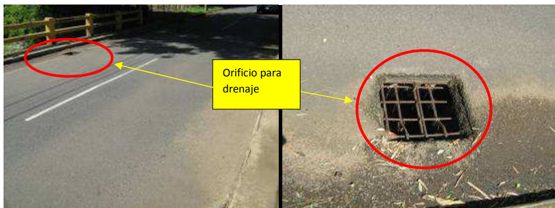
Figura 6. Orificio para drenaje, costado Este.
