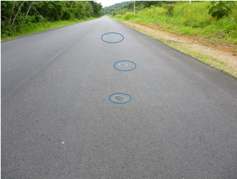
Figura 12. Reparaciones puntuales en el tramo intervenido de la Ruta Nacional N°34. Estacionamiento 5+400.
