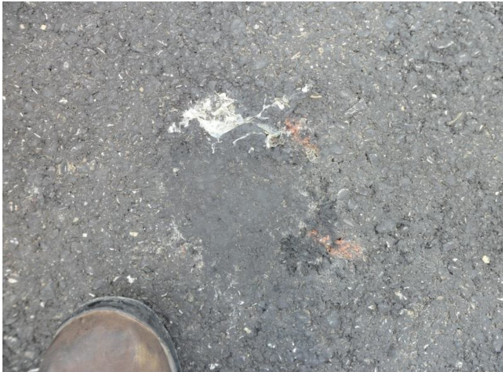
Figura 10. Ejemplo de un sitio donde se extrajo un núcleo en el tramo de la Ruta Nacional N°34. Estacionamiento 5+300.
