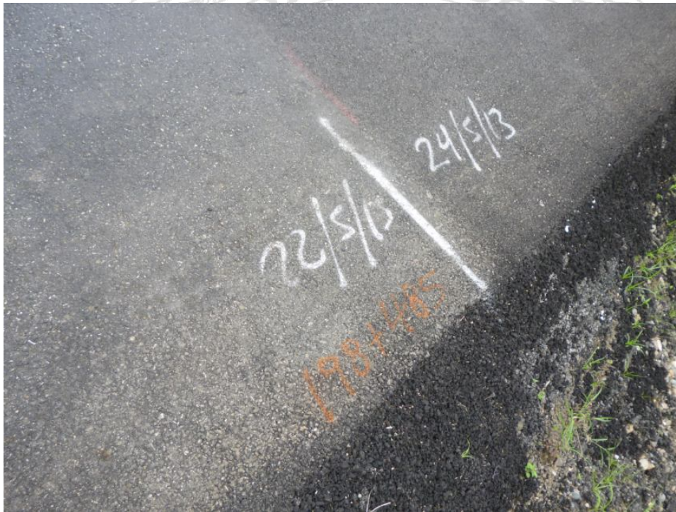
Figura 7. Fecha de colocación de la capa asfáltica en el tramo visitado de Ruta Nacional N°34, indicadas en la superficie. Estacionamiento 6+000.
