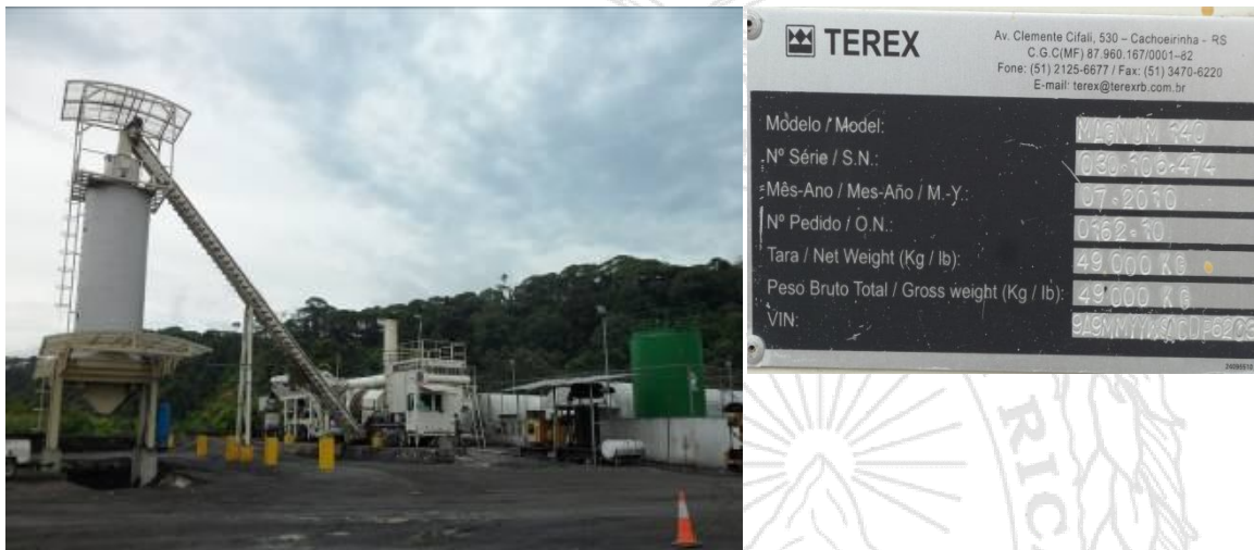
Figura 2. Planta de mezcla asfáltica ubicada en La Guaria de Osa, propiedad de Constructora Hernán Solís. Se muestra la placa donde se identifica la información del equipo.
