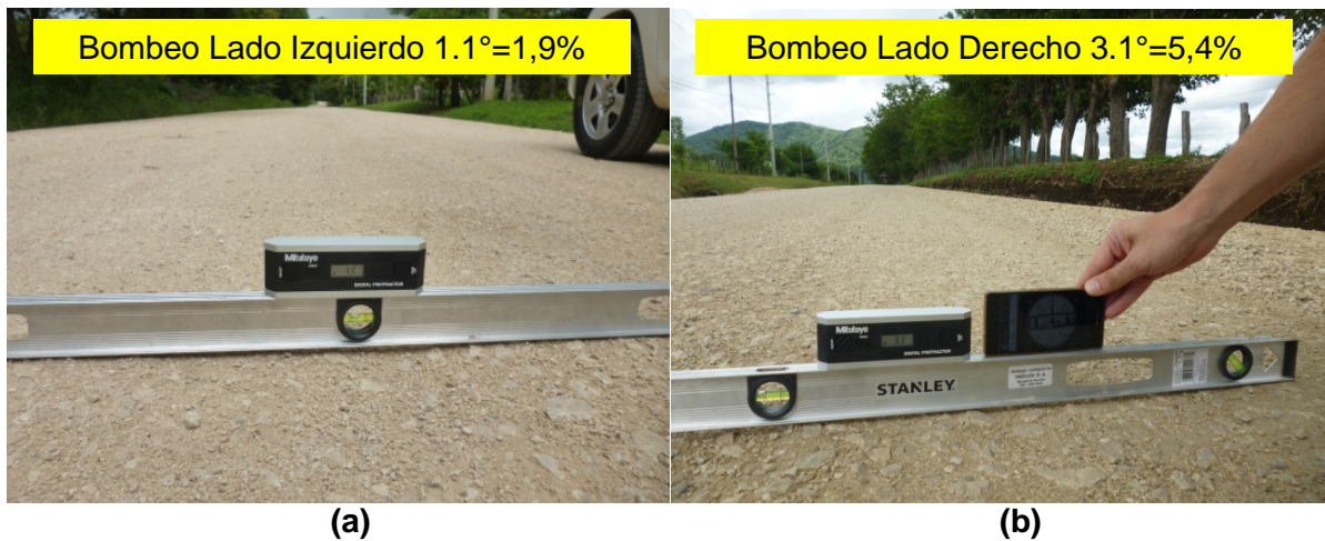
Fotografía 13. Pendiente transversal de calzada menor a 6%.
