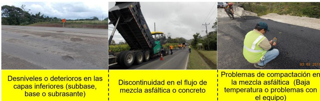
Desniveles o deterioros en las capas inferiores (subbase, base o subrasante)
