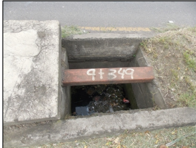
Figura No.14 Vista superior del pozo de registro 5, localizado en la medianera de la carretera.
