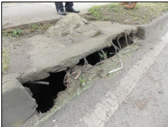
Figura No.7 Rejilla tragante y detalle del interior del cajón, tubería obstruida.
