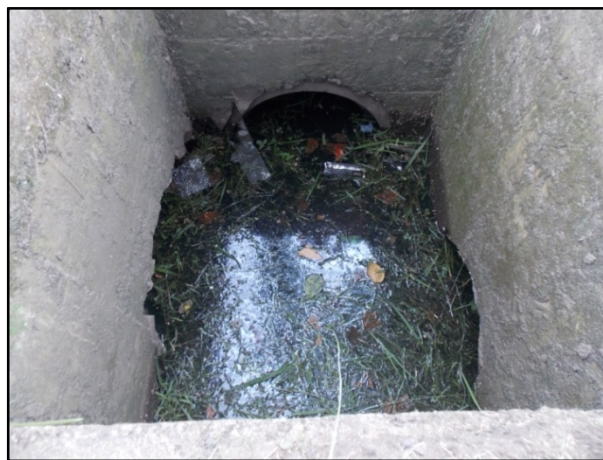
Figura No.15 Vista superior del pozo de registro 6, localizado en la medianera de la carretera. Se observa la convergencia de varias tuberías en este punto.
