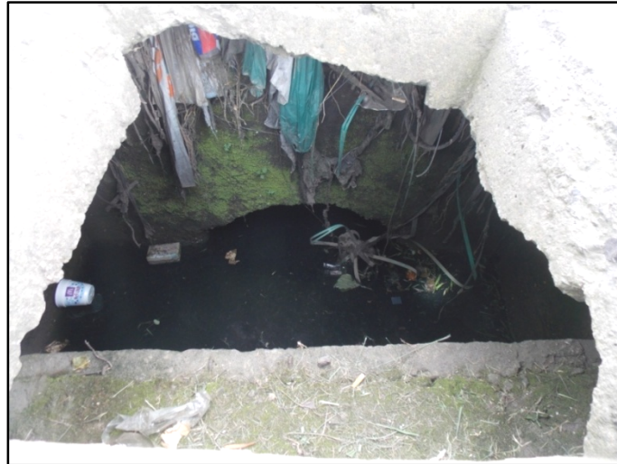
Figura No.2 Tragante y alcantarilla 1. Obstrucciones y basura impiden flujo libre del agua.
