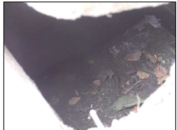
Figura No.7 Rejilla tragante y detalle del interior del cajón, tubería obstruida.
