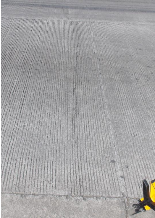
Figura A9: Grietas en borde losa, est. 0+115,2 y 0+146,2; sentido San Francisco – La Colina
