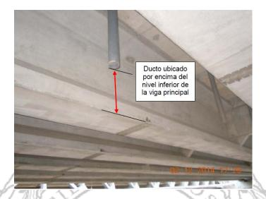
Figura 9. Ductos de drenaje en el puente sobre el Río Potrero. Fecha: 12/2/2014
