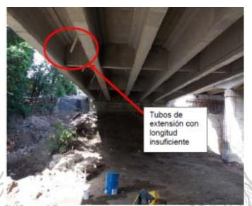
Figura 12. Ductos de drenaje en el puente sobre el Río Piedras. Fecha: 5/8/2014
