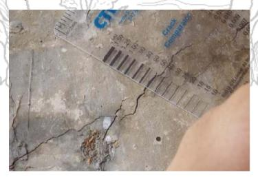
Figura 6. Medición de grietas en el Río Salto. Fecha: 6/8/2014
