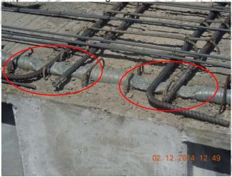
Figura 2. Aplastamiento de los ductos de postensión en las vigas del puente sobre el río Cañas. Fecha: 12/2/2014
