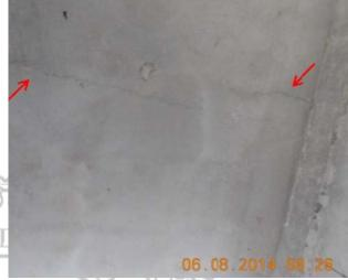
**Figura 7** Grietas diagonales en viga principal que inician en las esquinas de las aberturas para el mecanismo de anclaje del refuerzo de las vigas diafragma. Puente sobre el Río Arenas. Fecha: 6/8/2014
