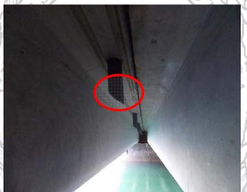
Figura 11. Ductos de drenaje en el puente sobre el canal de Riego Sur. Fecha: 5/8/2014
