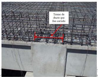
**Figura 3.** Corte de los ductos de postensión en las vigas del puente sobre el río Cañas. Fecha:26/2/2014
