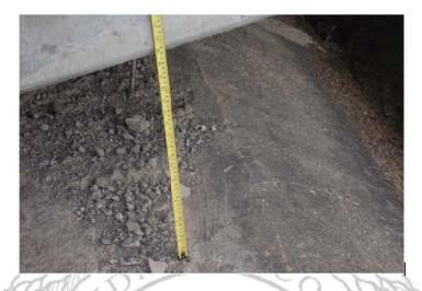
**Figura 13**. Medida de altura de cuerda inferior con respecto al revestimiento del canal. Fecha:5/8/2014
