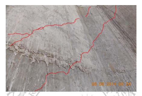
**Figura 5**. Agrietamientos en el bastión noroeste del puente sobre el Río Salto. Fecha: 6/8/2014
