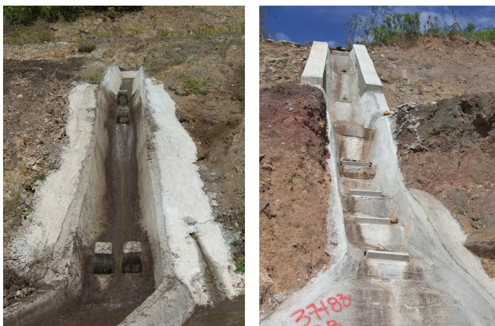
(a) Bloques disipadores en el relleno.
