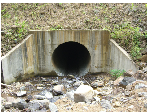
(a) Alcantarilla de 3,05 m de diámetro, quebrada Caño Grande.
