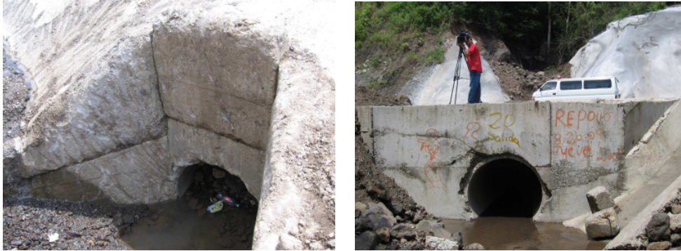
(a) Entrada de alcantarilla.
