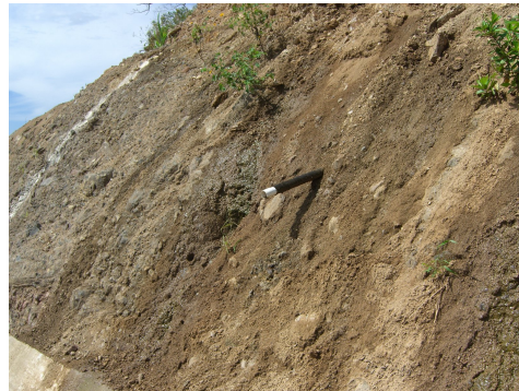
(b) Drenaje para disminuir la humedad en los taludes.
