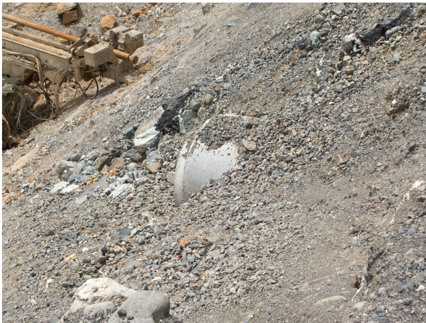
Figura 4.20: Salida de la alcantarilla.
