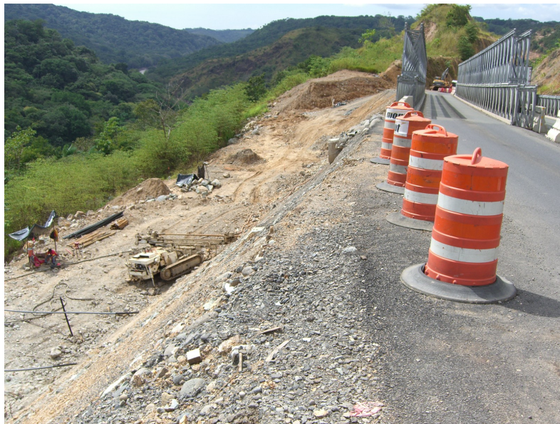
Figura 4.18: Vista del relleno del estacionamiento 46+800.
