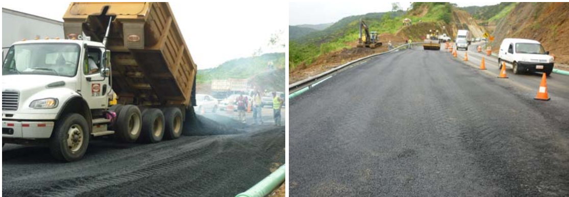
Fotografías 28 y 29. Nueva sobrecapa de mezcla asfáltica, kilómetro 46+800. 25 de Setiembre 2010. Fuente: Supervisora CACISA-Cano Jiménez.
