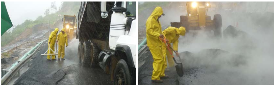
Fotografías 33, 34, 35 y 36. Nueva colocación de mezcla asfáltica. Este día se colocó con lluvia, kilómetro 46+800. 29 de Setiembre 2010. Fuente: Supervisora CACISA-Cano Jiménez.
