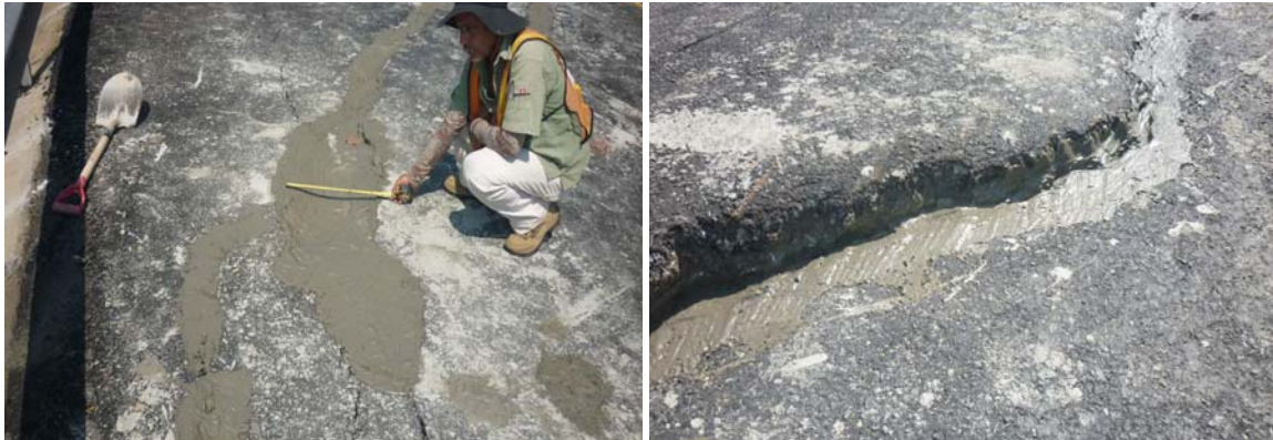
Fotografías 17 y 18. Inyección de lechada de concreto hidráulico, kilómetro 46+800. 22 de Setiembre 2010. Fuente: Supervisora CACISA-Cano Jiménez.
