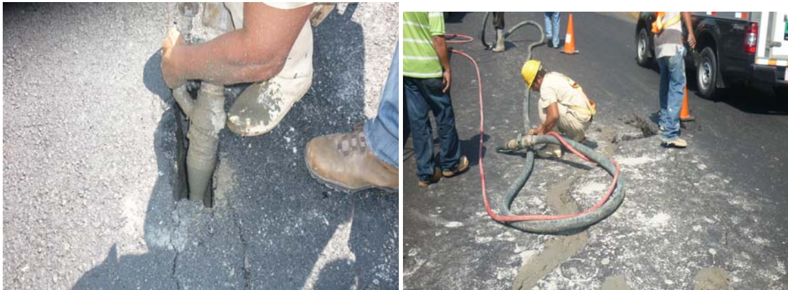
Fotografías 15 y 16. Inyección de lechada de concreto hidráulico, kilómetro 46+800. 22 de Setiembre 2010. Fuente: Supervisora CACISA-Cano Jiménez.
