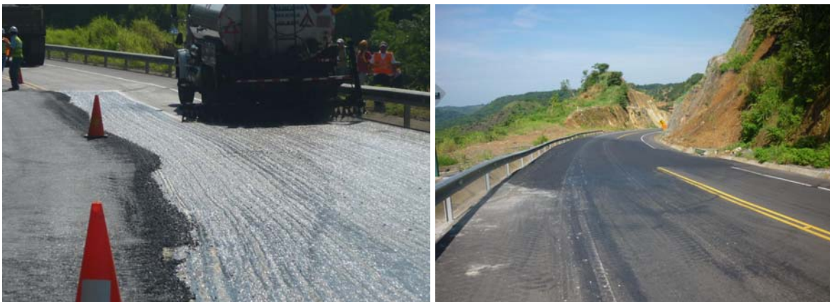
Fotografías 6 y 7. Colocación de mezcla asfáltica sobre la zona en movimiento, kilómetro 46+800. 11 de Setiembre, 2010. Fuente: Supervisora CACISA-Cano Jiménez.
