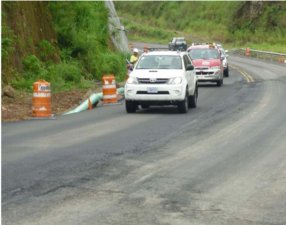
Fotografía 26. Rehabilitación del paso de vehículos luego de la nueva sobrecapa colocada, kilómetro 46+800. 24 de Setiembre 2010. Fuente: Supervisora CACISA-Cano Jiménez.
