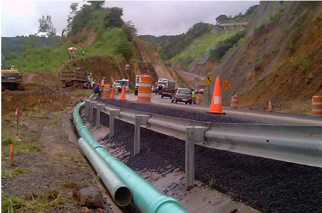
Fotografía 30. Espesor de la sobrecapa de mezcla asfáltica colocada hasta este momento, kilómetro 46+800. 25 de Setiembre 2010. Fuente: Supervisora CACISA-Cano Jiménez.
